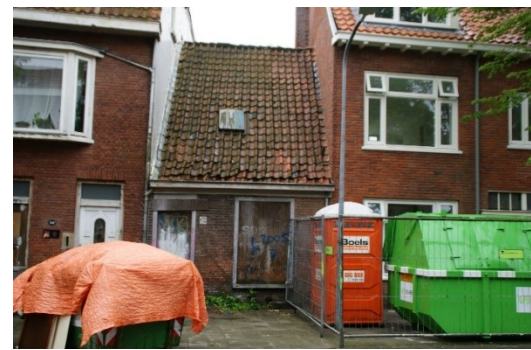
De woning/berging aan de Bakkerstraat is een voorbeeld waarbij het niet goed gegaan is. Ymere heeft de woningen gerenoveerd. Het naastliggende pand van de gemeente is niet meegenomen (foto). Beide partijen zijn het erover eens dat dit voorkomen moet worden in de toekomst.
