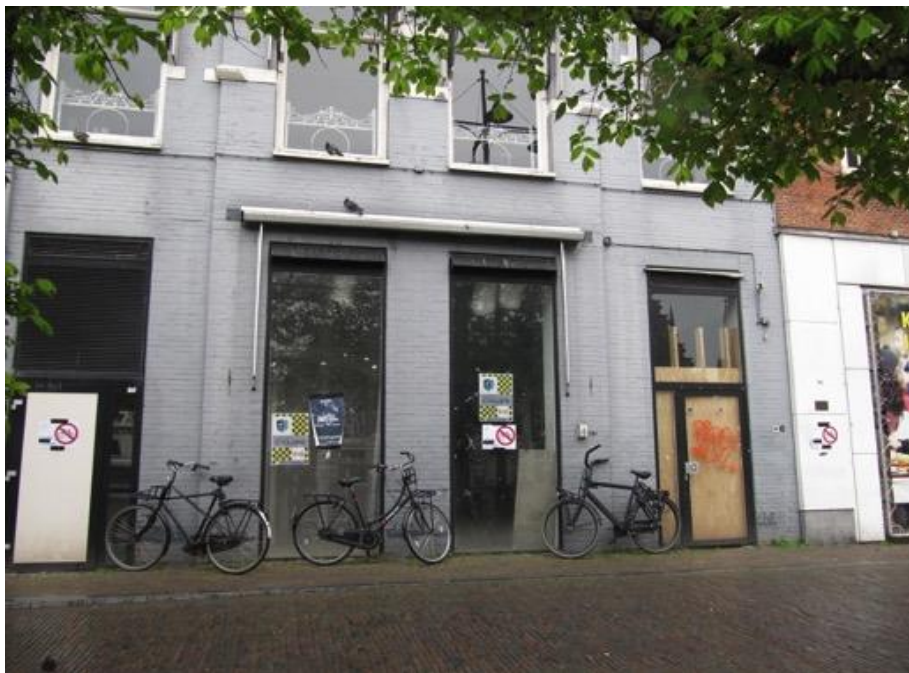
Afbeelding 13. Grote Markt. Spelregel 9: toegangen zijn verticaal geleed, maar behoren ook architectonische kwaliteit met bijbehorende verfijnde detaillering te bezitten, evenals voorzien te zijn van een kozijn en basisplint.
