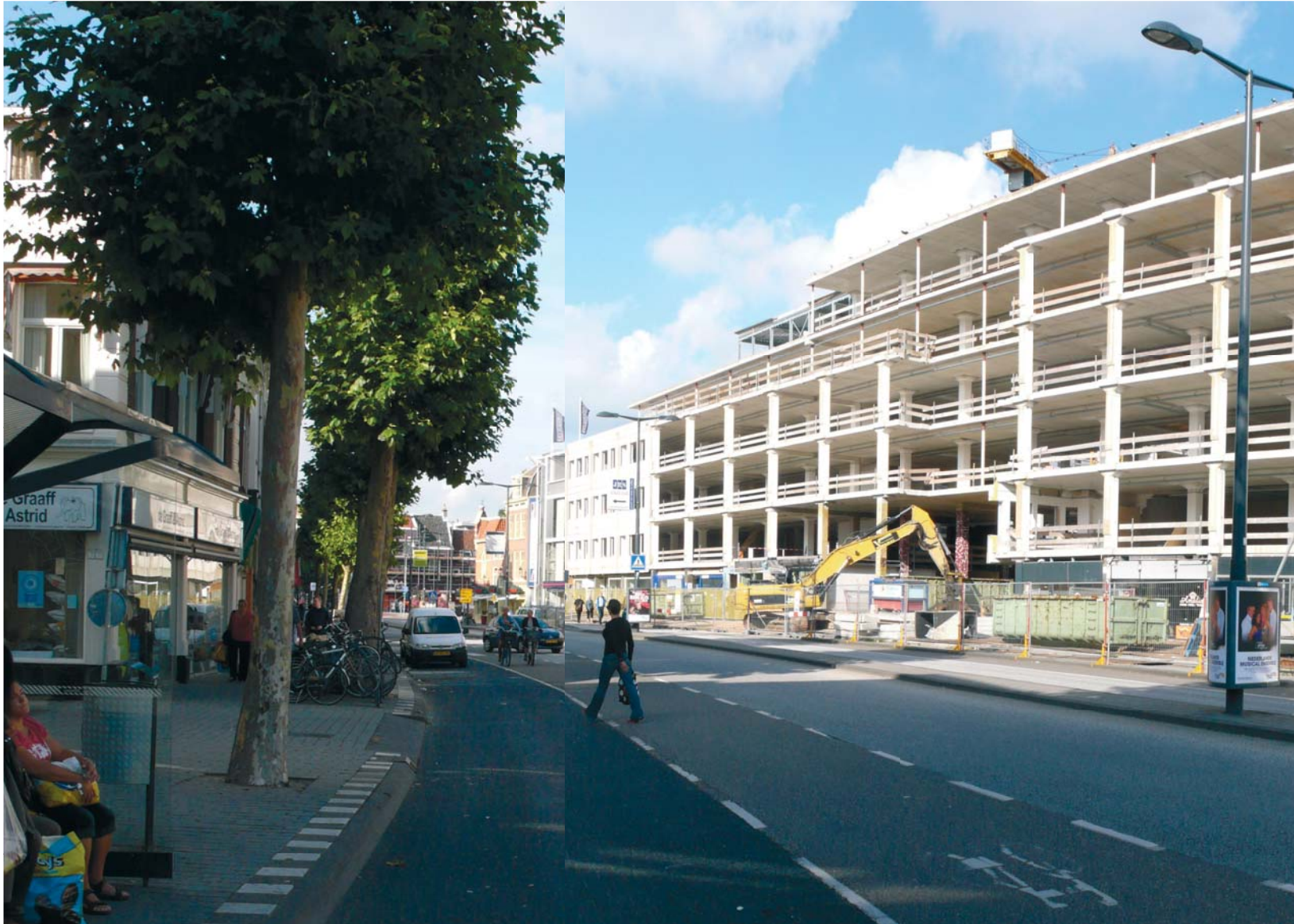
Zicht over het Houtplein richting Provinciehuis - 2011
