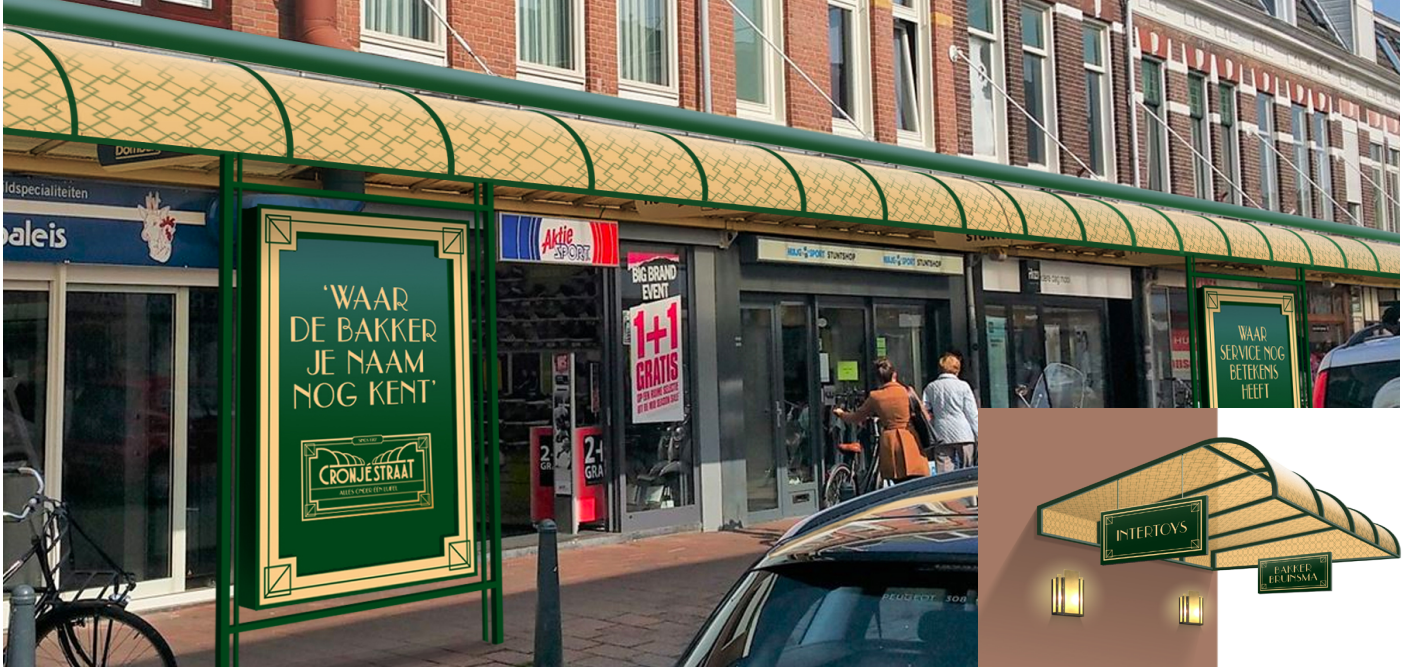
Impressie resultaat renovatie luifels
