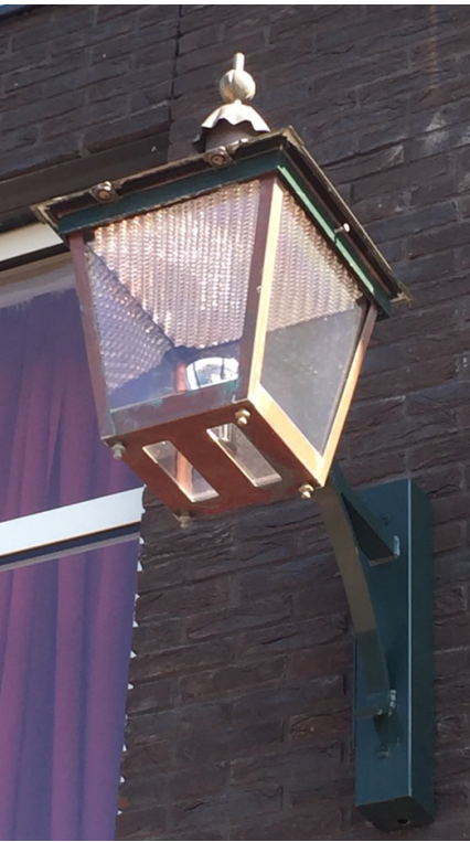
Armatuur Bakenes aan de gevel
