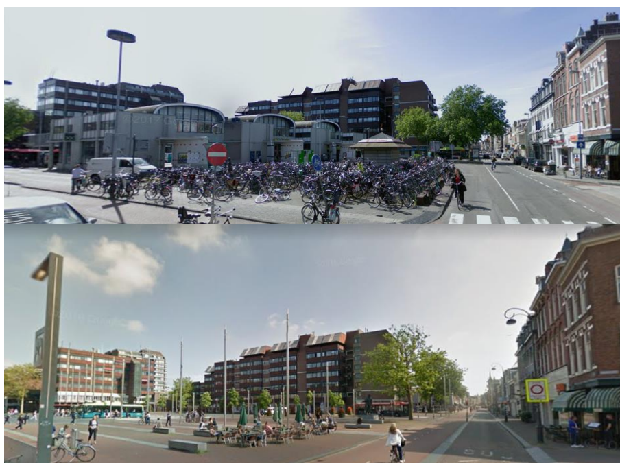
Figuur 3.2: De situatie voor openstelling van de stationsgarage (boven) en na 2014 (onder)
