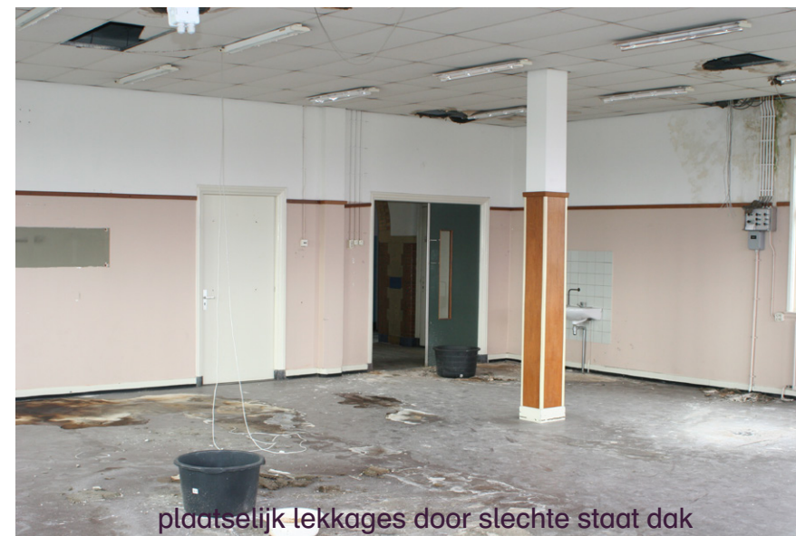
waterschade als gevolg van lekkage
