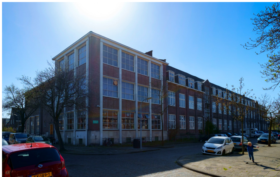
karakteristieke aanbouw uit jaren '50
