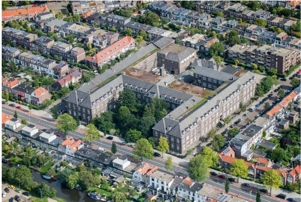
Figuur 2.1: perceel gezien vanaf de Verspronckweg. Bron: www.cod.nl
