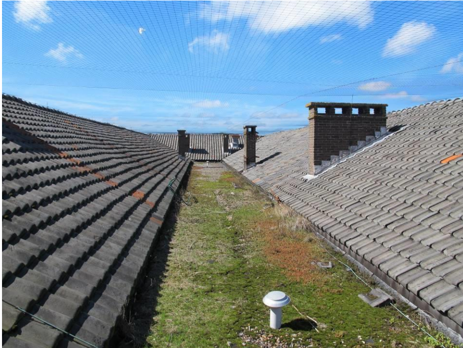
Zicht op het als platdak uitgevoerde middendeel van de westelijke delen van beide voorvleugels, met hier nog diverse oorspronkelijke ventilatiekanalen.
