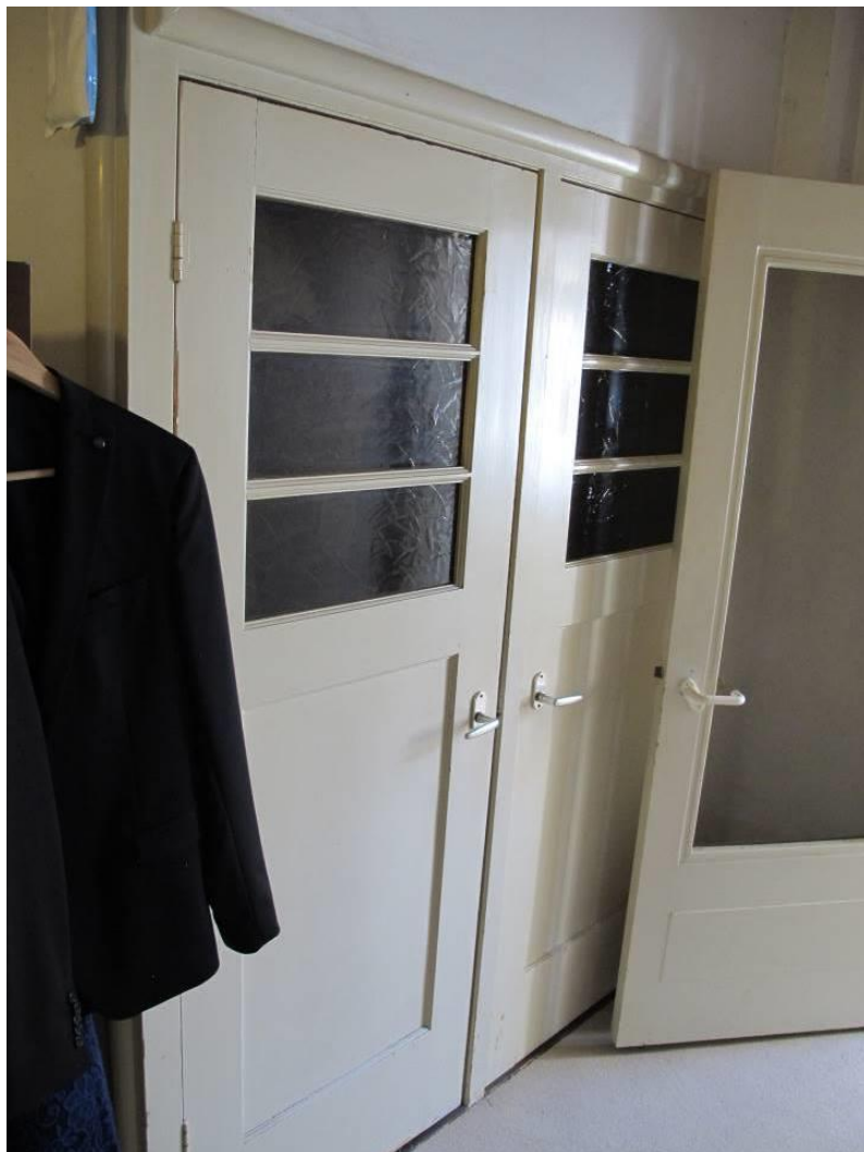
Vermoedelijk in 1922 toegevoegde kastdeuren in de linker achterhoek van de gang op de begane grond.
