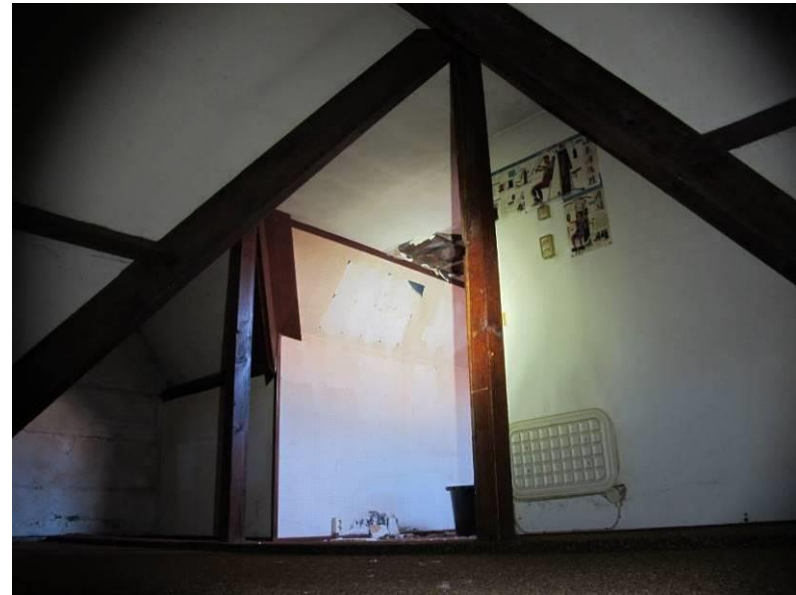
Kapconstructie, zichtbaar boven de verdieping van Brakenburghstraat 2.
