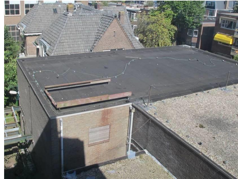
De naar het binnenterrein gerichte gevels van het materiaallab, gezien vanuit de rechter zijvleugel.
