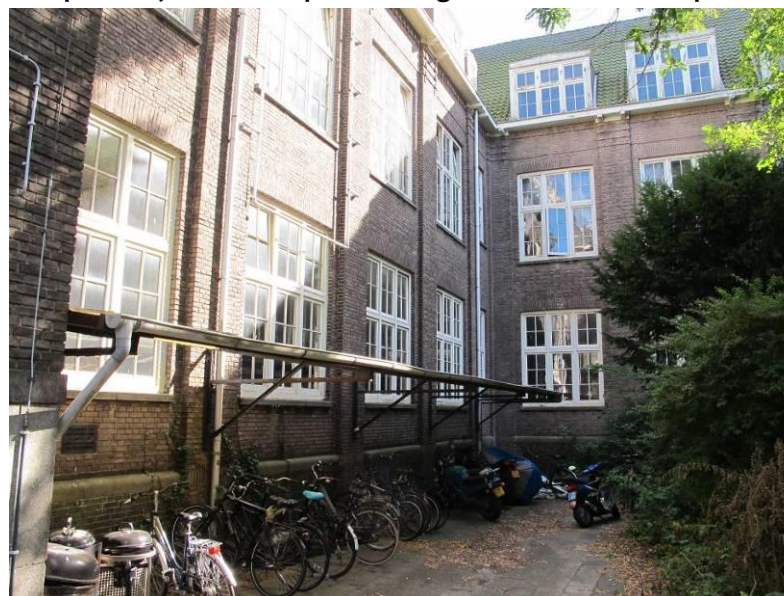
Aan de voorgevel aangebouwd afdak t.b.v. stalling van fietsen.
