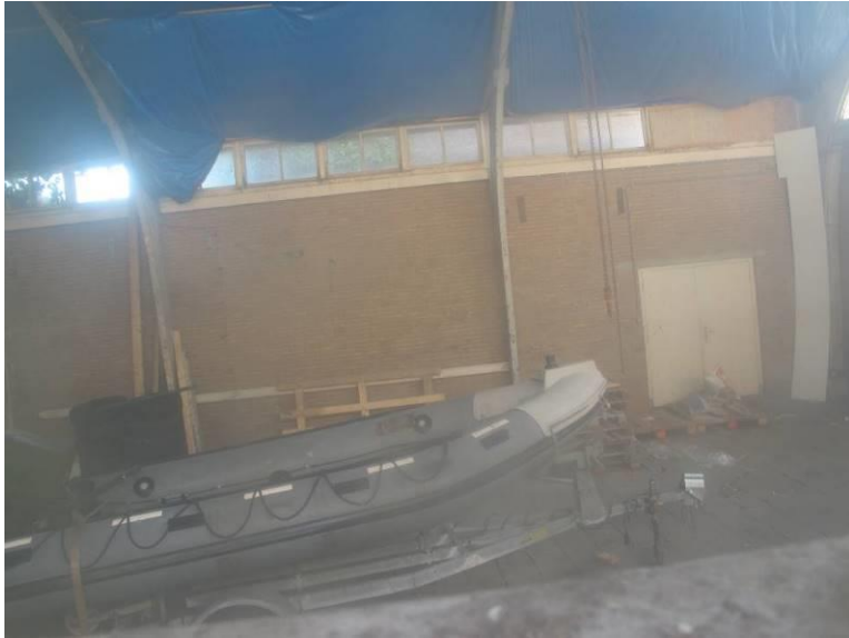
Interieur van de stellloods, gezien richting de zijmuur van de houtstek.
