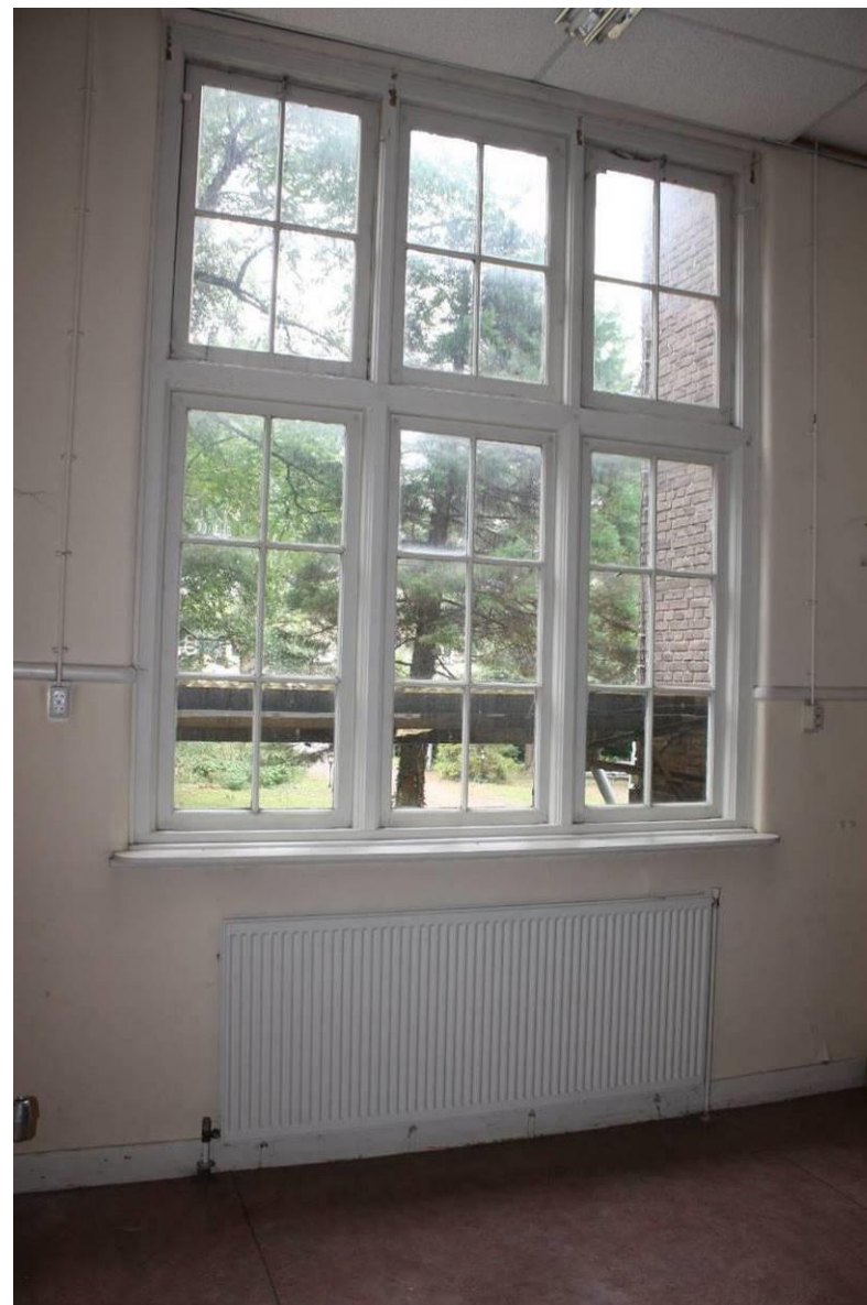
Beeld van de sobere oorspronkelijke vensterbanken en afgeronde dagkanten, zoals algemeen toegepast.
