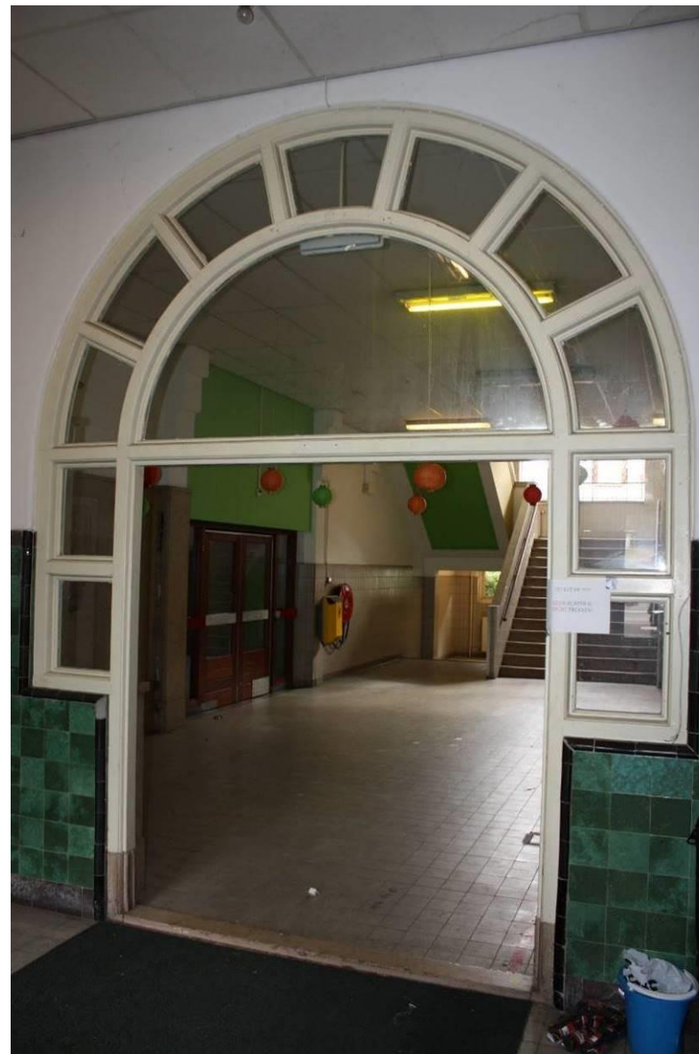
Oorspronkelijke tochtput tussen de vestibule en de centrale hal.
