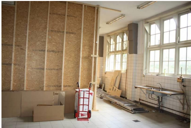
Interieurbeeld begane grond, met door plaatmateriaal afgescheiden ruimte.
