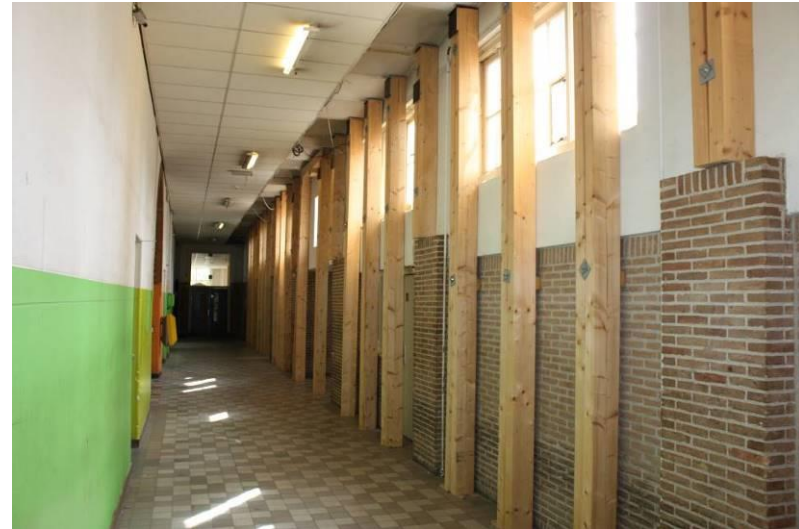
Gang binnen het oostelijke deel van de begane grond. De vensters in de rechter wand zijn omgevormd tot bovenlichten bij de aanbouw van de entree en garderobe in 1958. De balken zijn aangebracht vanwege de slechte bouwkundige conditie van deze gevel.
