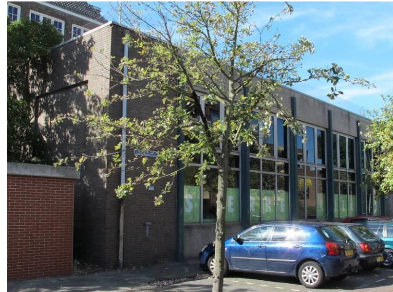
Overzicht van de oostgevel van de gymnastiekzaal en het aansluitende deel van de zuidgevel.
