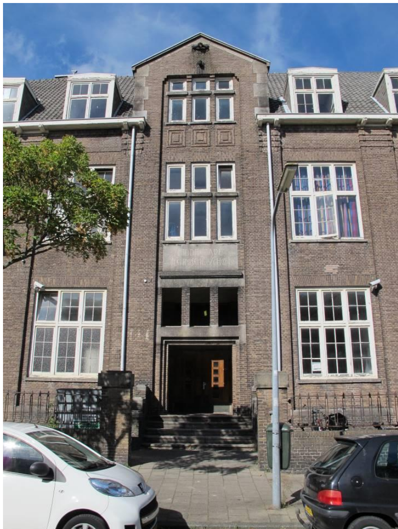
Overzicht van de in de westgevel gesitueerde entreepartij.
