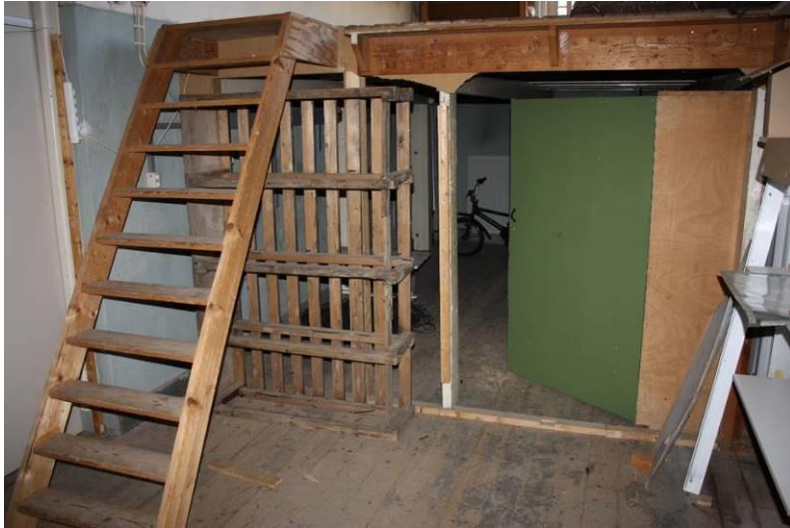
Interieur opslagruimte in de noordelijke travee van de verdieping.
