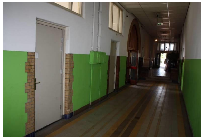
Middengang in het westelijke deel van de linker zijvleugel.
