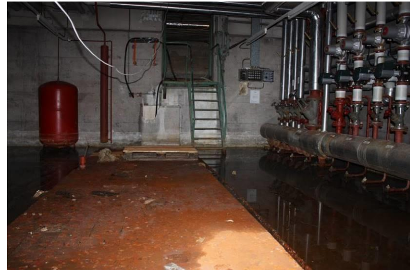
Oorspronkelijke stookruimte naast centraal trappenhuis onder voorvleugel. Deze ruimte sluit aan op de tegen de achtergevel gebouwde schoorsteen.
