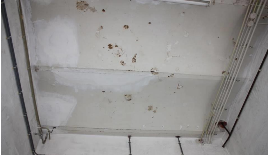
Zicht op de gemetselde gewelfjes, zoals deze oorspronkelijk boven de gangen in het zicht lagen, maar thans grotendeels door systeemplafonds aan het zicht worden onttrokken.
