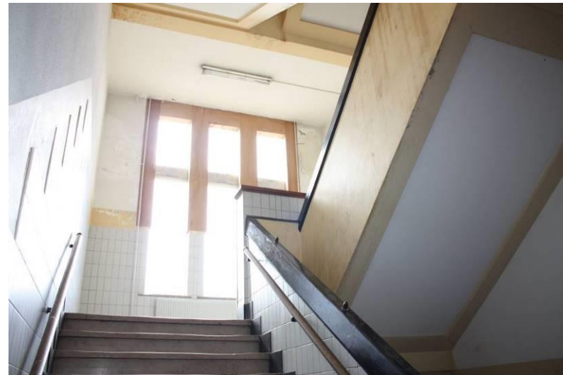
De neventrappenhuizen naast de zuidgevel hebben naast de traptreden ook de leuningen en detaillering van de balustrades behouden. Het tegelwerk is hier echter volledig vernieuwd.
