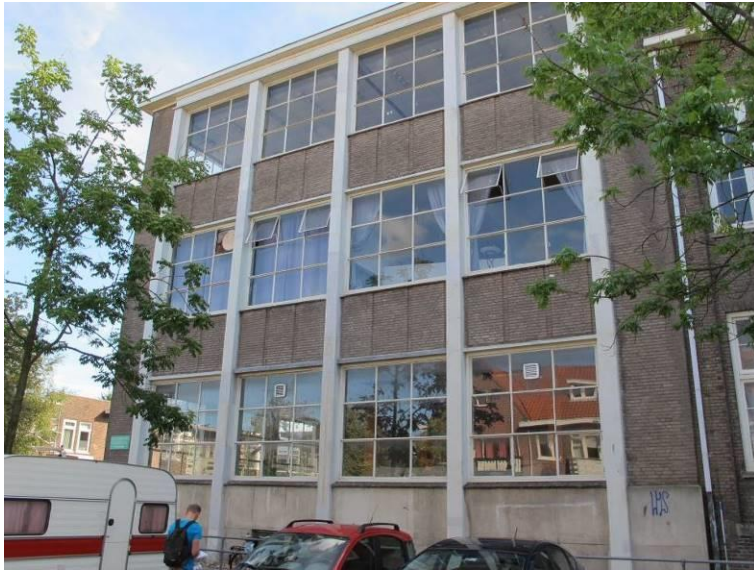
Overzicht van de noordgevel van bouwdeel E.
