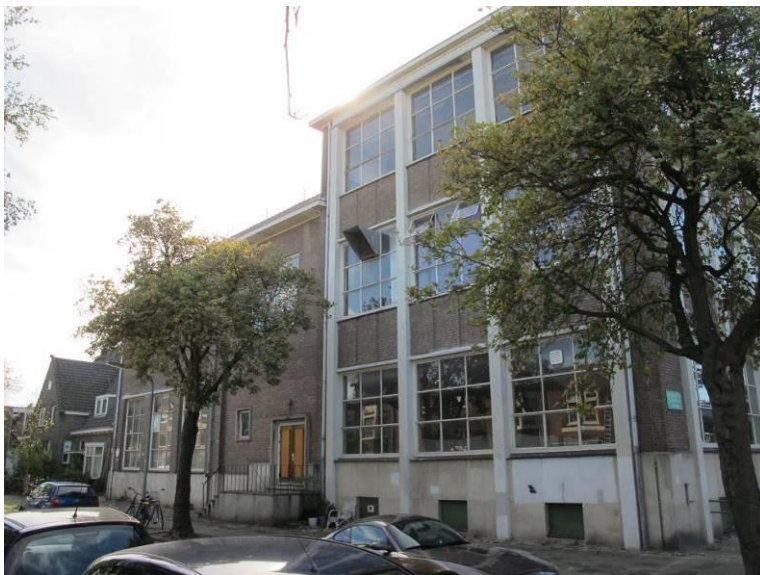
De oostgevel van bouwdeel E.
