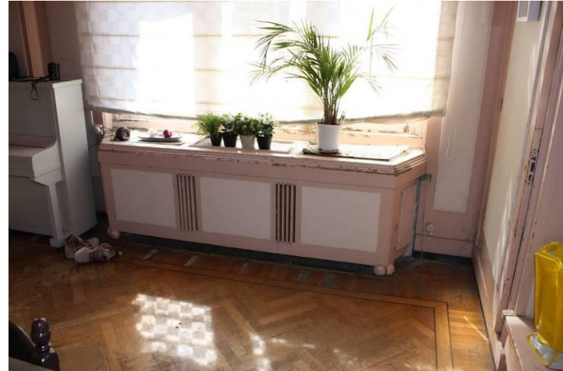
Radiatoromkasting en detail van de parketvloer.
