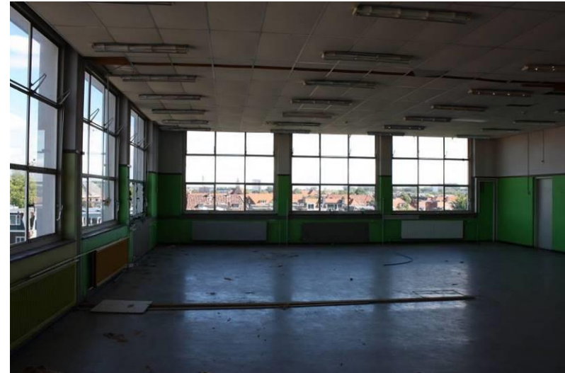
Lokaal aan de noordzijde van de tweede verdieping.
