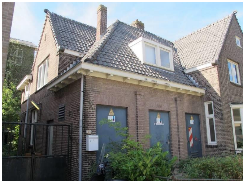
Voorgevel van nummer twee met de later ingevoegde stalen deuren t.b.v. de transformatorruimte.
