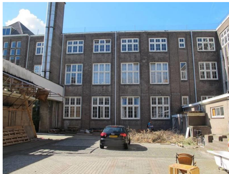
Rechter (noordelijk) deel van de achtergevel van de voorbouw.
