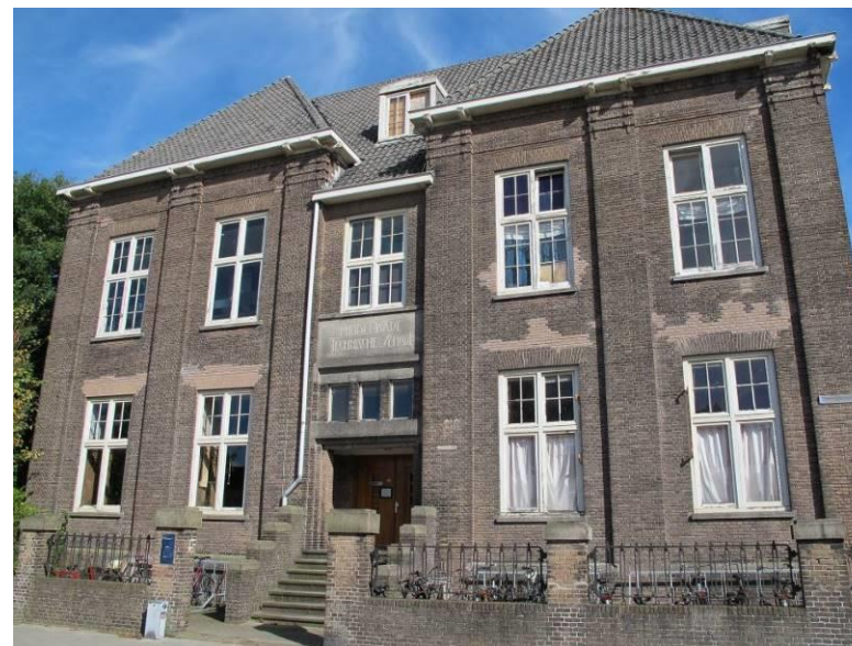
Overzicht westelijke kopgevel van de rechter zijvleugel.
