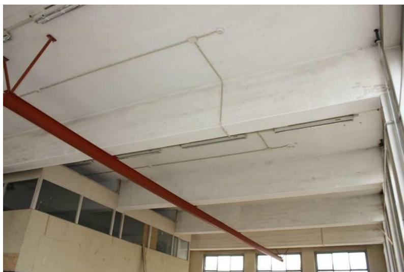
Zware betonbalken boven het zuidelijke deel van de begane grond.
