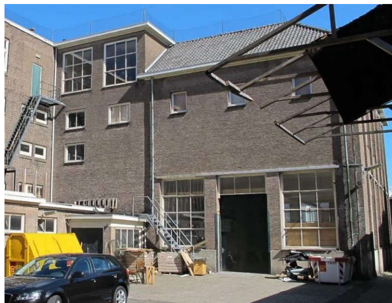
De westgevel van bouwdeel E met links, aansluitend op de linker zijvleugel, het hogere deel onder een platdak.
