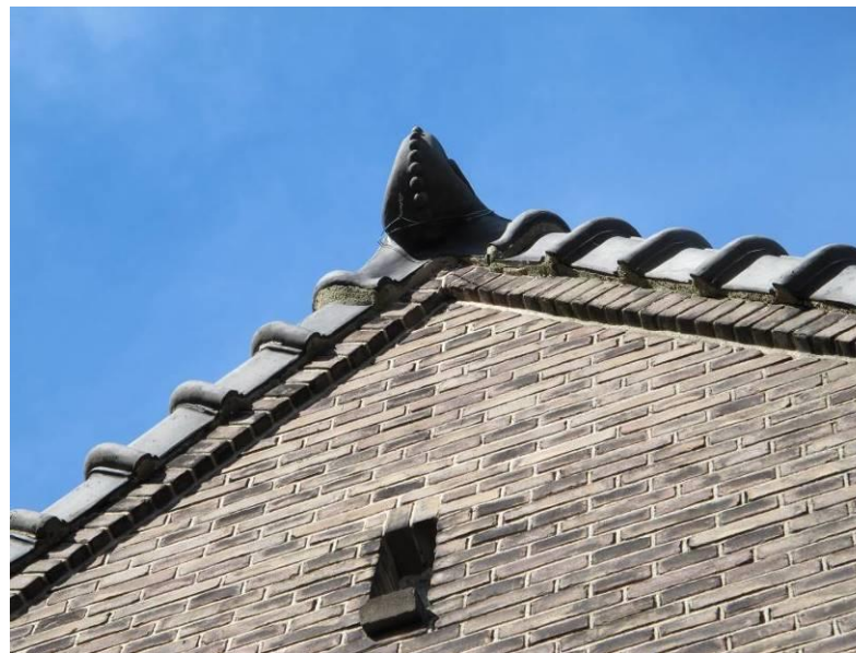
Nok beëindiging boven de zuidgevel, met een siervorst.
