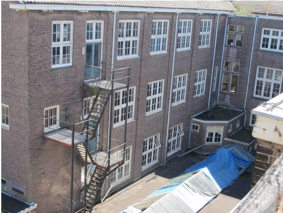
Overzicht van de westgevel van de dwarsvleugel.
