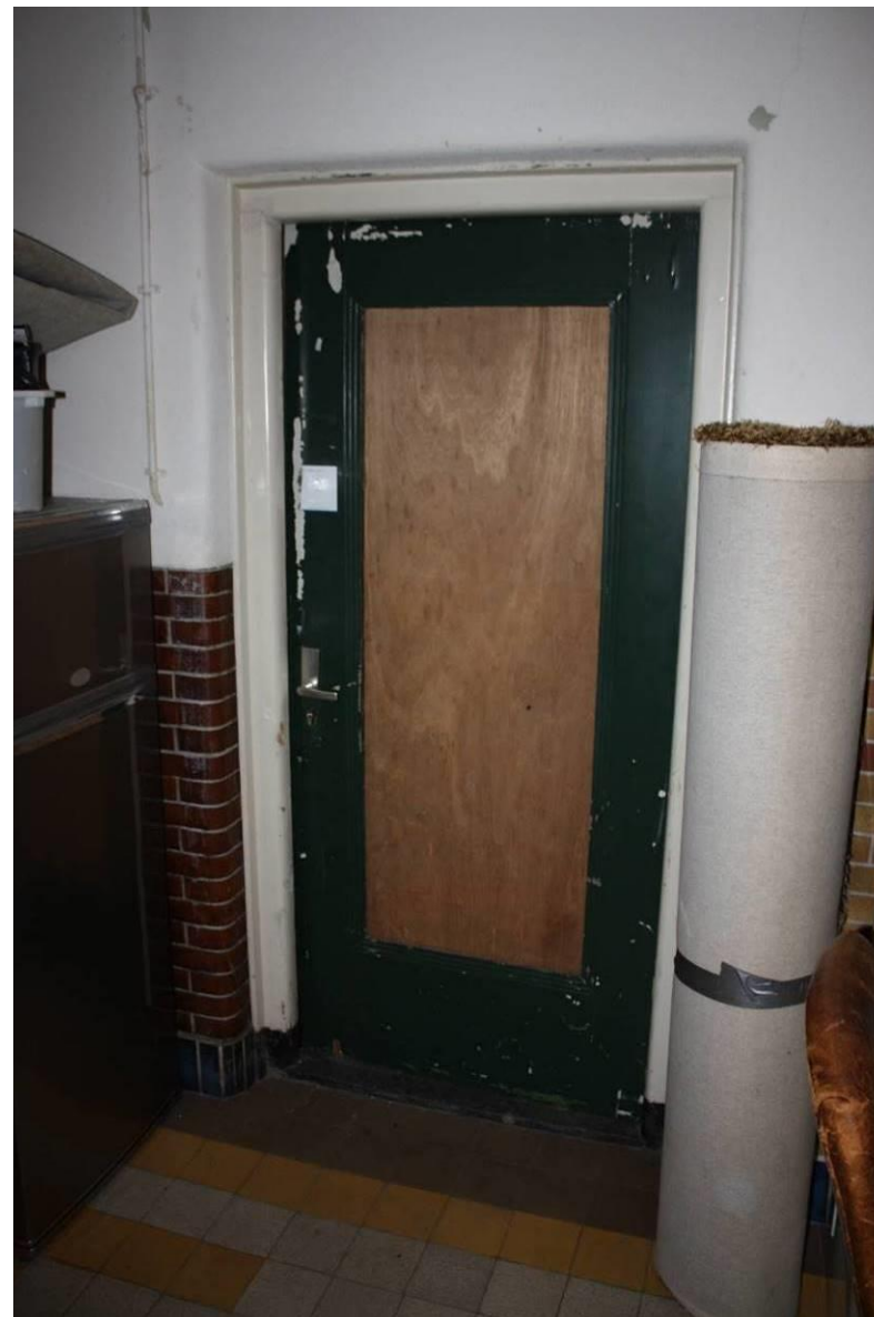
Oorspronkelijke toegangsdeur tot de bestuurskamer. Het middenveld is afgeplaat.
