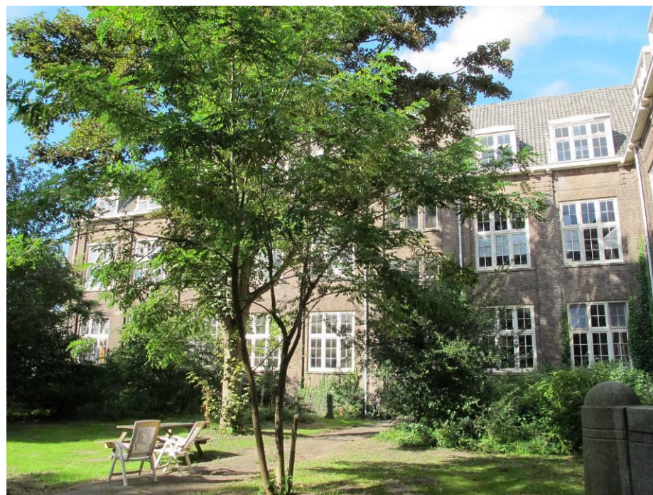
Overzicht zuidgevel van de linker (noordelijke) zijvleugel.
