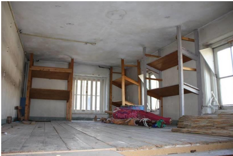
Tussenverdieping boven de opslagruimte.
