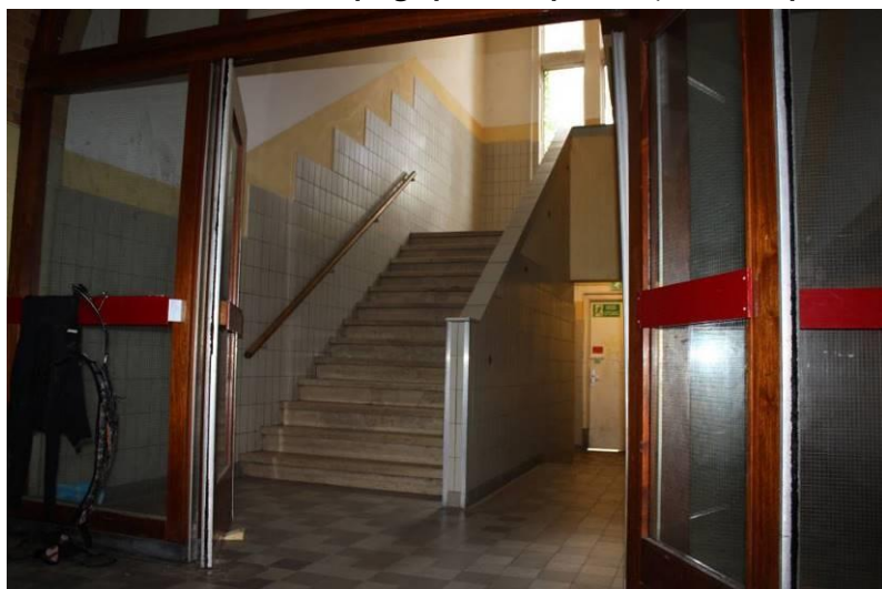
Interieur van het westelijke neventrappenhuis, met oorspronkelijke treden, plafonds en leuningen maar verder grotendeels vernieuwde afwerkingen.
