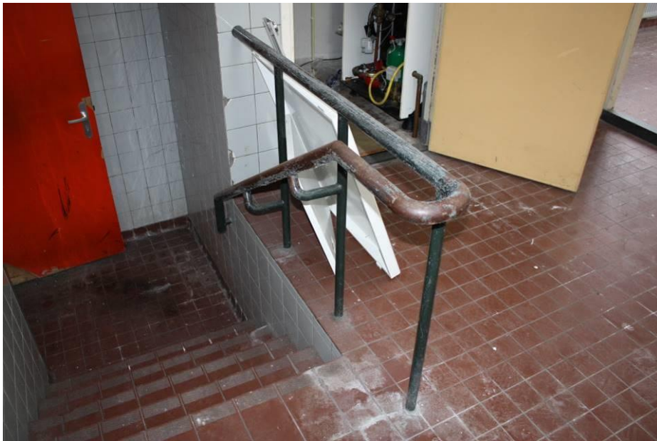
Vloerafwerkingen en trapje naar de lager gelegen gymnastiekzaal, in het verbindingslid tussen de rechter zijvleugel en de gymnastiekzaal.
