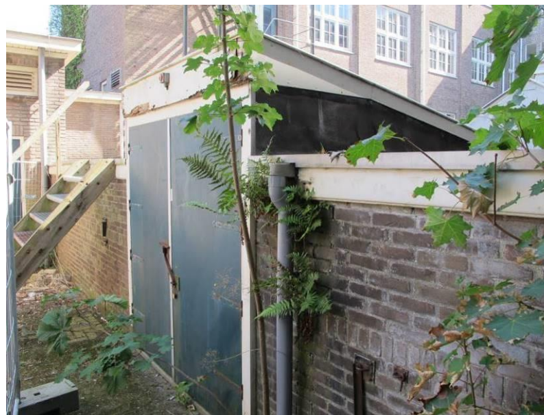
De noordgevel van de fietsenstalling met hierin later aangebrachte toegang onder een opgewipt dakgedeelte.
