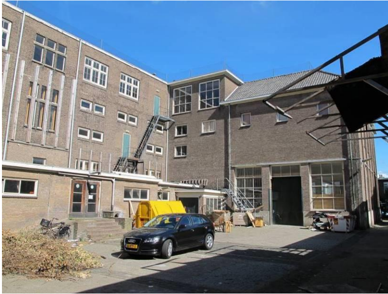
Het rechter (oostelijke) deel van de gevel van de linker zijvleugel, met op de achtergrond de hierop aansluitende noordoostelijke uitbreiding uit 1958.
