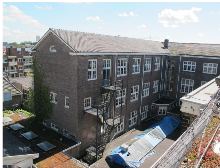
Overzicht van de dwarsvleugel, gezien vanaf het dak van de voorvleugel.
