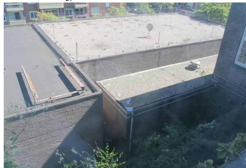
Overzicht over het dak van de gymnastiekzaal uit het noordwesten. Links is het aansluitende materiaallaboratorium zichtbaar.
