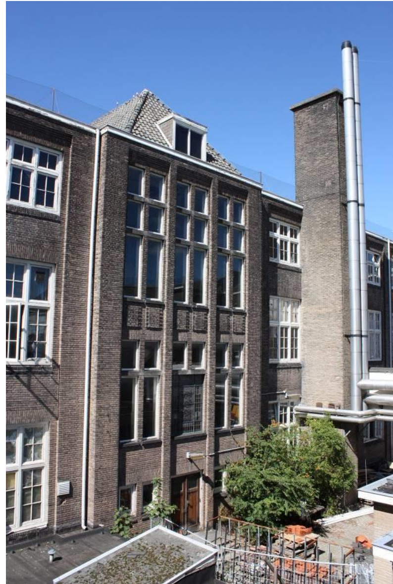
Licht risalerende middenpartij van de achtergevel van de voorbouw.
