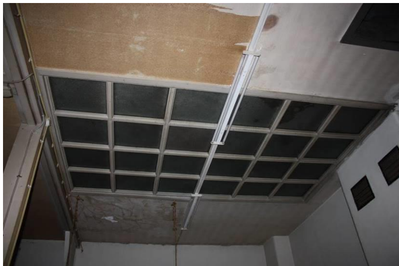
Oorspronkelijk legraam boven een ruimte bij de aansluiting op de voorvleugel.
