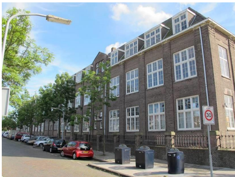
Zicht langs de linker zijgevel (noord).
