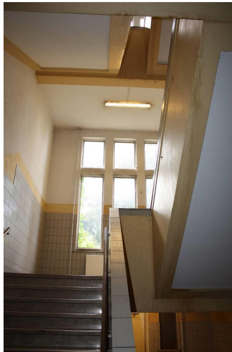
Zicht richting het tussenbordes van het neventrappenhuis.
