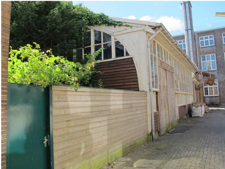
Zicht op de noordoosthoek van de stellloods, met in de oostgevel (links) nog de oorspronkelijke gevelinvulling binnen het gelamineerde spant.
