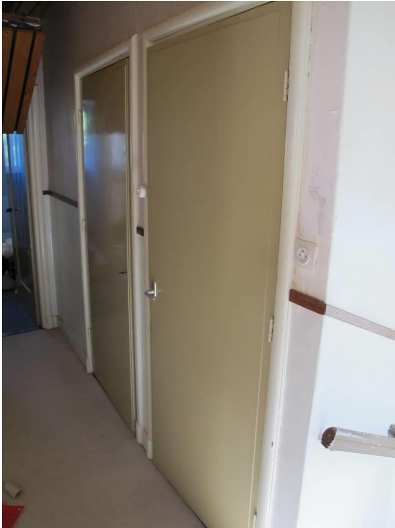
Uit 1922 daterende indeling op de verdieping, met oorspronkelijke (afgeplate) paneeldeuren.
