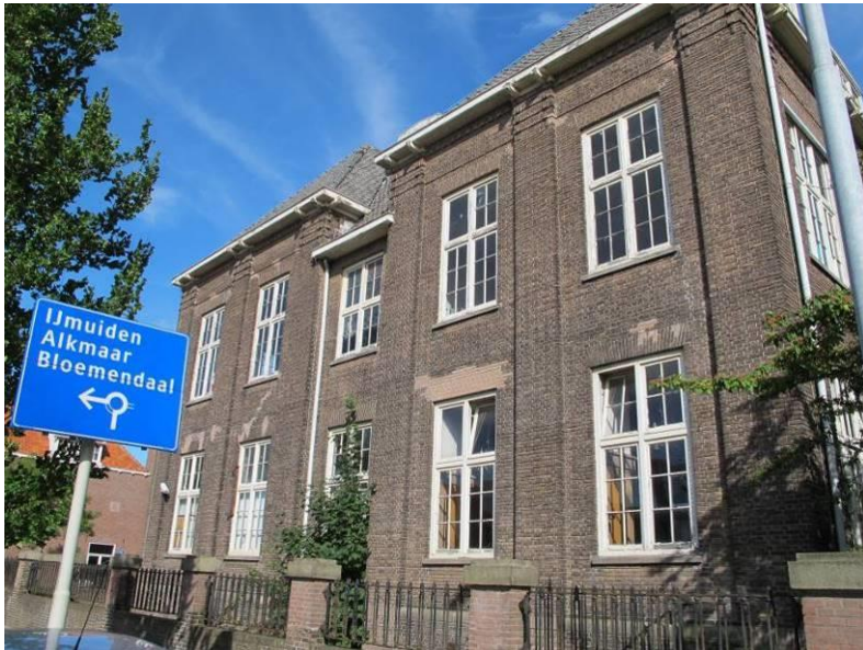
Overzicht westelijke kopgevel van de linker zijvleugel.
