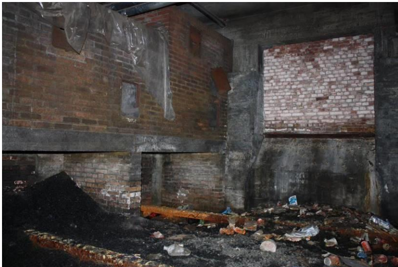
Interieur voormalige kolenopslag naast het centrale trappenhuis in voorvleugel.
