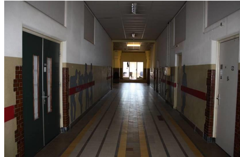
De gang richting de rechter zijvleugel op de verdieping met oudere tegelvloer en hier nog ongeschilderde detailleringen in schoon metselwerk.
