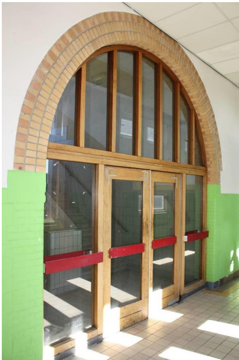
Binnen oorspronkelijke boogdoorgang aangebrachte recente pui.
