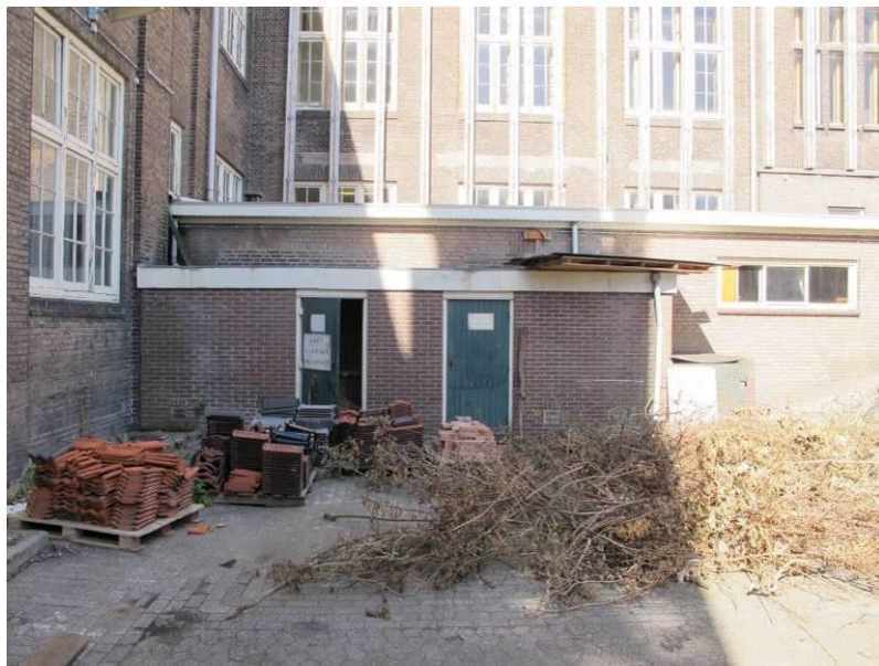
Het westelijke deel van bouwdeel F, met hiertegen gebouwde gasopslag.
