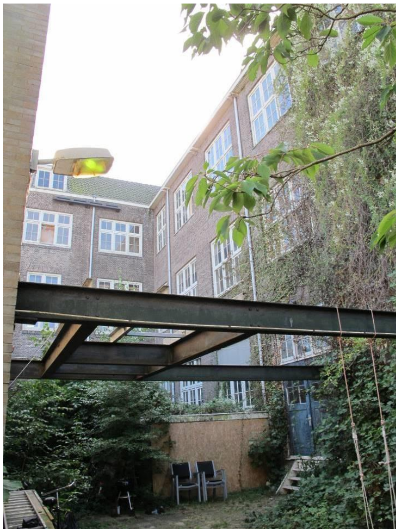
Zicht op de oostgevel van de dwarsvleugel (rechts) en de aansluiting op de rechter zijvleugel.
