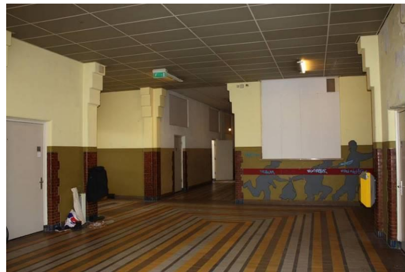
Historische tegelvloer bij aansluiting verdieping voorbouw op zijvleugel
