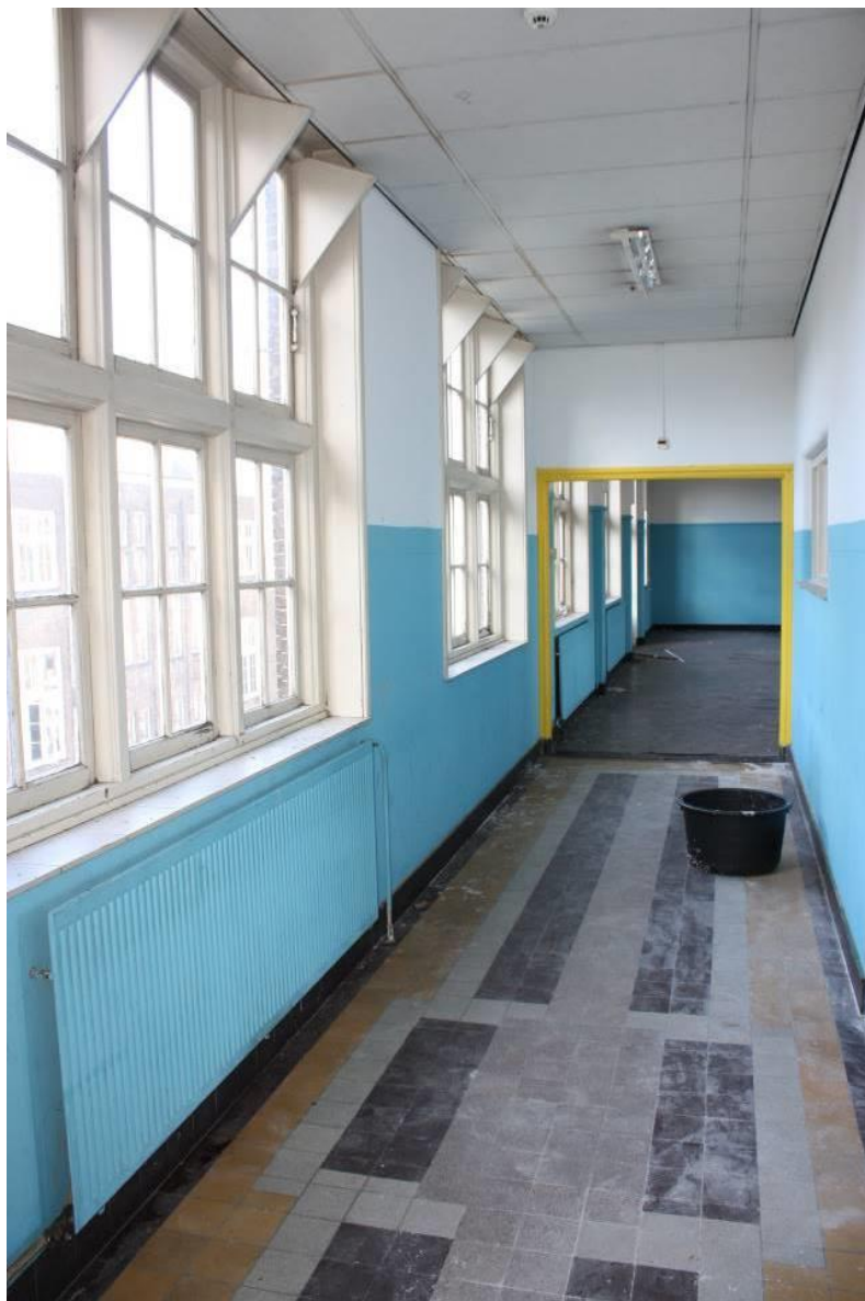
Zicht door de gang op de tweede verdieping, met afwerkingen uit de bouwtijd.
