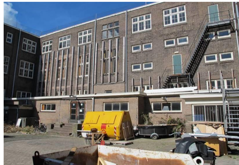
Overzicht van de zuidgevel van de linker zijvleugel, met hiertegen gebouwd enkellaags bouwdeel F.
