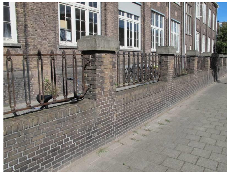
Zicht langs het hekwerk aan de zuidzijde van het gebouw.
