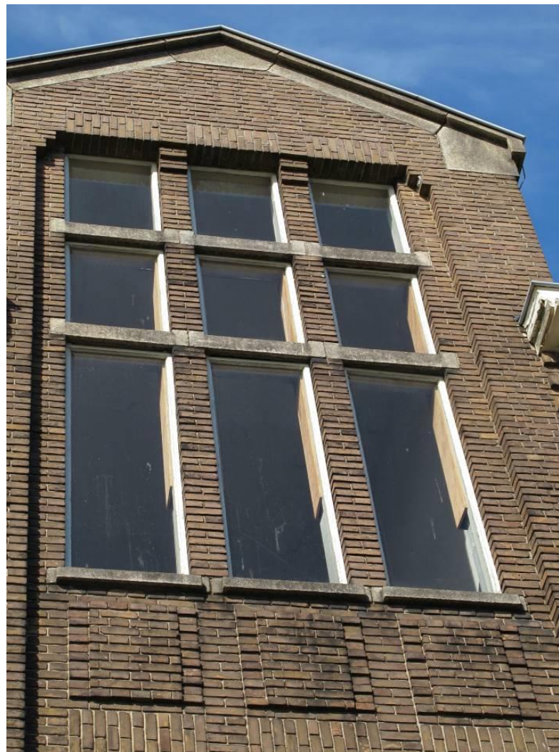
Detailtering bovenzijde trappenhuisgevel.
