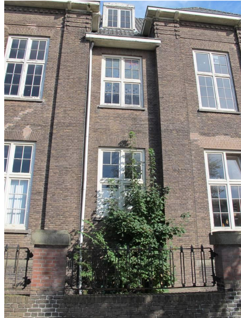
Detail middendeel westelijke kopgevel rechter zijvleugel.
