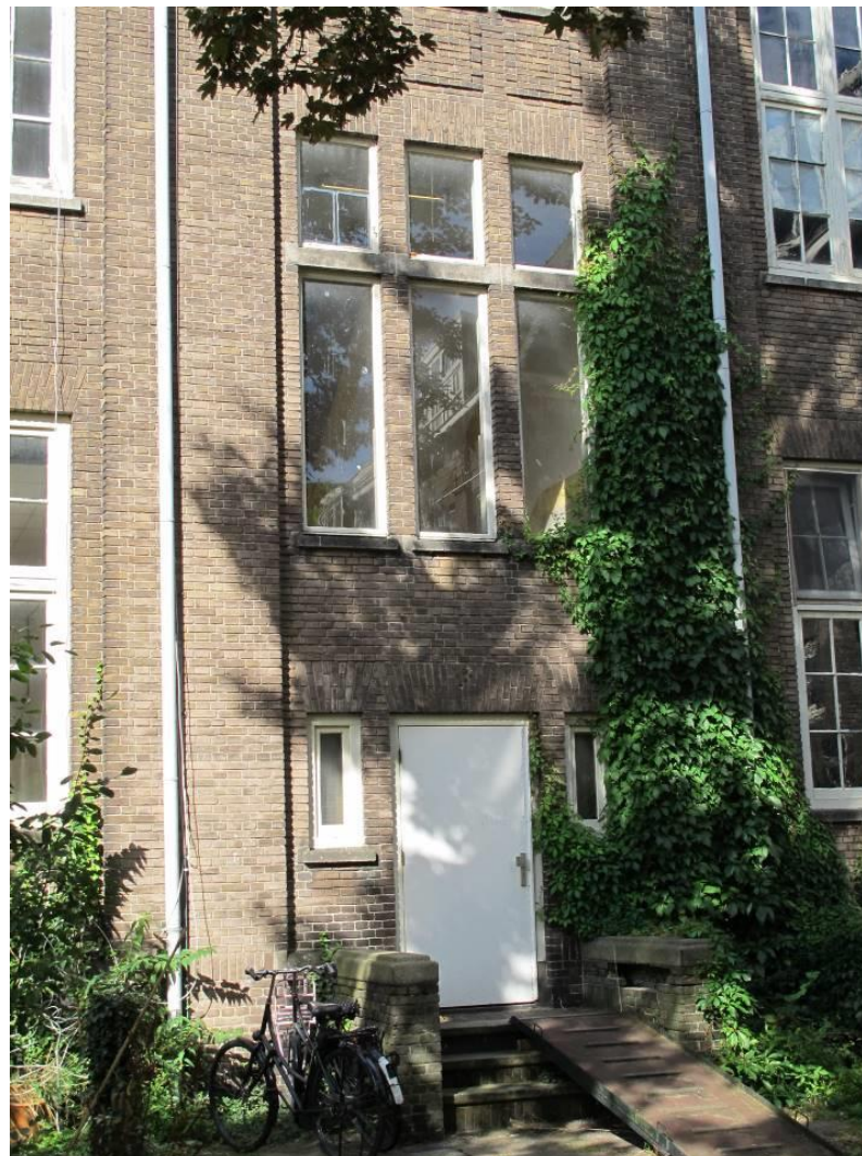
In het gevelvlak benadrukt trappenhuis van de linker zijvleugel.
