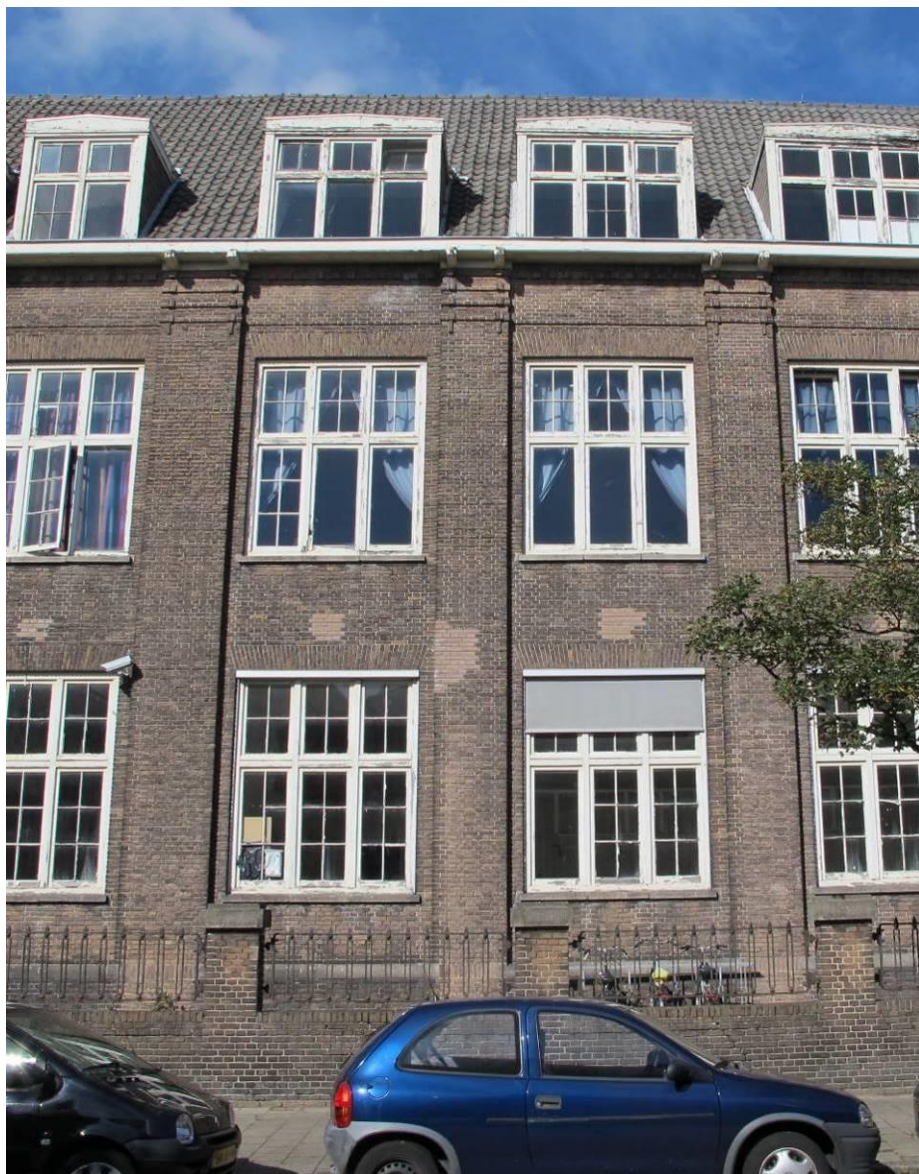
‘Standaard’ opbouw van de naar de straat en het voorplein gerichte gevels.
