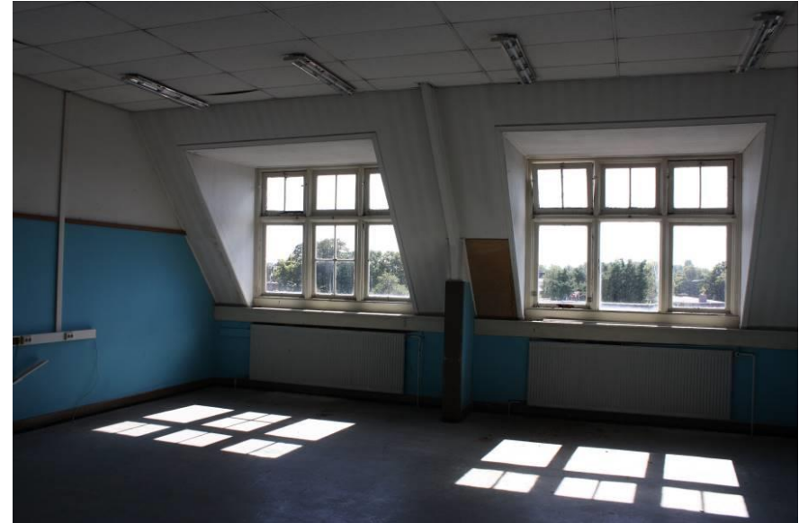
Binnen de onder de dakschilden gelegen ruimtes zijn de spantbenen tussen de dakcapellen herkenbaar.
