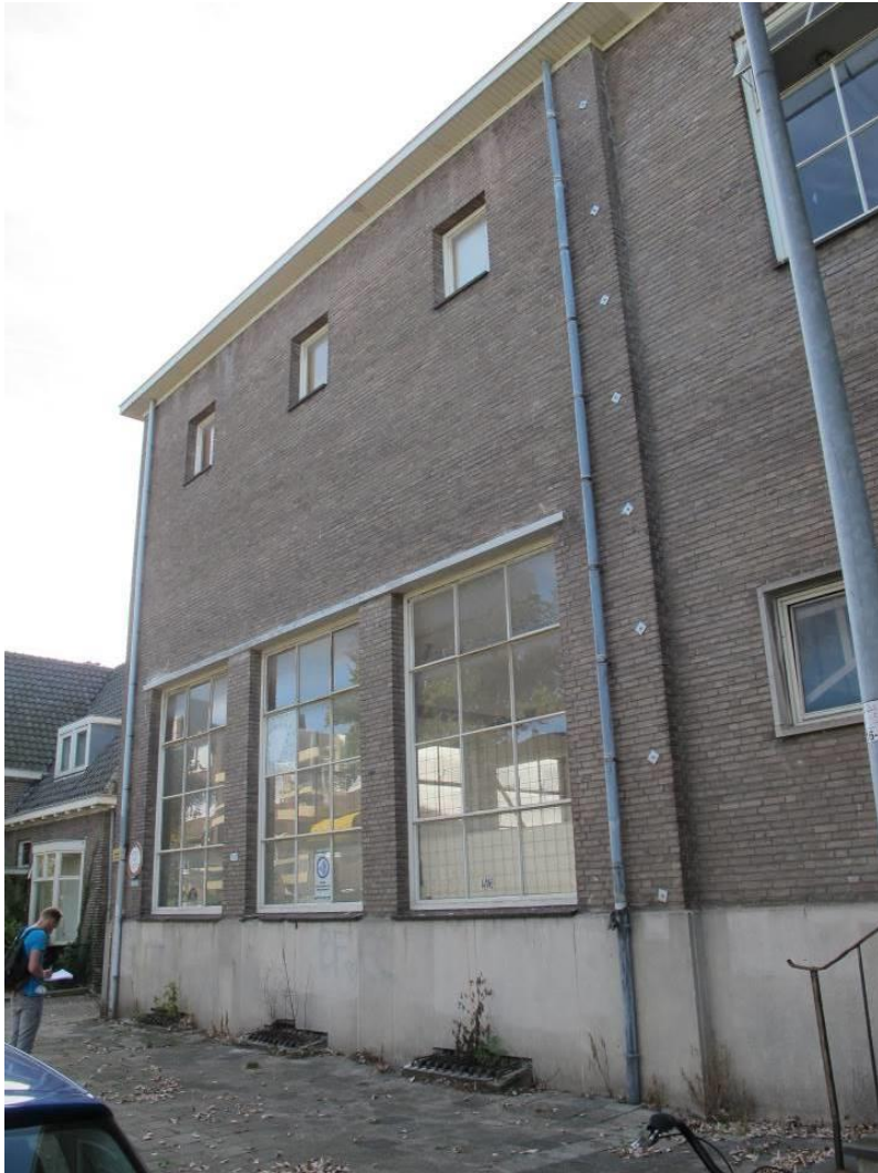
Het geheel in baksteen uitgevoerde zuidelijke deel van de oostgevel.
