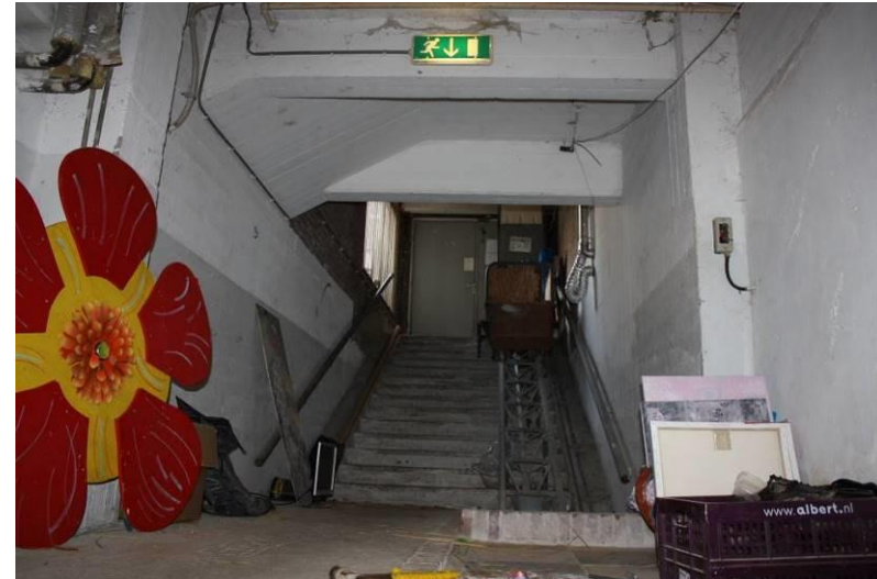
Toegang vanaf het achterterrein (via bouwdeel F) tot de kelder.
