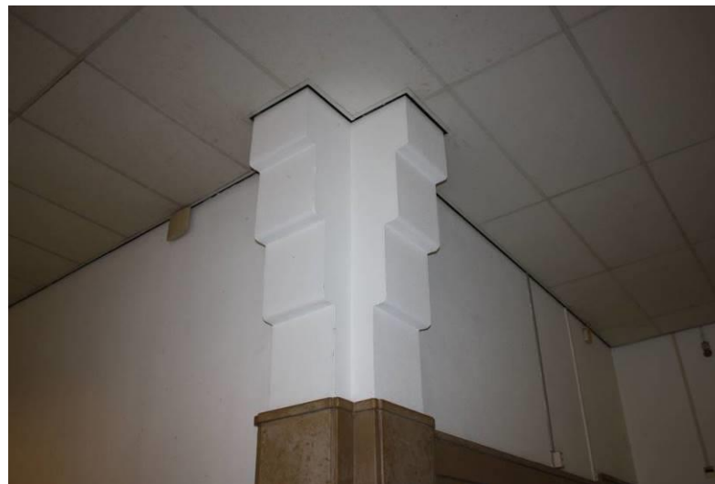
De naar de bovenzijde getrapt uitlopende pilasters, zoals deze op veel plaatsen in het gebouw voorkomen. Hier in de centrale hal.
