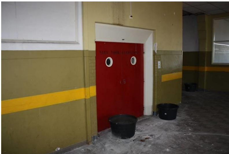
Lift op de tweede verdieping. Hoewel de opzet van de lift op deze plaats oorspronkelijk is, werd de lift waarschijnlijk omstreeks 1958 vernieuwd.
