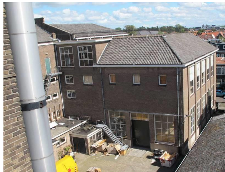
Overzicht van bouwdeel E vanuit het zuidwesten.
