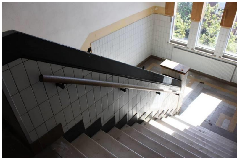
Behoudens wandtegels grotendeels oorspronkelijke afwerkingen neventrappenhuis.
