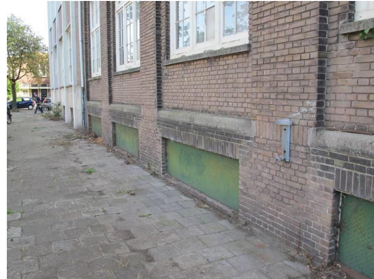
Aansluitend op de noordwestelijke uitbreiding werden enkele traveeën voorzien van kelderlichten t.b.v. de hier gerealiseerde fietsenkelder.
