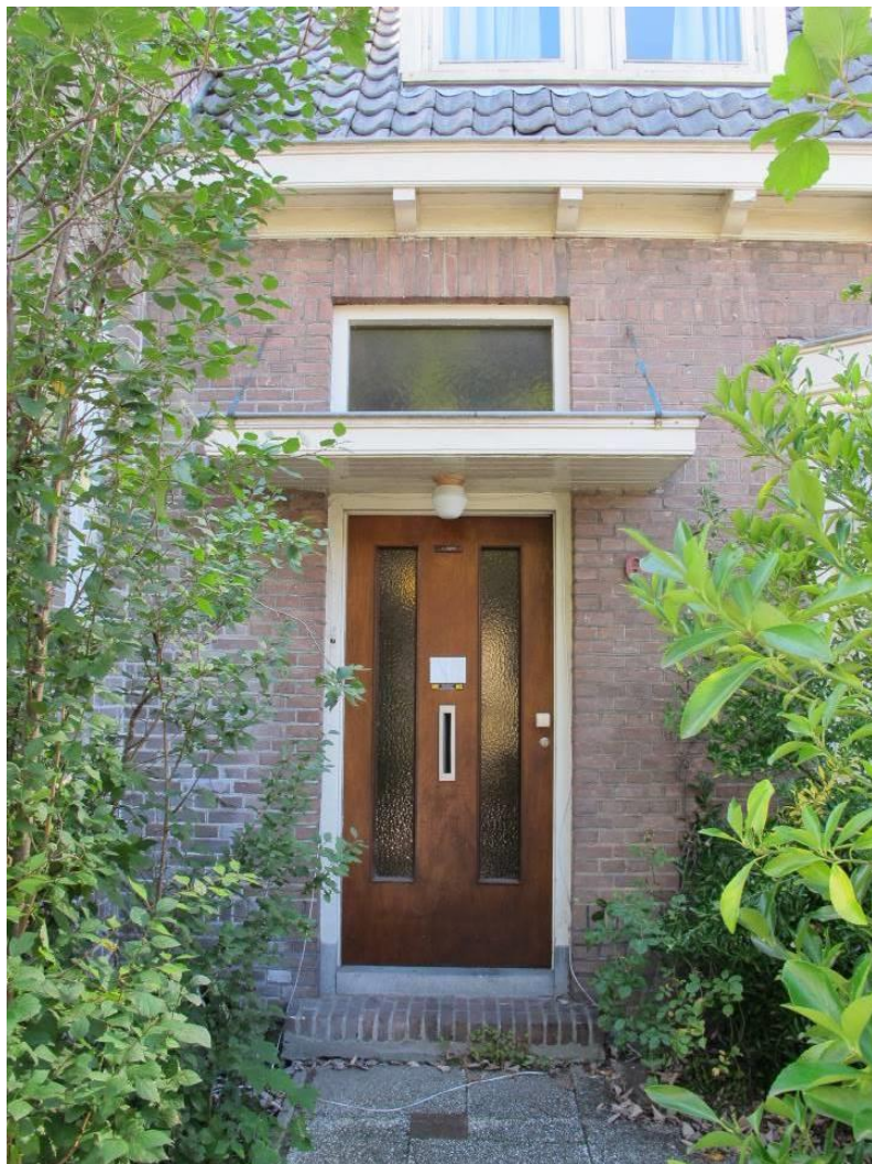
Later ingevoegde entree in de voorgevel van nummer 6.
