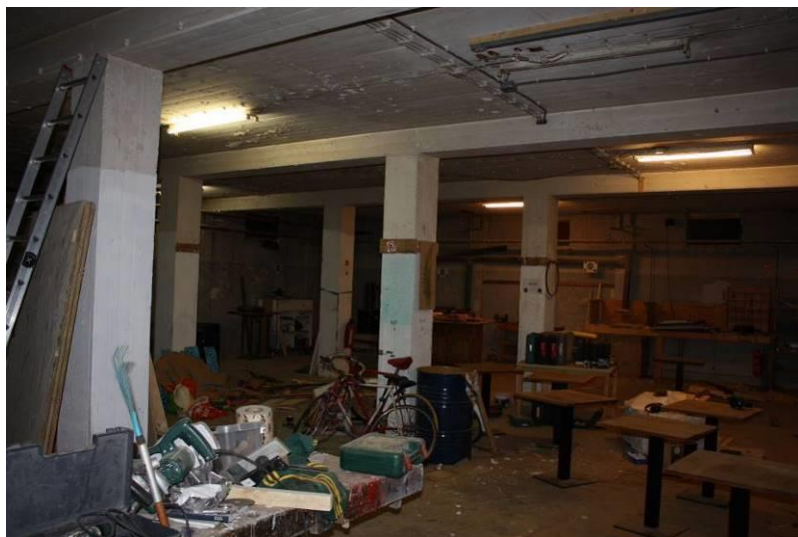
Interieur van de kelder, oorspronkelijk bestemd als fietsenstalling.
