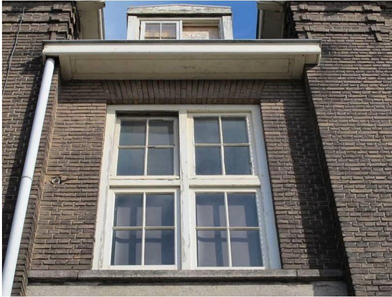
Venster boven entreepartij westgevel rechter zijvleugel.
