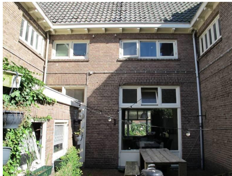
Achtergevel van de middelste woning (nummer 4)
