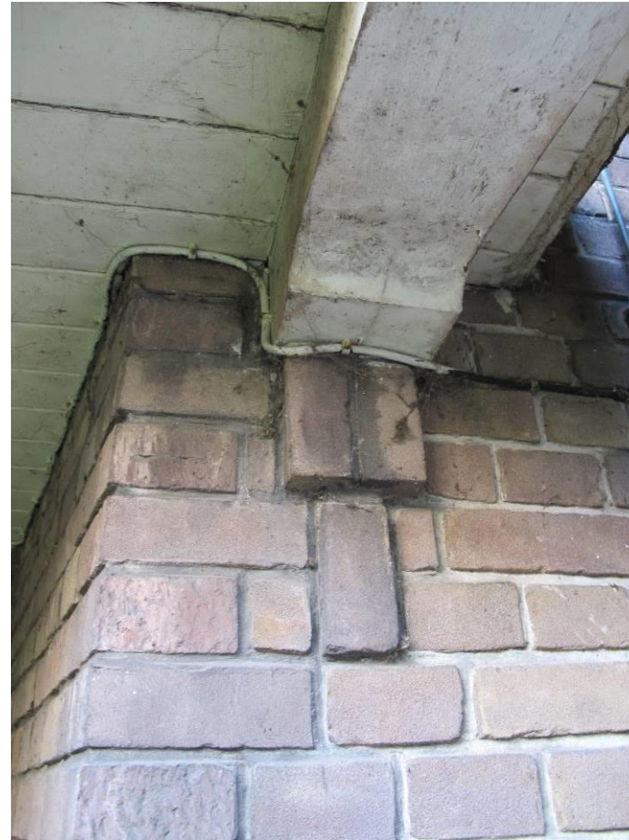
Detail siermetselwerk onder console van luifel toegang fietsenstalling.
