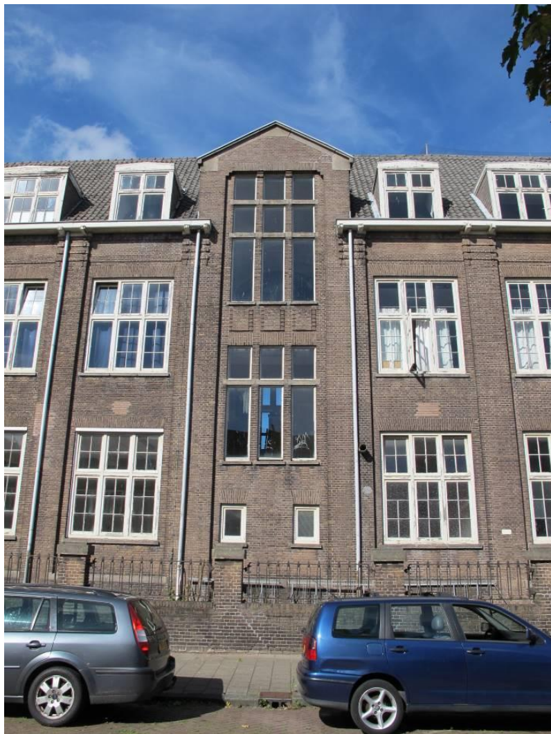
Afwijkend gedetailleerde travee ter plaatse van één van de trappenhuizen.
