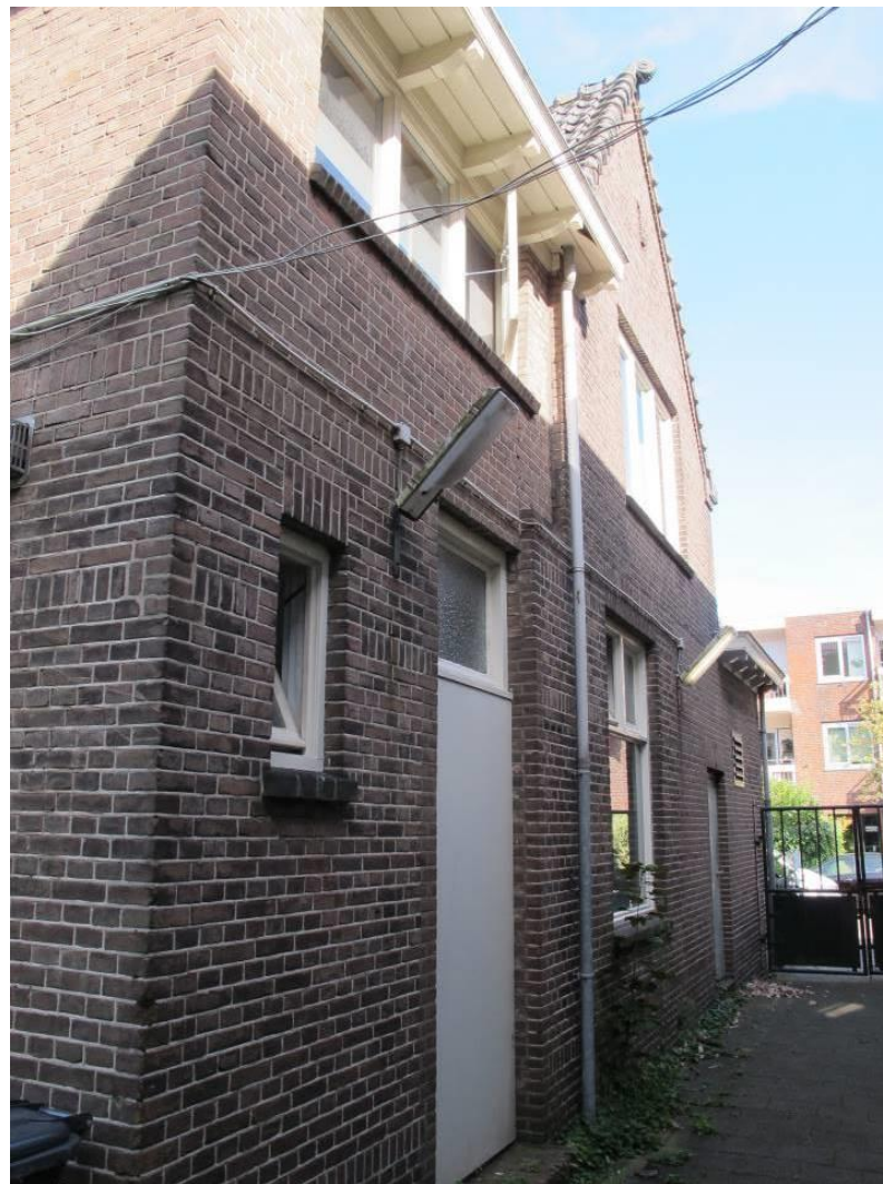
Zicht langs de linker zijgevel (zuid) van Brakenburghstraat 2.
