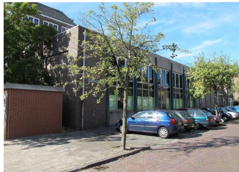
Overzicht van de gymnastiekzaal uit het zuidoosten.
