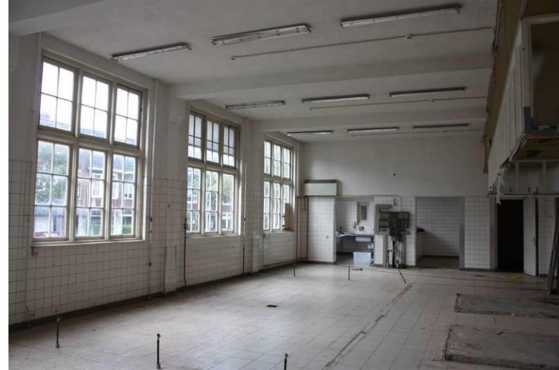
Interieurbeeld van één van de praktijklokalen naast de zuidgevel.
