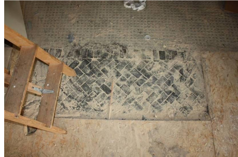
Gedeeltelijk aanwezige vloer van blokjes kops hout in keperverband in het praktijklokaal.
