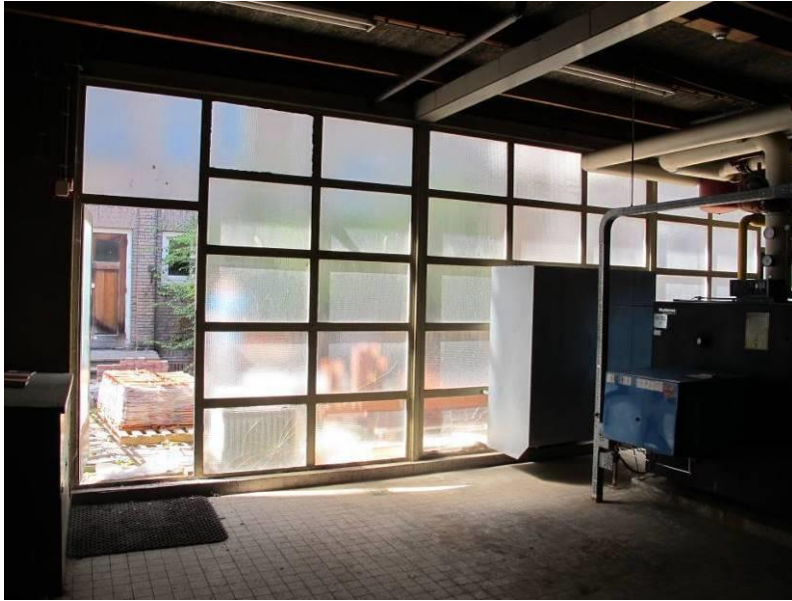
Interieur van het ketelhuis, gezien in westelijke richting.
