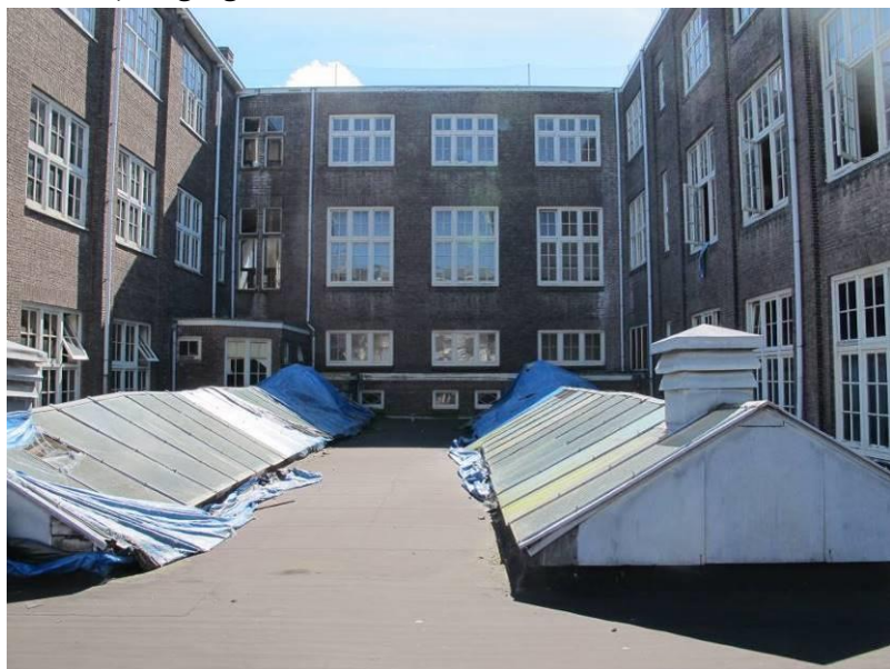
Zicht over het dak van de fietsenstalling in zuidelijke richting.
