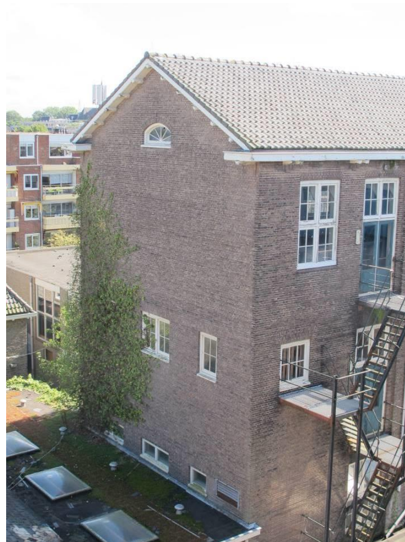
Overzicht noordgevel van de dwarsvleugel.
