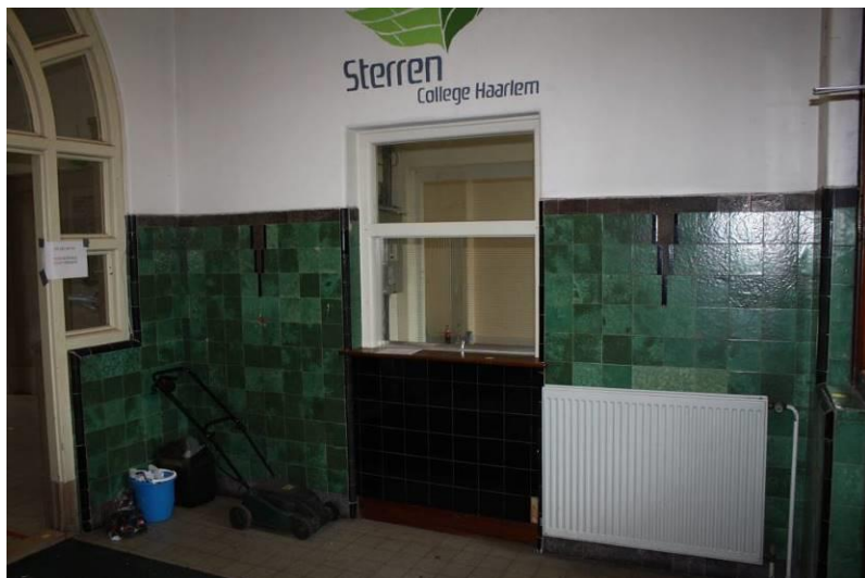
Rechter wand van de vestibule met tot loket omgevormde deuropening.
