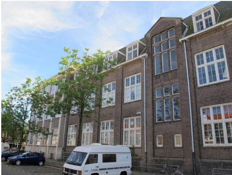
Aan de linker zijde sluit de linker zijgevel aan op de gevel van de in 1958 tot stand gekomen noordoostelijke uitbreiding (bouwdeel E).
