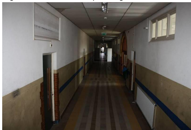
Zicht door het westelijke deel van de gang op de tweede verdieping.
