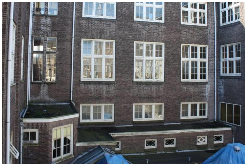
Zicht op het zuidelijke deel van de fietsenstalling, met de langs de noordgevel van de zijvleugel gebouwde ruimtes.
