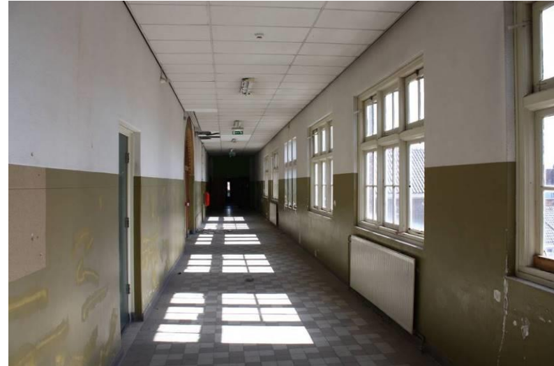
Oostelijke gang op de tweede verdieping.
