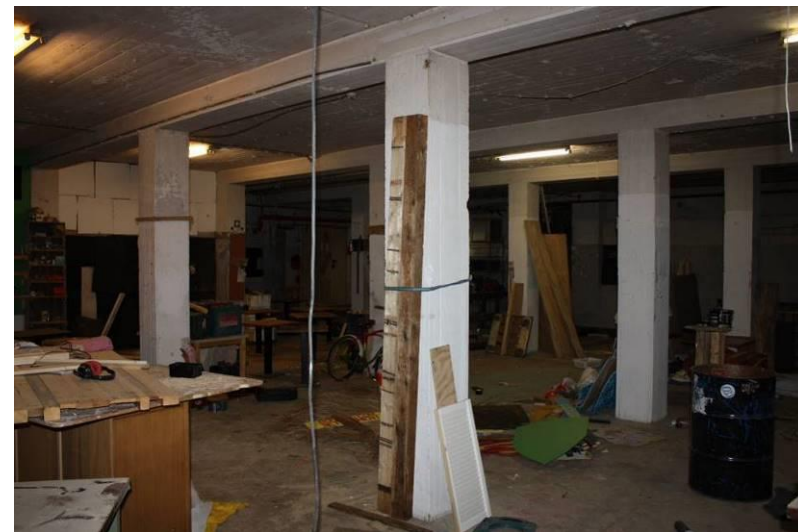
Betonconstructie, zoals zichtbaar in de kelder.
