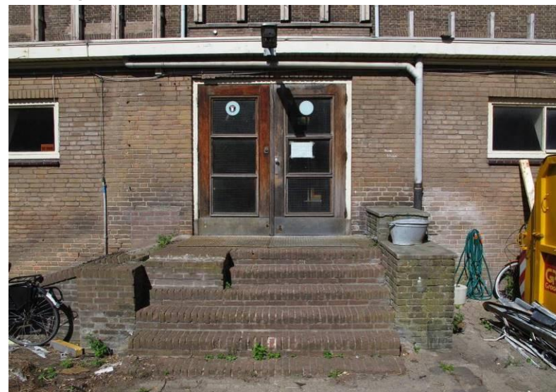
De sober uitgevoerde entree in het middendeel van bouwdeel F.
