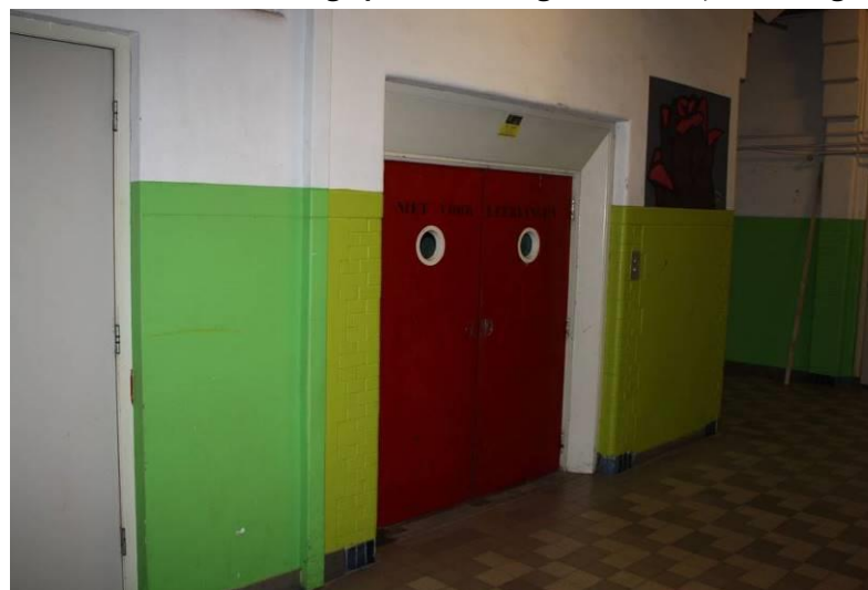
De lift werd vernieuwd, maar bleef op de bestaande plaats gehandhaafd bij de aansluiting op de voorvleugel.
