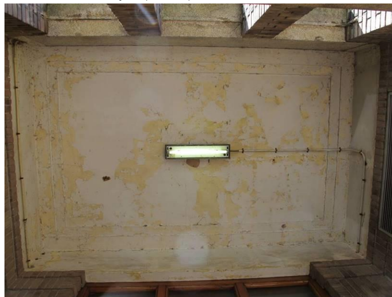
Het stucplafond boven het entreeportiek.
