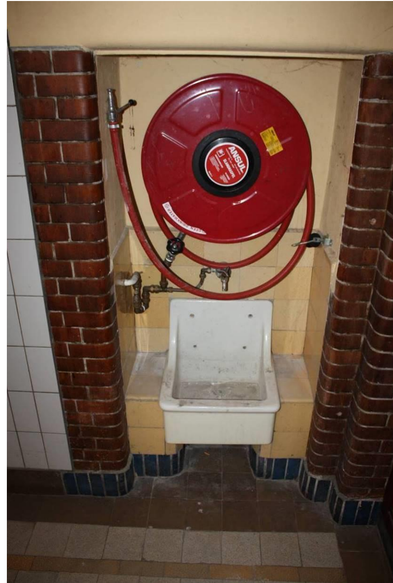
Oorspronkelijk nisje met gootsteen in het neventrappenhuis.
