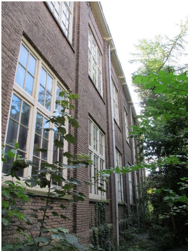
Zicht langs de noordgevel van de rechter (zuidelijke) zijvleugel.
