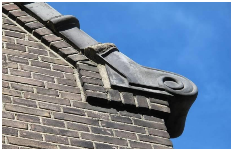
Bij de verschillende dakvlakken zijn bijzondere decoratieve dakpannen toegepast.
