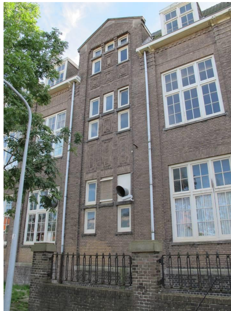
Detail van één van de afwijkende traveeën. In dit geval is hier geen trappenhuis gesitueerd, maar sanitaire ruimtes.
