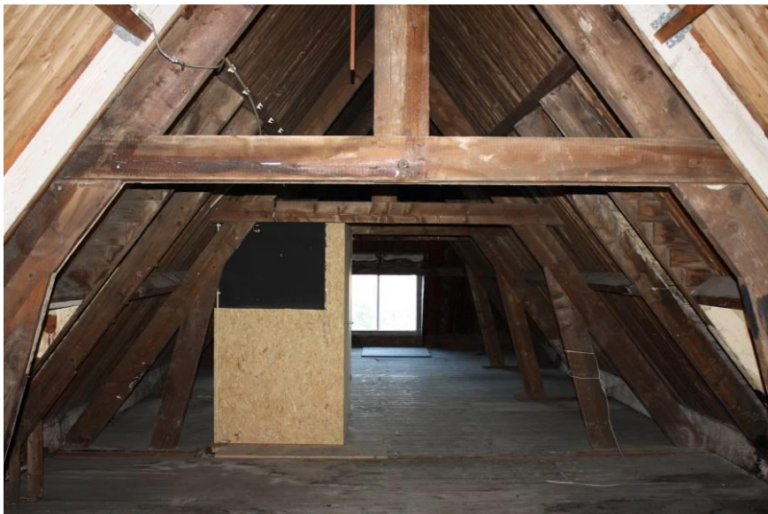
Dakconstructie boven het middendeel van de voorvleugel.
