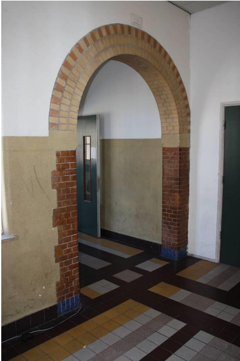
Doorgang naar de verdieping van de dwarsvleugel (D). De tegelvloer werd hier met bijpassende tegels aangevuld.
