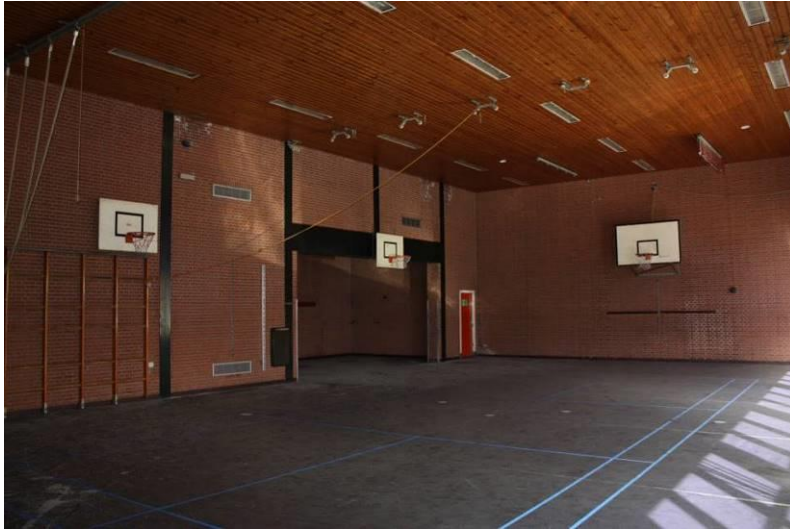
Zicht op de noordwesthoek van de gymnastiekzaal. In de westwand (links) zijn betonnen kolommen opgenomen.
