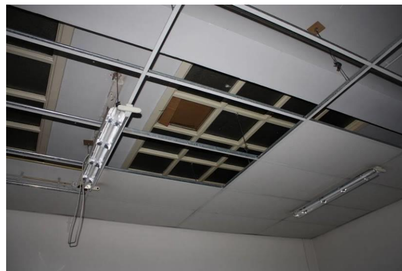
Oorspronkelijke legramen boven ruimte bij aansluiting op voorvleugel.
