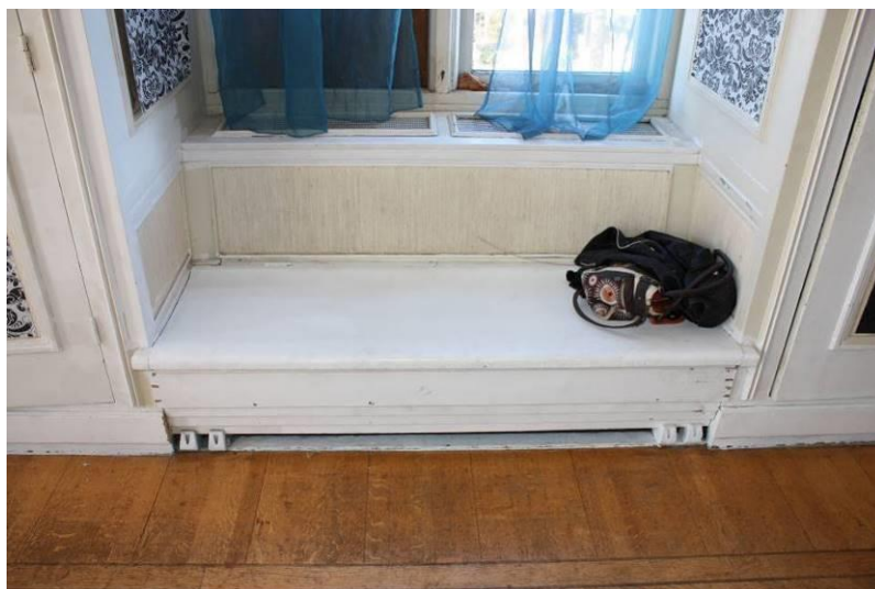
Bij de voorgevel zijn vensterbanken in de muurdikte geïntegreerd.
