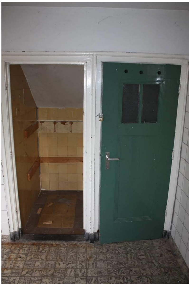
De kastdeur van deze kasten onderin één van de trappenhuis is oorspronkelijk. De tweede deur is verdwenen.
