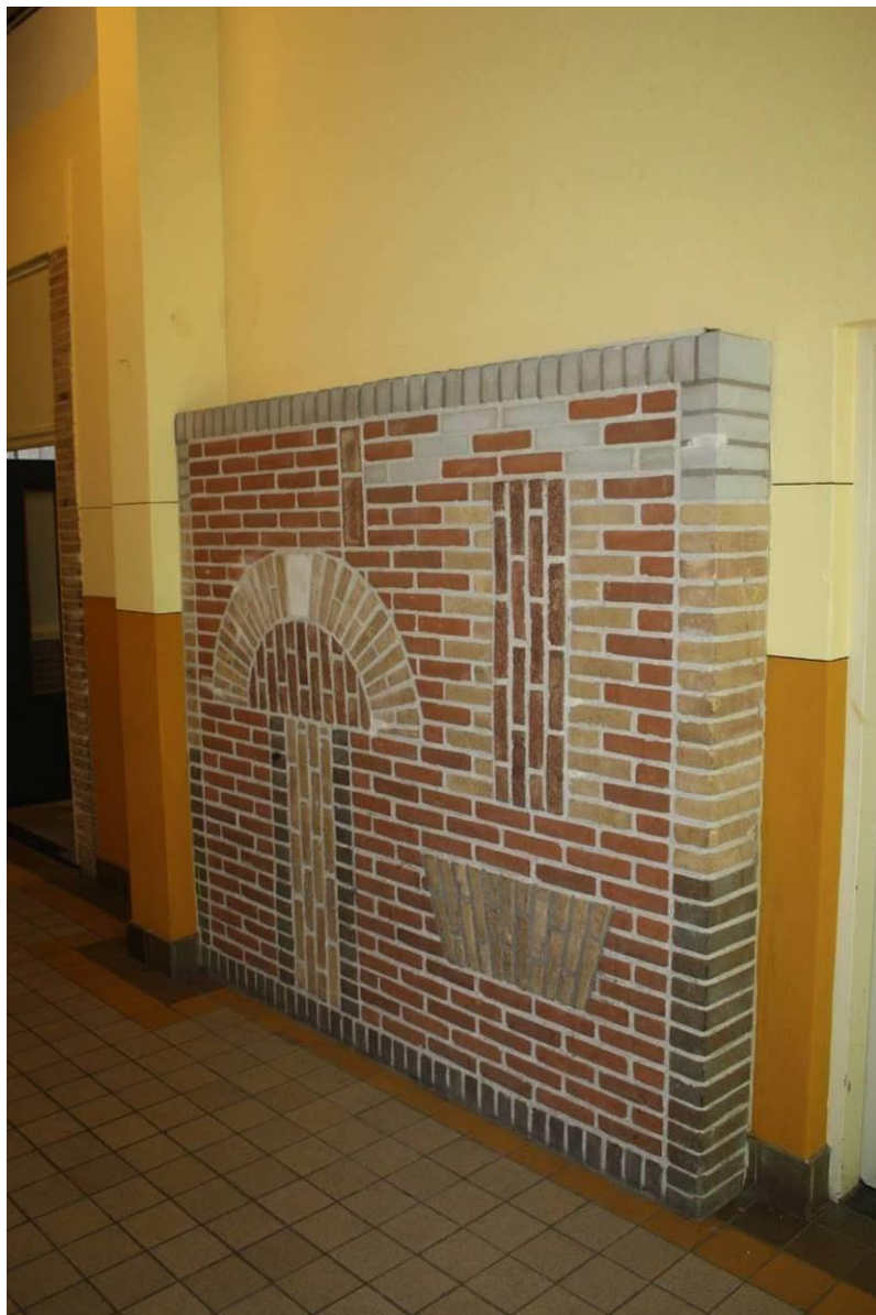
Siermetselwerk in oostelijke gang op de verdieping.
