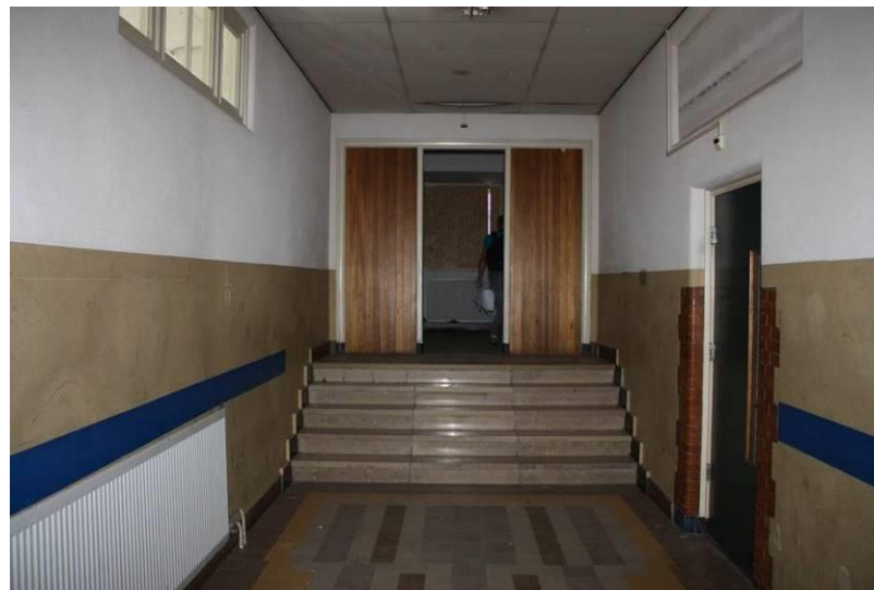
Hoger vloerniveau aansluitend op de westgevel.
