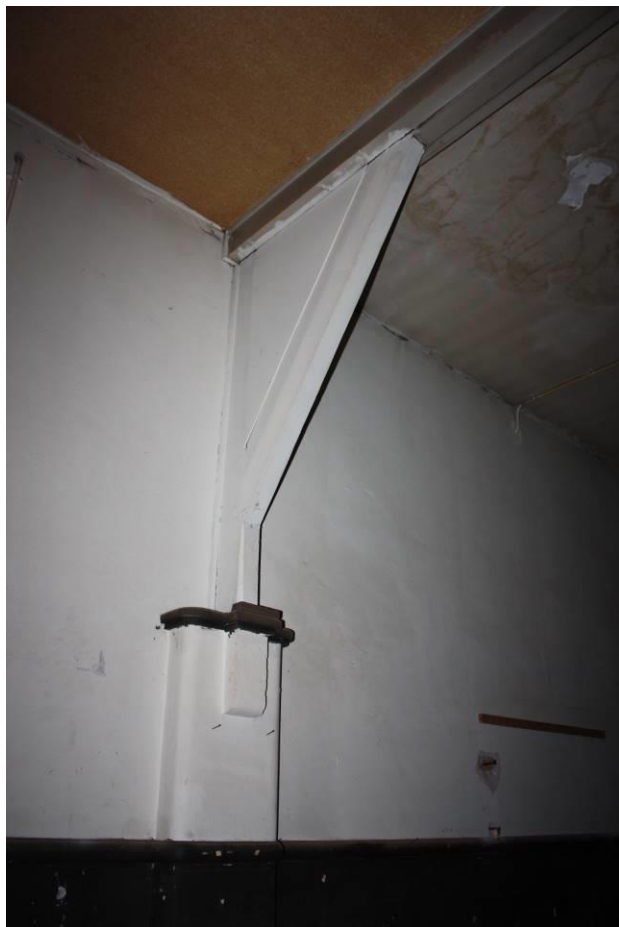
Op een gepleisterde pilaster geplaatste standvink bij aansluiting van de daken van de voorvleugel en rechter zijvleugel. Ter plaatse van gangwanden zijn deze standvinken in enkele ruimtes op overeenkomstige wijze herkenbaar.
