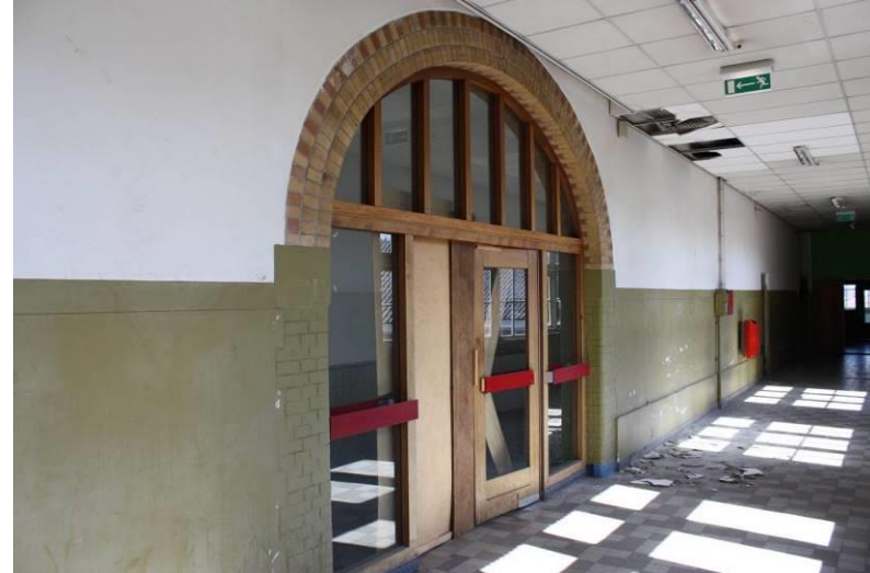
Boogdoorgang naar oostelijk trappenhuis vanaf tweede verdieping.
