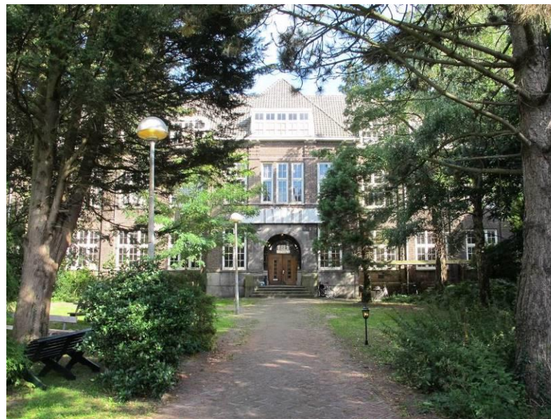
Overzicht westgevel van de voorbouw.
