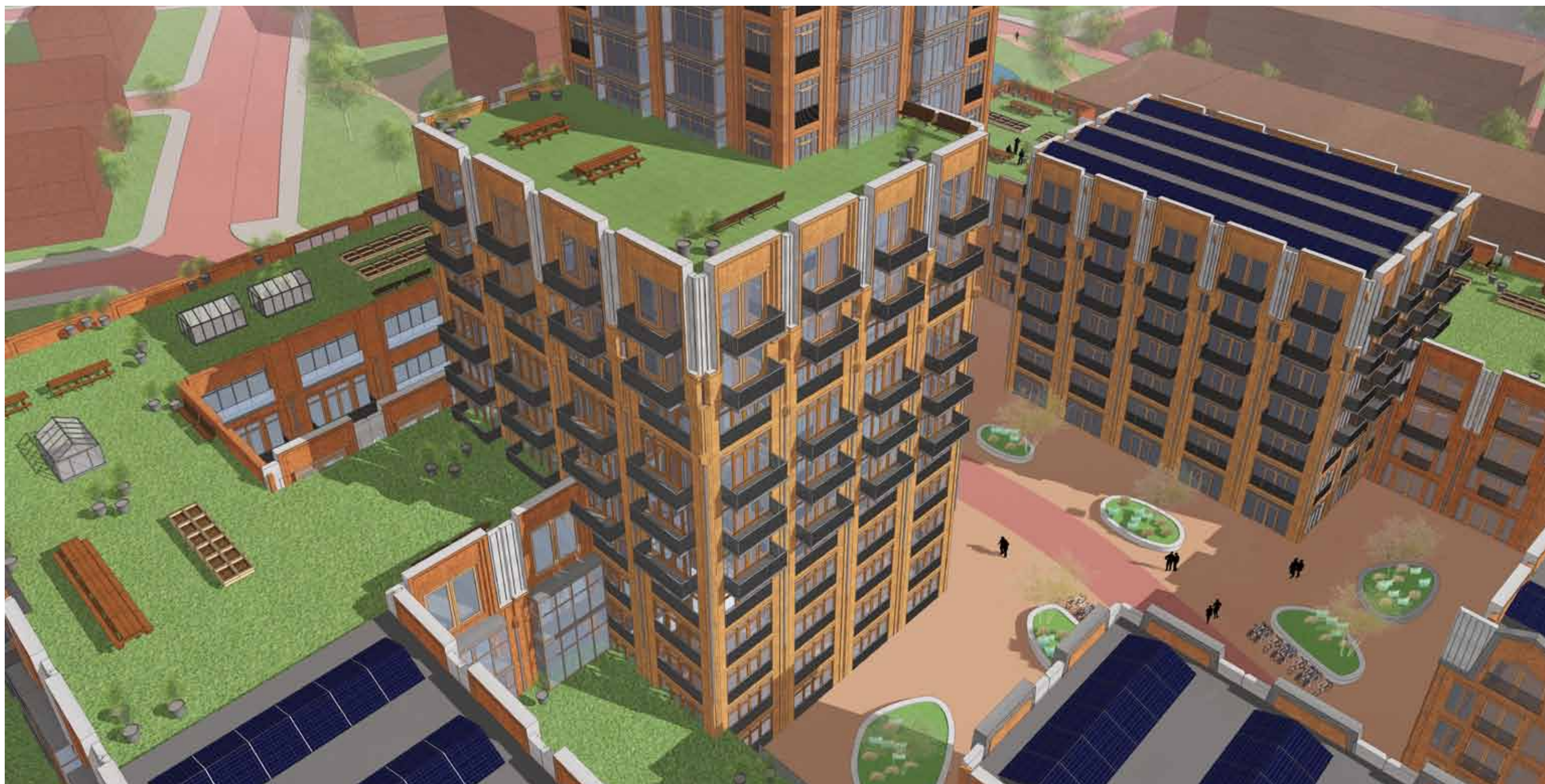
Groene daken afgewisseld met zonnepanelen
