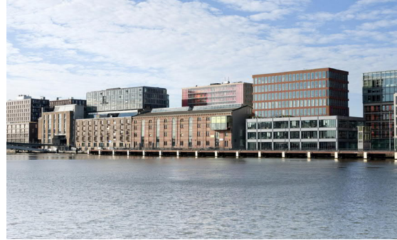
4. Aan belangrijke openbare ruimtes: Waterfront Oostelijke handelskade in amsterdam Bron: KCAP architects and planners
