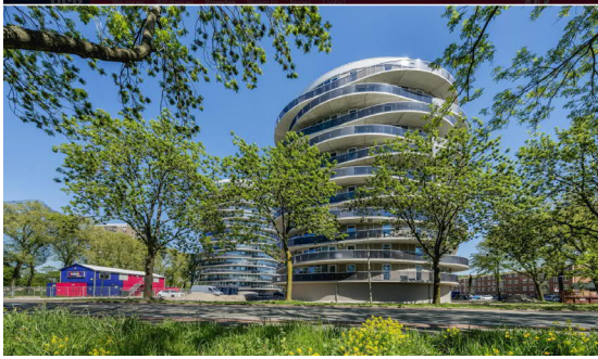
4. Aan belangrijke openbare ruimtes: Torens in Schalkwijk, VMX architects
