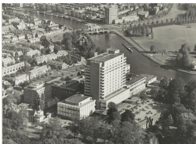
Afb 14. Breuk in schaal en hoogte bij de 'Nieuwbouw' van de Mariastichting, uitgevoerd in 1969, op de voorgrond is het tuinpaviljoen zichtbaar, ontworpen door Abraham van der Hart uit 1801, als onderdeel van de voormalige buitenplaats Bellevue aan de Kleine Houtweg. xiv
