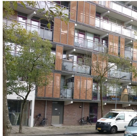
Gerenoveerde flats zijn goed uitgevoerd (Baden-Powellstraat, William Boothstraat en Thomas Morestraat)
