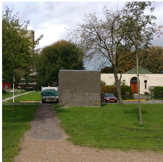
Bijkomende transformatorhuisjes kunnen zorgen voor bijkomende blinde gevels en sociaal onveilige situaties
