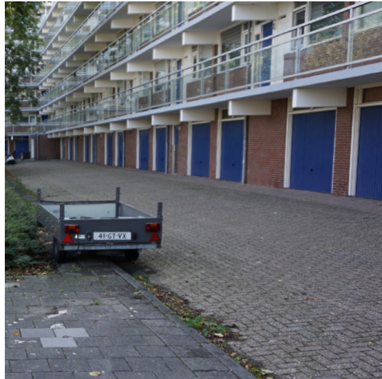
Blinde plinten in flats (Erasmuslaan) Veel garage boxes (Florence Nightingalestraat)
