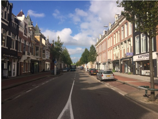
Afbeelding 3.3.4: asfalt straat Zuid-West (Zijlweg)
