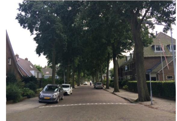
Afbeelding 5.2.5: Prins Mauritslaan, asfalt op trottoirs
