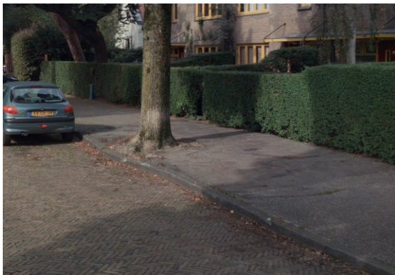
Afbeelding 3.3.5: asfalt trottoir Zuid-West (Spaarnelaan)
