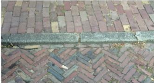
Afbeelding 5.2.17: In een deel van Tuinwijk liggen er gebakken klinkers in het trottoir (dikformaat) en in rijweg (waalformaat)
