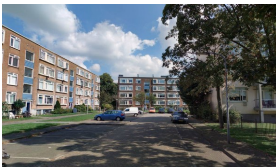
Afbeelding 3.6.4 : Wijd profiel in Parkwijk: Staalstraat
