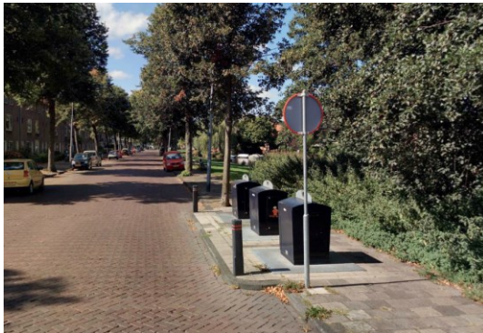
Afbeelding 3.4.2.: Gebrekkige inpassing ondergrondse vuilcontainers. Aandacht voor detailuitwerking in het lengteprofiel is nodig
