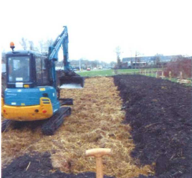
4. Stort de helft van de benodigde bodemsupplementen in de geul en verspreid deze gelijkmatig over het hele plantvak.
