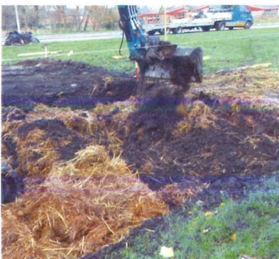
5. Meng de bodemsupplementen door de aarde met de graafmachine.
