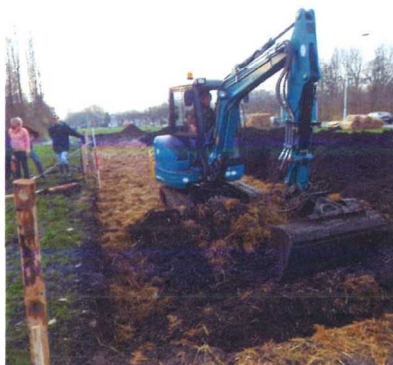
6. Stort vervolgens de rest van de opgegraven aarde terug, verspreid de helft van de bodemsupplementen over de aarde en meng dit door elkaar.
