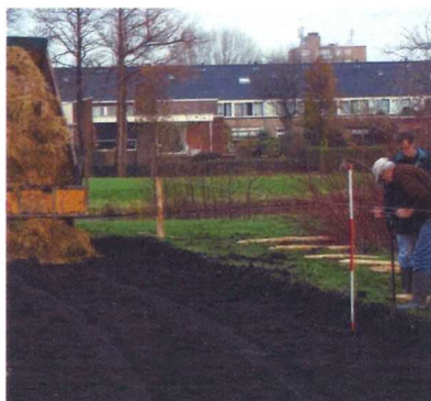
4. Stort de helft van de benodigde bodemsupplementen in de geul en verspreid deze gelijkmatig over het hele plantvak.
