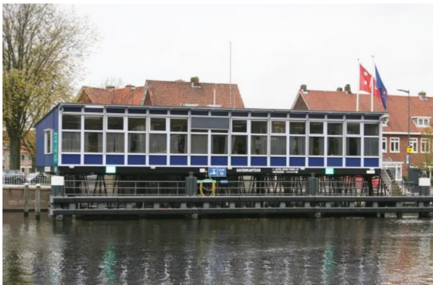
Figuur 3: bestaand gebouw
