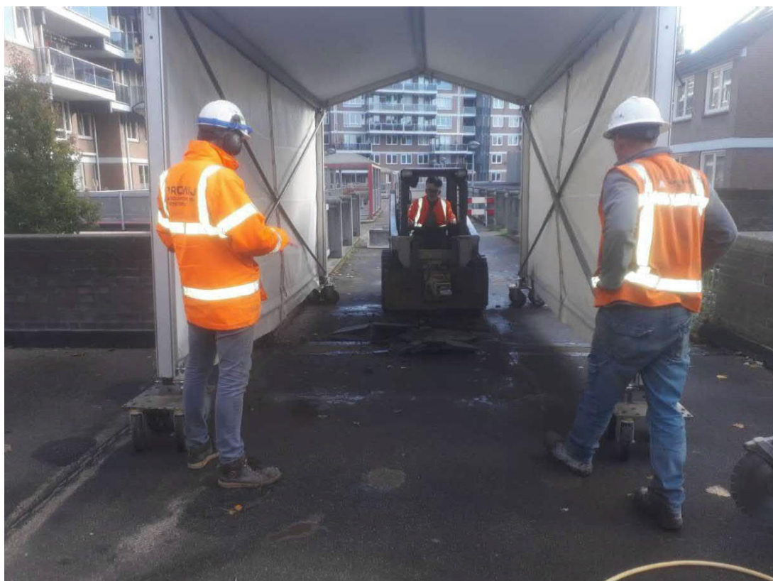
Figuur 32: Bobcat in uitvoering bij 1 van de 5 onderzoeksvakken
