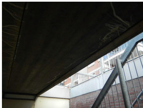
Figuur 2: Langsscheur ter plaatse van S13D
