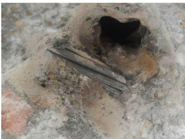
Figuur 3.13 : Vrijgemaakte voorspanstreng
