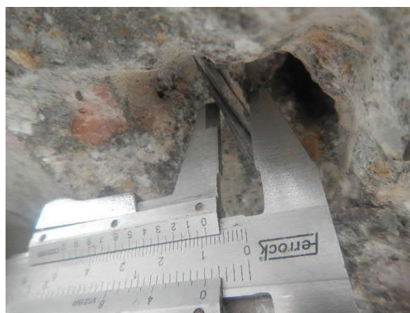
Figuur 3.14 : Vrijgemaakte voorspanstreng
