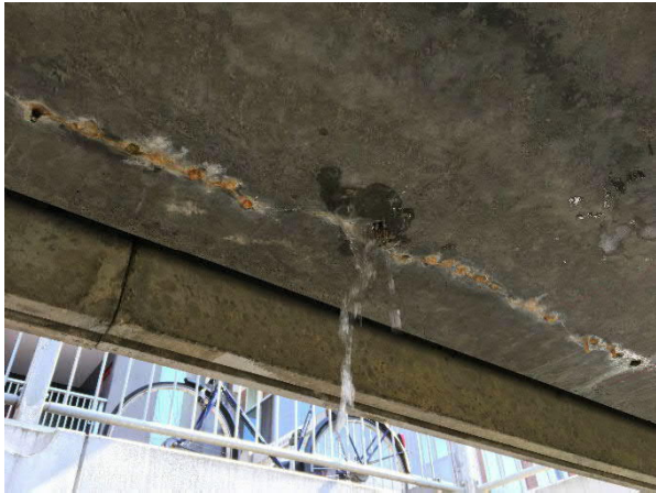
Figuur 3.5: Met water gevuld kanaal ter plaatse van Sandenburg veld 35 plaat D
