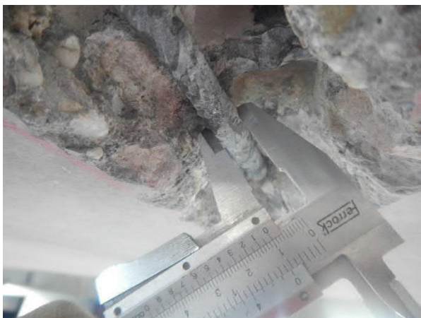
Figuur 3.11 : Vrijgemaakte dwarswapening \varnothing 10
