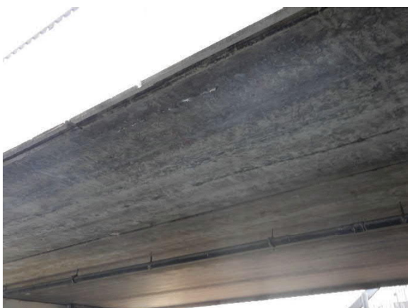
Figuur 3: Langsscheur ter plaatse van S25A
