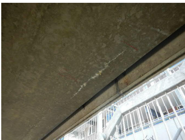
Figuur 11: Langsscheur ter plaatse van E28D
