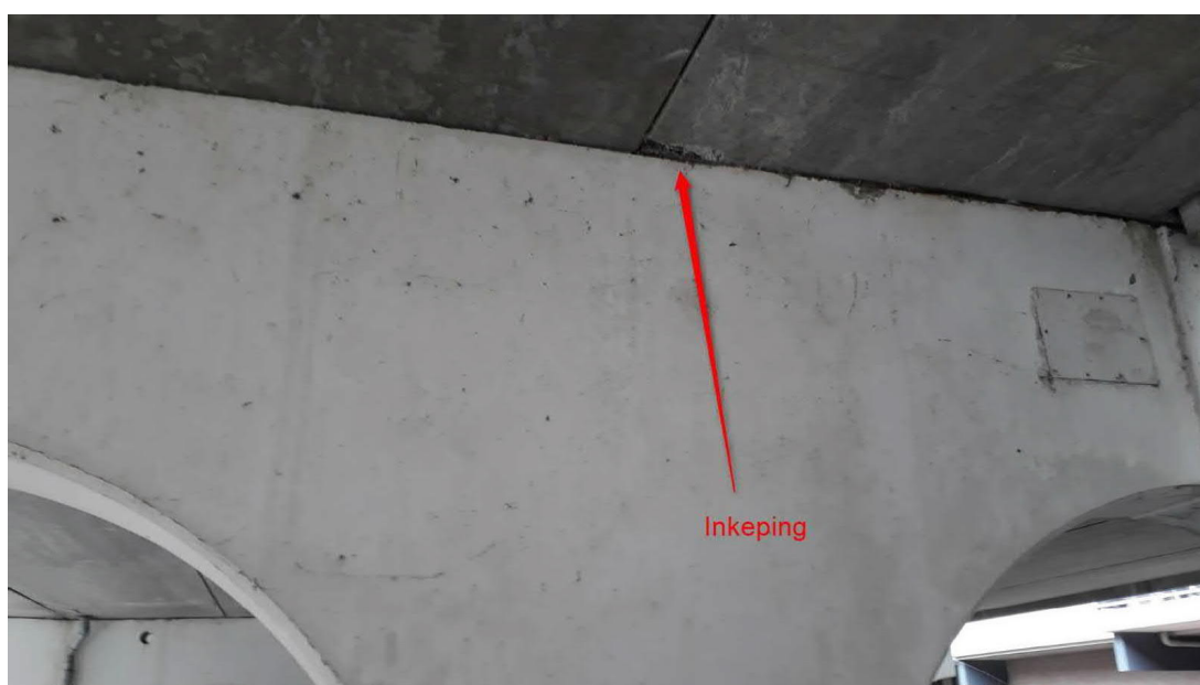
Figuur 20: Inkeping aan buitenzijde van kanaalplaat hier goed te zien
