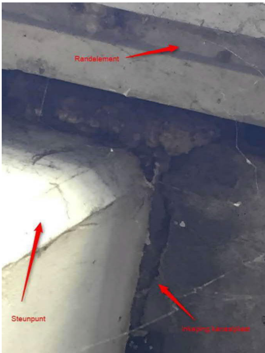
Figuur 21: Inkeping aan buitenzijde van buitenste kanaalplaat hier goed te zien
