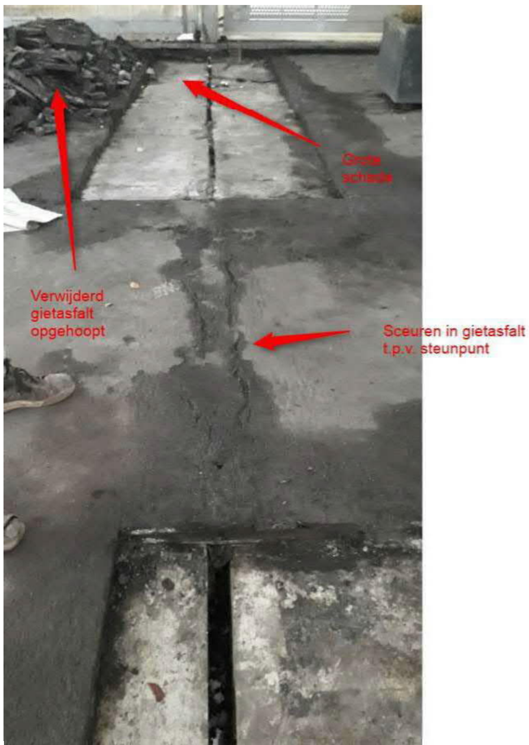
Figuur 18 Foto bij grote onderzoeksvak na slopen gietasfalt
