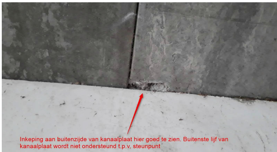
Figuur 19: Inkeping aan buitenzijde van kanaalplaat hier goed te zien
