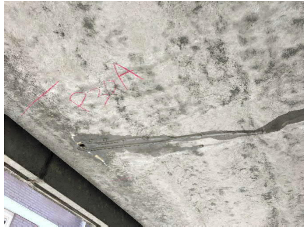
Figuur 3.6: Met water gevuld kanaal ter plaatse van Prattenburg veld 30 plaat A
