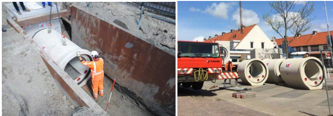
Figuur 2.3: Vrijvervalrioolwisselaar intern prefab in de gemeente Goes (bron: warmtepompen.nl)
