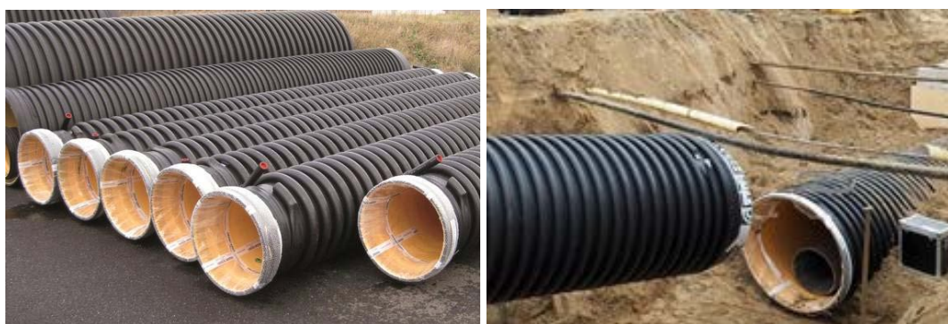
Figuur 2.4: Vrijvervalrioolwisselaar extern prefab gemeente Velsen
