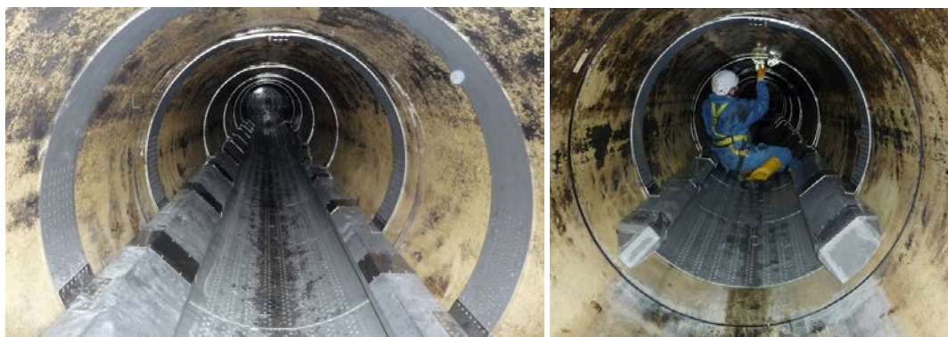
Figuur 2.2: Vrijvervalrioolwisselaar intern, deze wordt in schaaldelen ingebouwd (bron: Uhrig)
