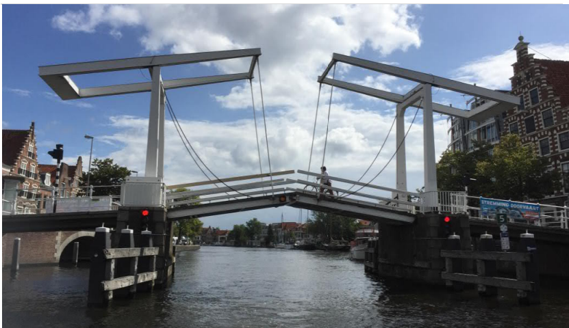
Gravestenenbrug Bouwjaar: 1950. Dubbele ophaalbrug, alleen voor voetgangers Bediening op zicht vanaf buitenlessenaar.
