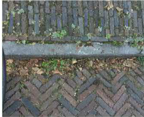
Afbeelding 2.3.5: Grote voorraad aan oude gebakken klinkers in verschillende formaten. Trottoirbanden van natuursteen komen nog veel voor
