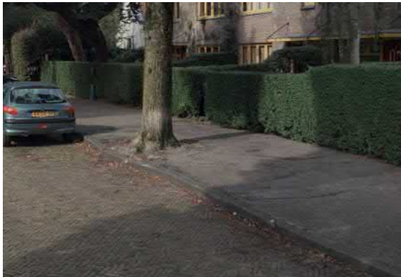
Afbeelding 3.3.5: asfalt trottoir Zuid-West (Spaarnelaan)
