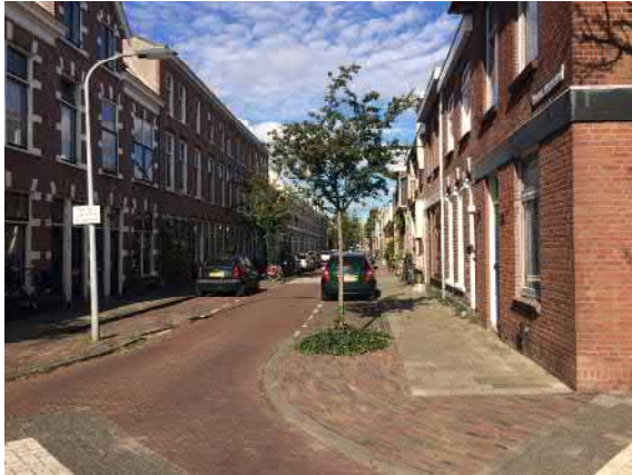
Afbeelding 5.2.21: Trottoirhoeken zijn vaak verbijzonderd met gebakken klinkers
