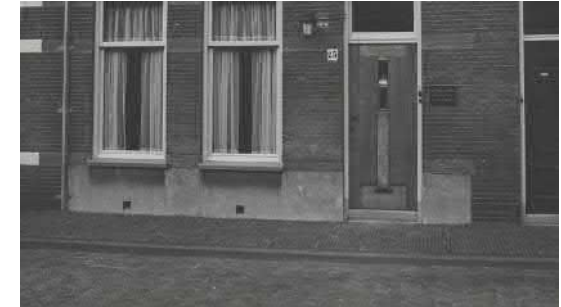
Afbeelding 5.2.8: Lordensstraat (1965), klinkers in trottoir
