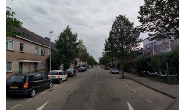
Afbeelding 5.3.32.: Asymmetrische profielen, rijbaan vaak asfalt, soms gebakken klinkers, parkeren haaks en langs op betonklinkers, bij smallere profielen half op trottoir 30x30 tegels.
