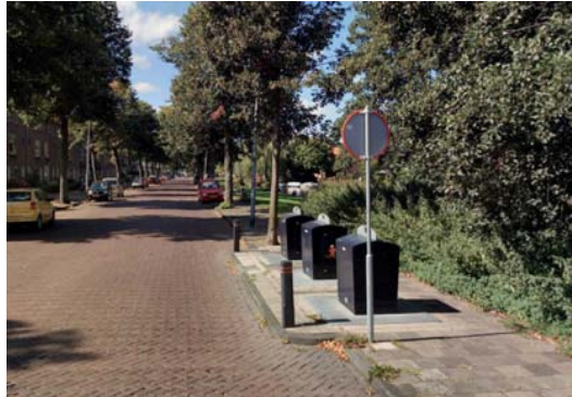
Afbeelding 3.4.3.: Gebrekkige inpassing ondergrondse vuilcontainers. Aandacht voor detailuitwerking in het lengteprofiel is nodig
