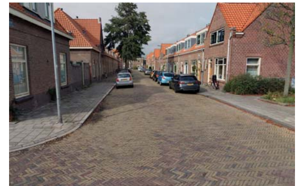
Afbeelding 3.4.1.: In de Zwaardstraat is de oorspronkelijke indeling met rechte banden nog aanwezig.
