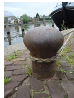
Authentieke gietijzeren bolders worden langs de Spaarndamseweg gebruikt als antiparkeervoorziening
