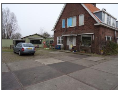
Figuur 4. Te slopen voormalig kantoor.
