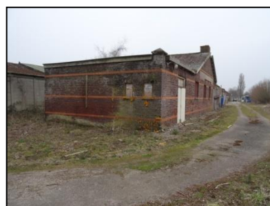
Figuur 5. Voormalige te slopen fabriekshal.
