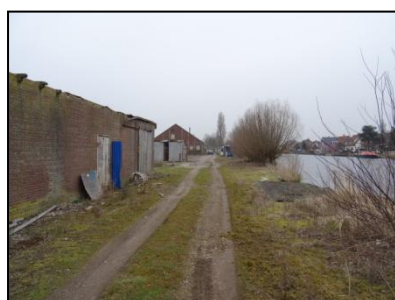
Figuur 6. Overzicht onderzoekslocatie, met te slopen fabriekspand.
