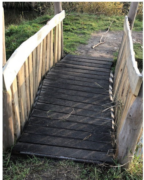
Brede brug in de Kweektuin
