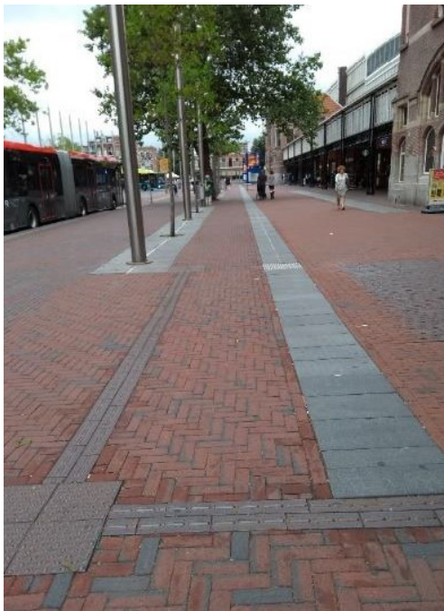
Smalle en onvoldoende contrasterende geleidelijnen op het stationsplein en geleidelijnen op de busbaan
