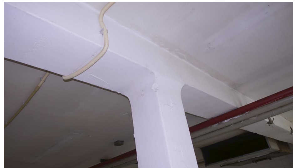
Detail van een omstucte kolom op de begane grond van het achterste bouwdeel.
