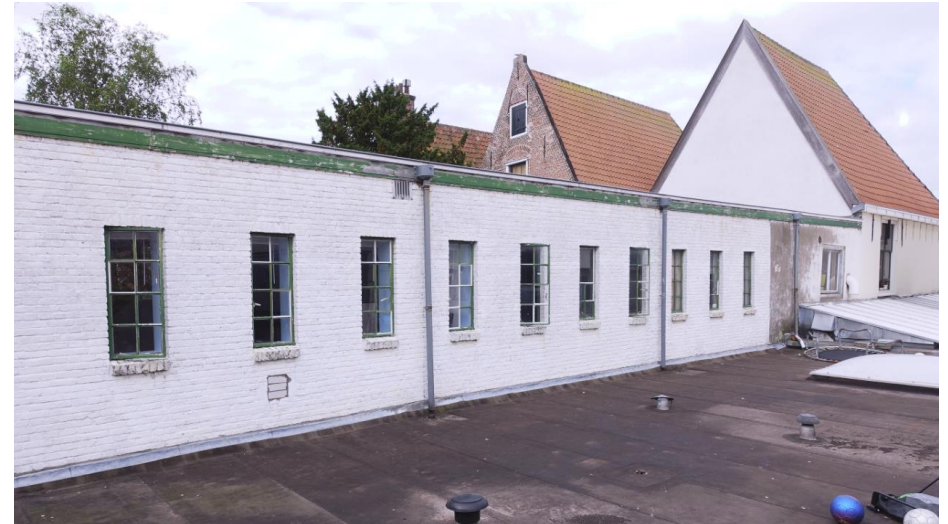
Zicht op de noordelijke zijgevel bij het bouwdeel uit 1935, gezien naar de Houtmarkt.
