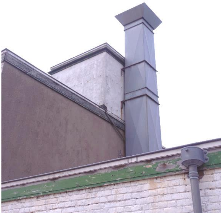
Zicht op de achtergevel van het voorste bouwdeel met de schoorsteen en liftkoker.
