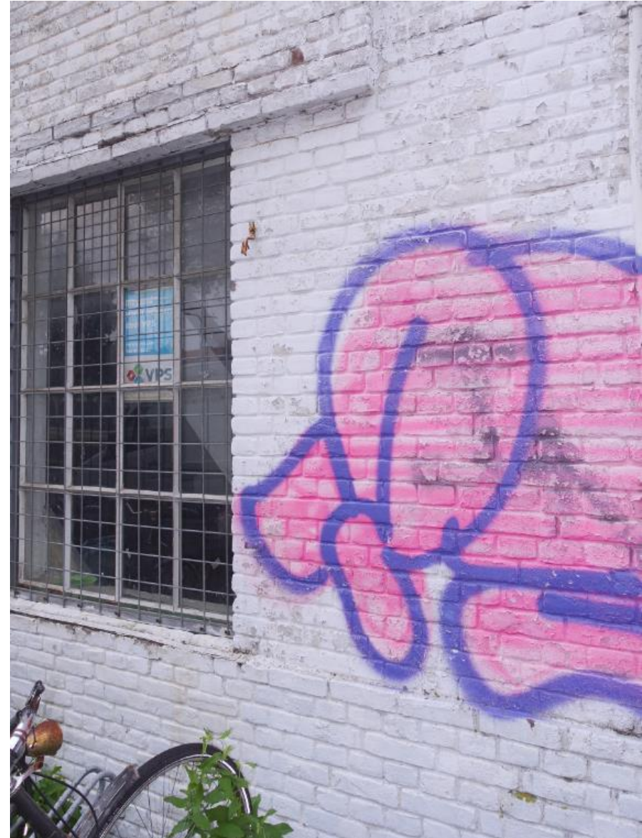
Detail van de voorgevel met het venster waar van oorsprong een doorgang was gesitueerd. Deze is in 1931 dichtgezet. De herstellingen zijn amper zichtbaar in het muurwerk.
