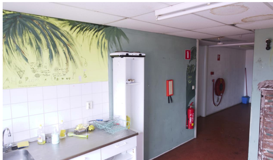
Zicht op de overloop op de tweede verdieping aan de achterzijde van het voorste deel, gezien naar het zuiden.
