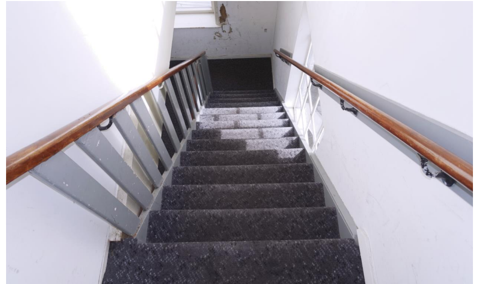
Zicht op de trapopgang tegen de voorgevel van het voorste deel.
