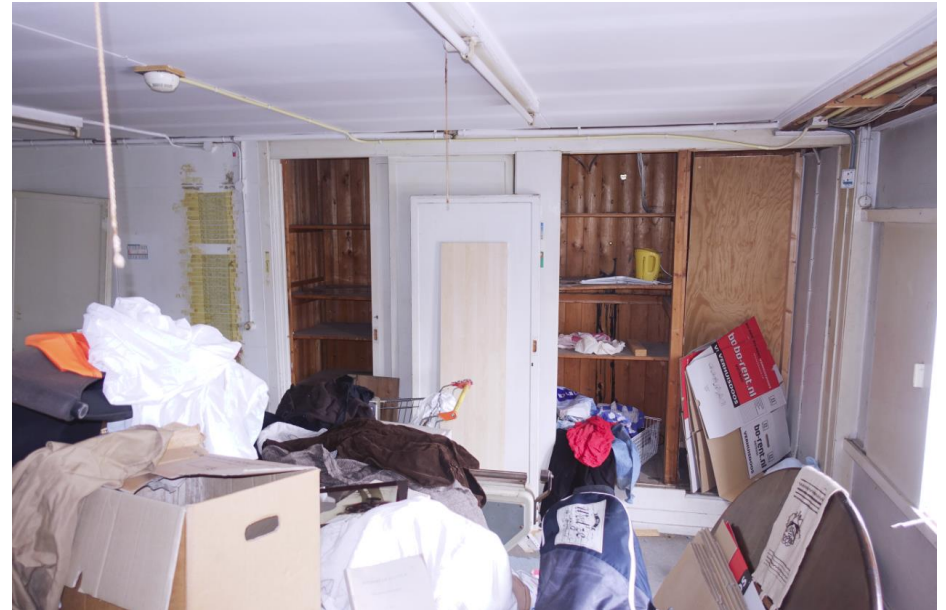
Zicht op de kastenwand in de verbindende ruimte op de verdieping tussen Oostvest 54-56 en Houtmarkt 7.
