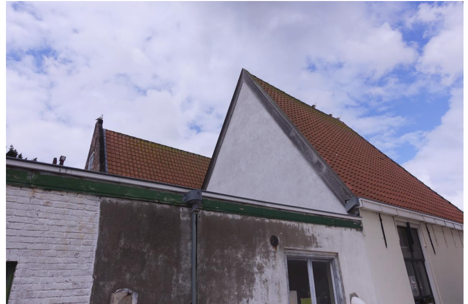
Zicht op de aansluiting van het achterste deel uit 1935 met de bebouwing op Houtmarkt 7, dat duidelijk herkenbaar is aan de topgevels.
