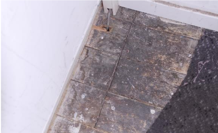
Zicht op de houten vloerdelen van de tweede verdiepingsvloer.
