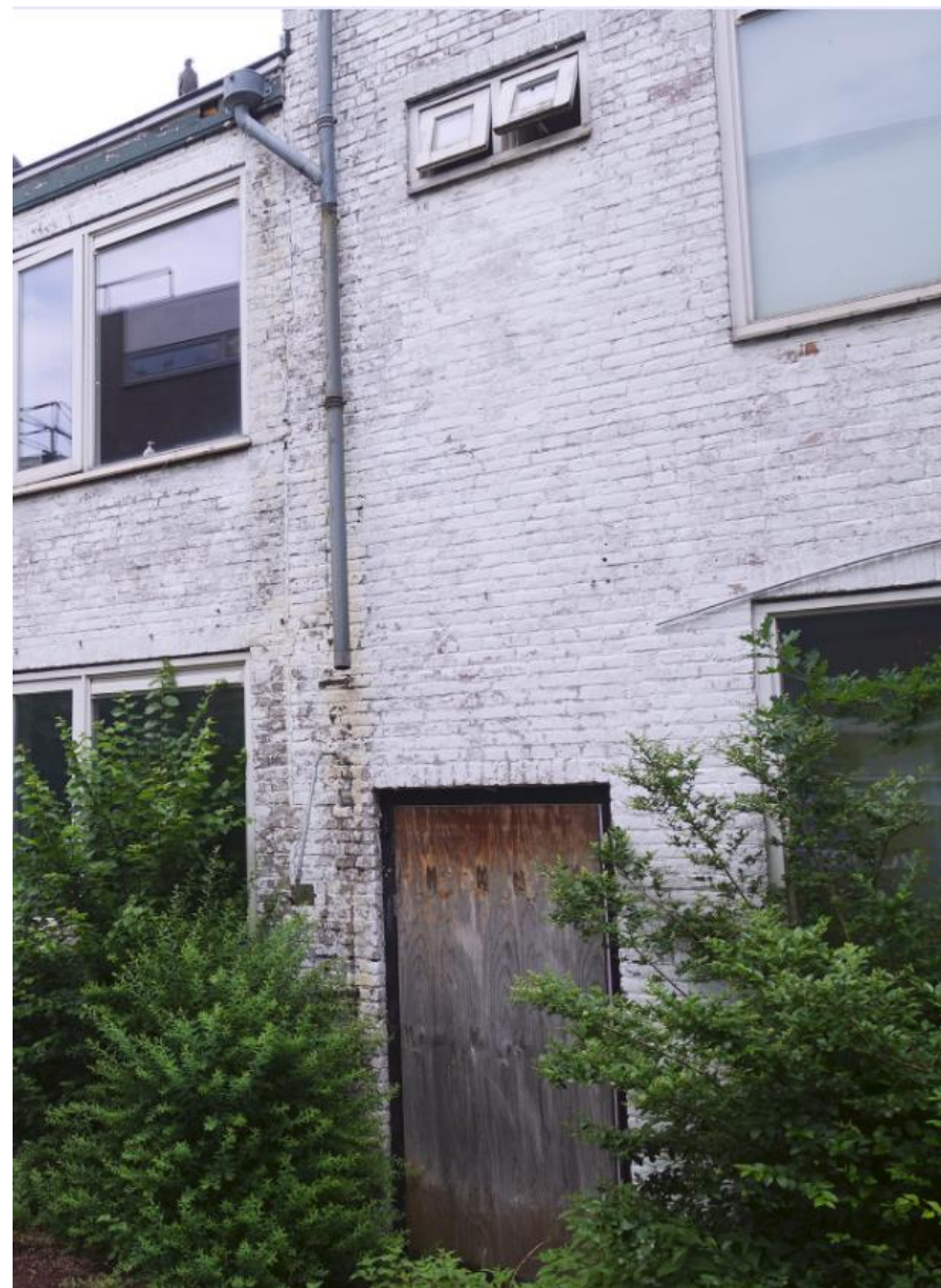
Zicht op de entree in de zuidgevel uit 1954 die thans is dichtgezet. Ook het venster met dubbele ramen is uit 1954.
