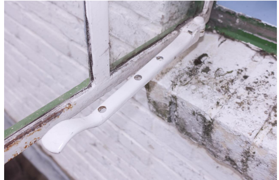
Detail van het sluitwerk bij een van de ramen uit 1935 in de noordgevel van het achterste bouwdeel.
