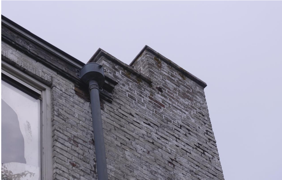
Detail van de verhoogde hoek bij de voorgevel/zuidgevel.
