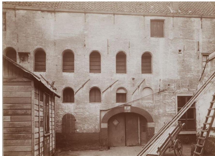
Foto uit 1917 van de noordgevel van het gebouw achter Houtmarkt 7, gezien richting het zuiden. NHA beeldbank, nr. NL-HlmNHA_559_004040.
