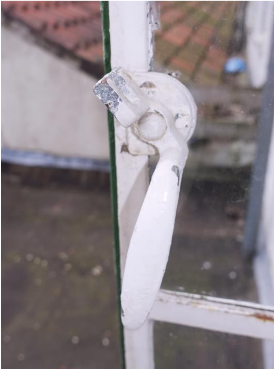
Detail van het sluitwerk bij een van de ramen uit 1935 in de noordgevel van het achterste bouwdeel.
