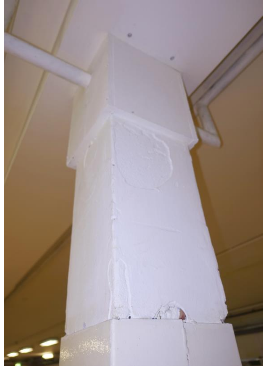
Detail van een omstucte kolom op de begane grond van het voorste bouwdeel.
