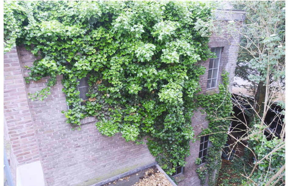
De achtergevel van het achterste deel kijkt deels uit op een binnentuin die achter Houtmarkt 7 is gelegen en bezit nog de oorspronkelijke vensters met vulling.
