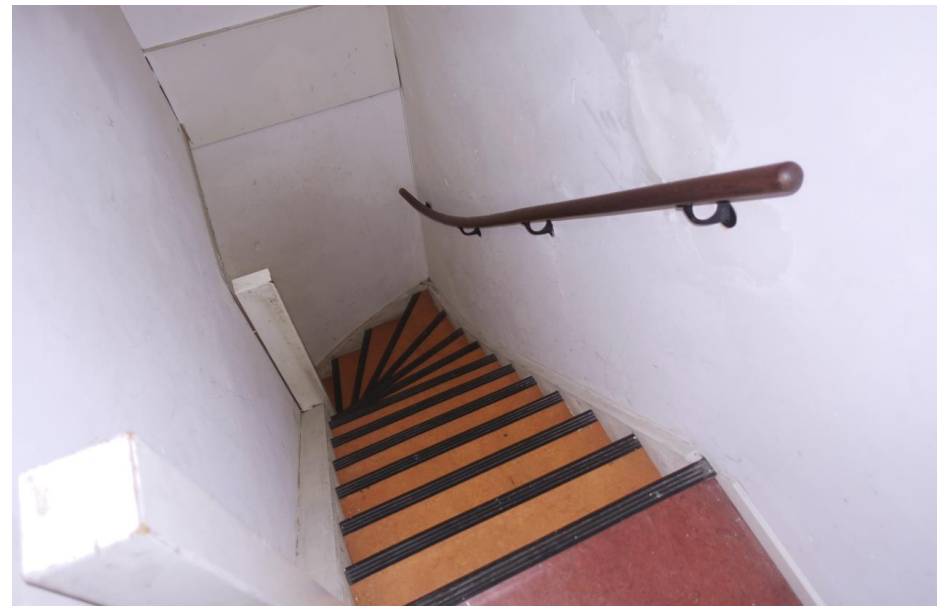
Zicht op de trapopgang aan de achterzijde van het voorste deel.
