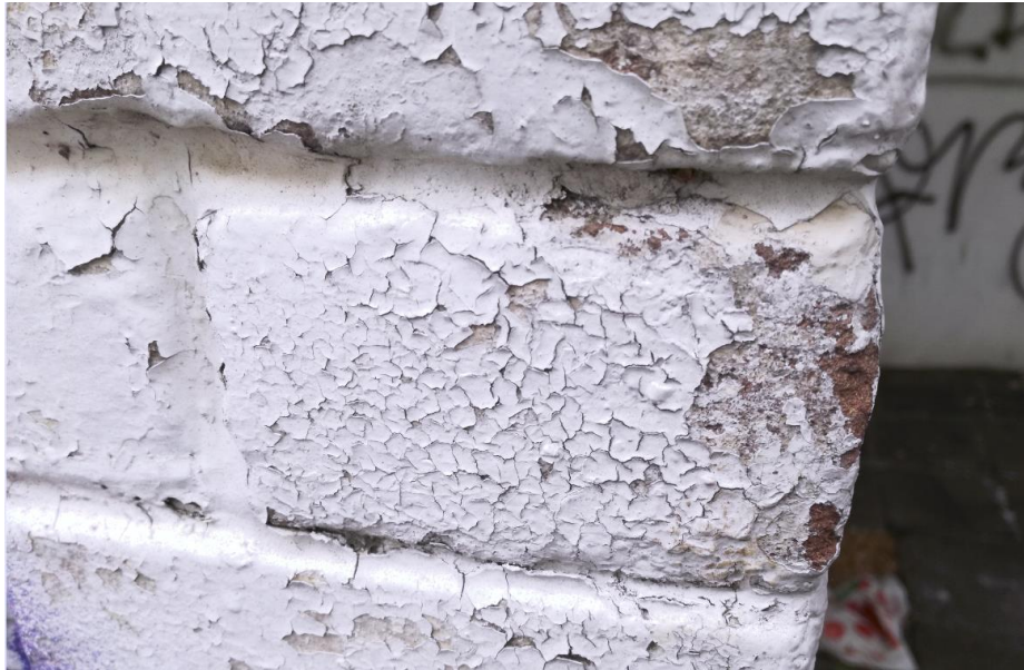
Detail van het metselwerk van de voorgevel met verschillende lagen witte verf.
