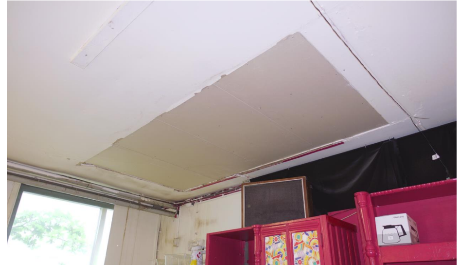
Het plafond boven de begane grond bestaat uit houten plaatmateriaal. Ter hoogte van de trapopgang tegen de achtergevel van het voorste deel is een dichtzetting van gipsplaten aanwezig.
