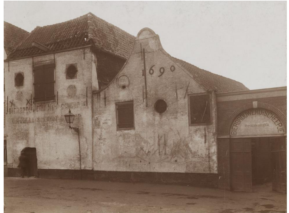
Foto uit 1917 van twee pakhuisgevels van de brouwerij en de naastgelegen toegangspoort tot het complex aan de Houtmarkt 5. De opschriften op de gevels lezen: 'BIERBROUWERIJ HET SCHEEPJE VAN DER AA - SCHMID & COMP', het jaartal "1690", en opschrift op het boogveld boven de poort: "BIERBROUWERIJ 't SCHEEPJE OPGERICHT 1351". NHA beeldbank, nr. NL-HlmNHA_53000250_M.
