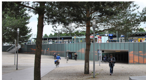
Plein met glooiende overgang naar fietstunnel
