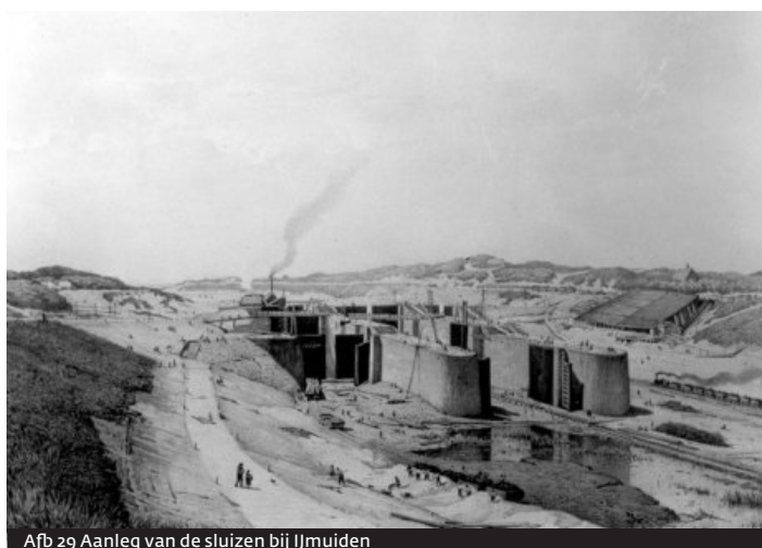
Afb 29 Aanleg van de sluizen bij IJmuiden
