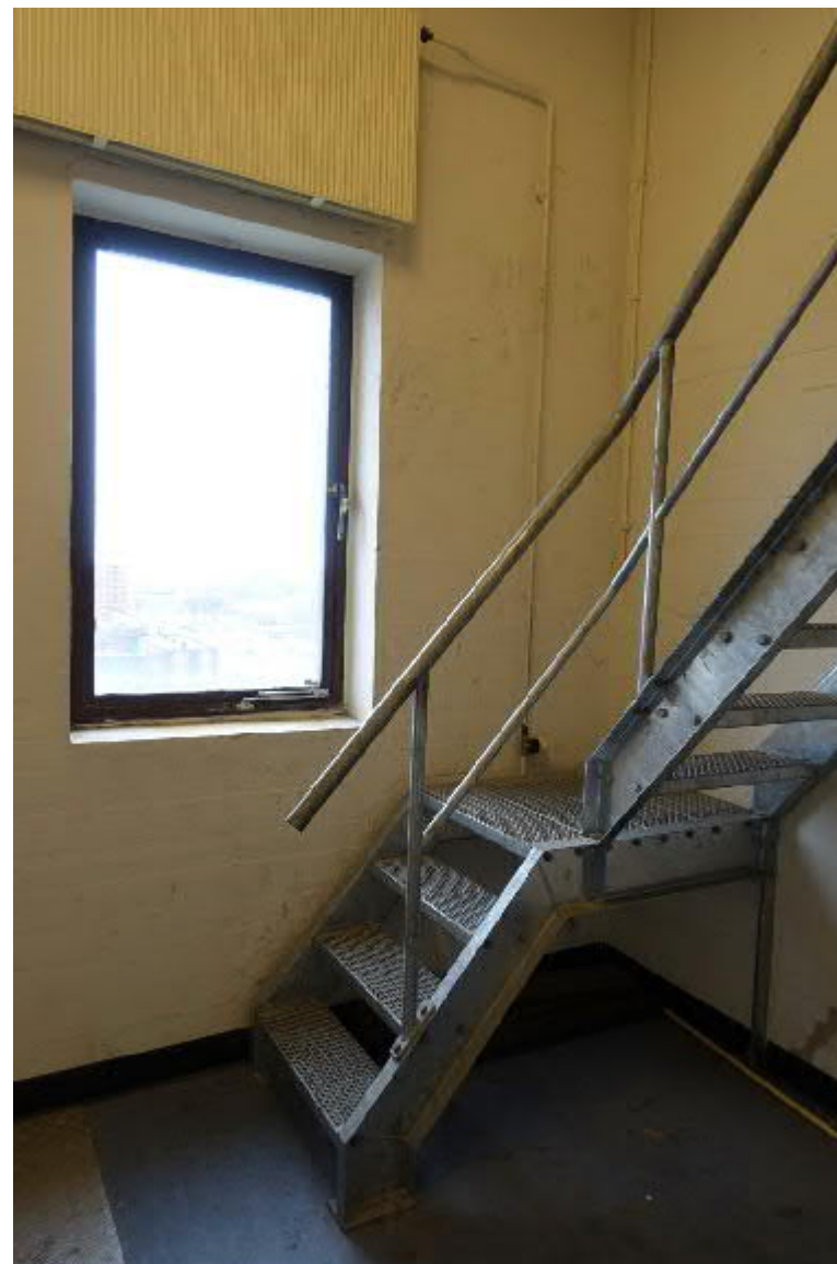
Een stalen dienstrap naar de zolder in gebouw 2 naar het noorden gezien. FH MAB 2019
