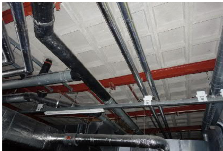
Zicht op de betonnen dakplaten met stalen liggers in gebouw 2 naar het zuiden gezien. FH MAB 2019
