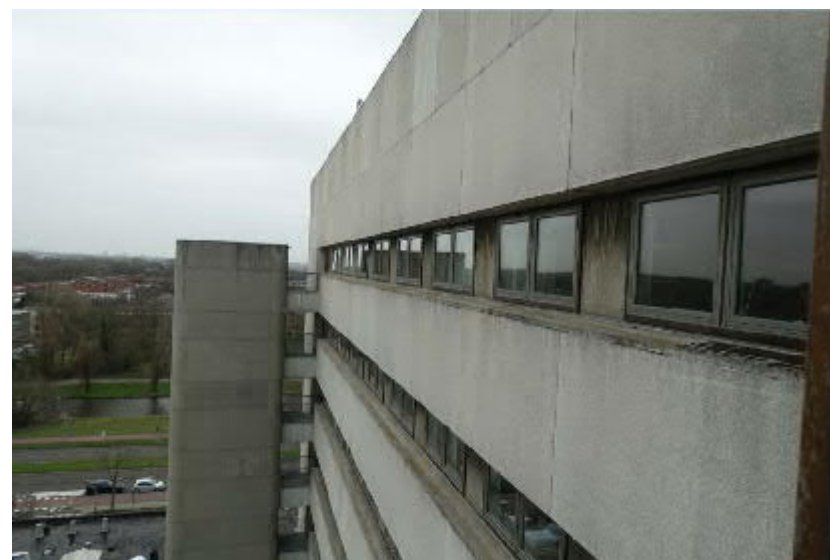
De noordgevel van gebouw 3 met vluchttuipen is geheel als elementenbouw in betonplaten uitgevoerd. FH MAB 2019
