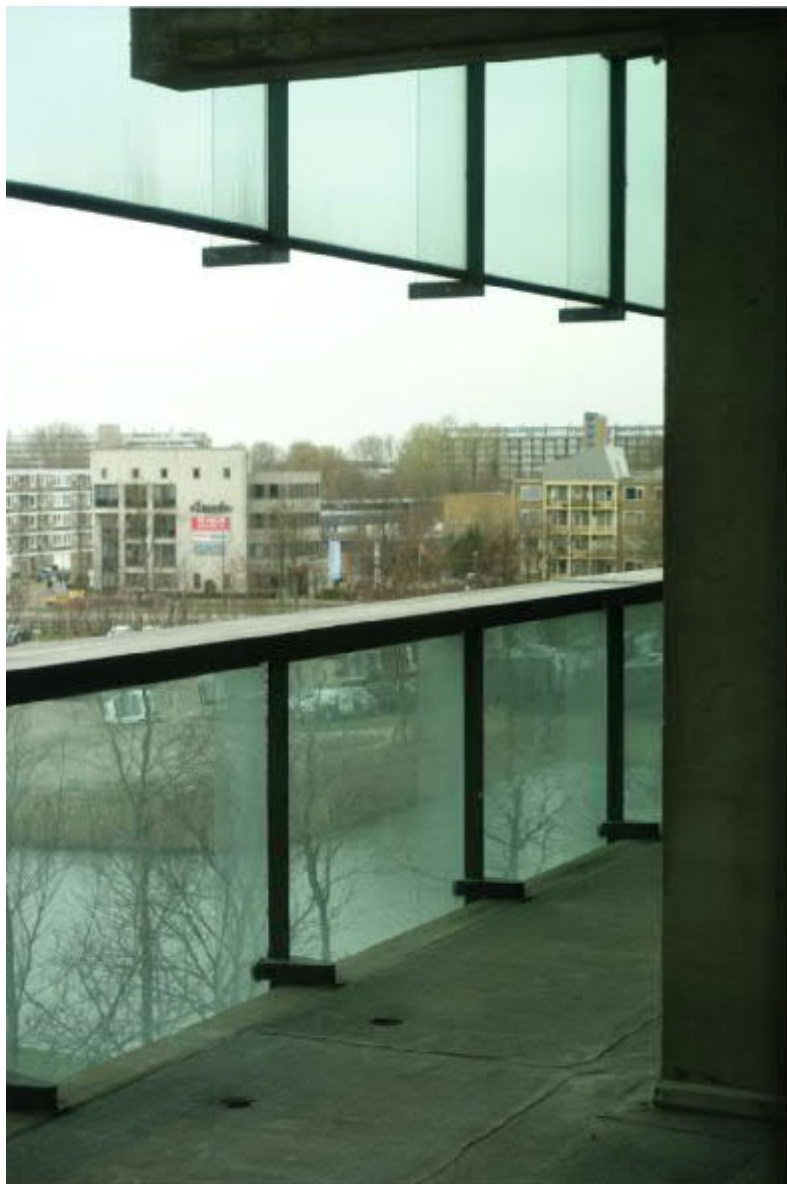
De galerijen hebben een borstwering en zonwering in zonwerend glas in stalen frames. FH MAB 2019
