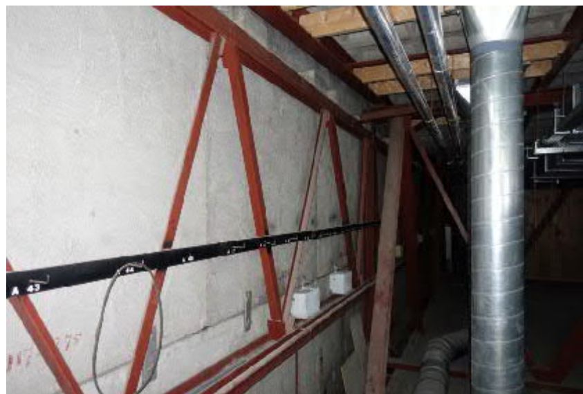
De betonnen gevelplaten van de zolderverdieping zijn gekoppeld aan een stalen vakwerkligger. FH MAB 2019
