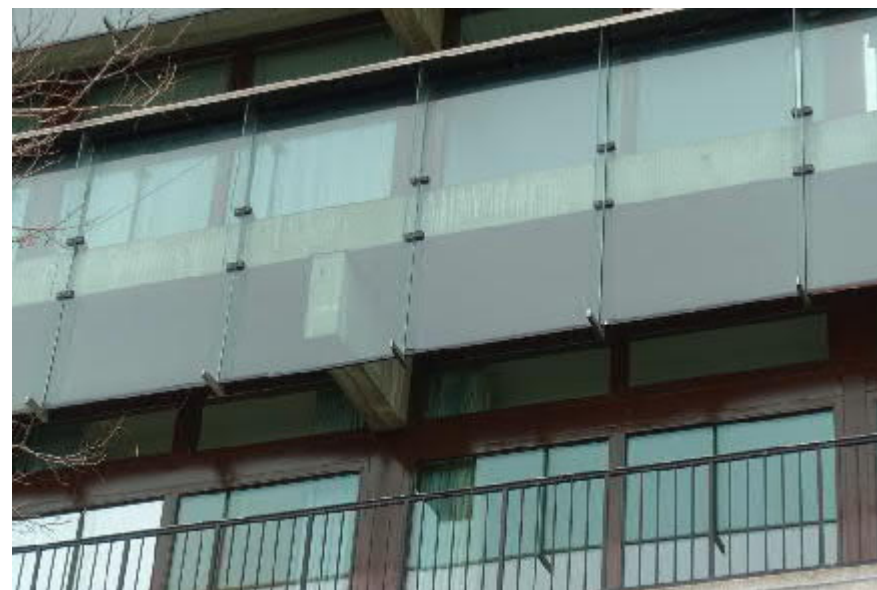
Detail van de balkon en balustradeconstructie met het zonwerende glas. FH MAB 2019
