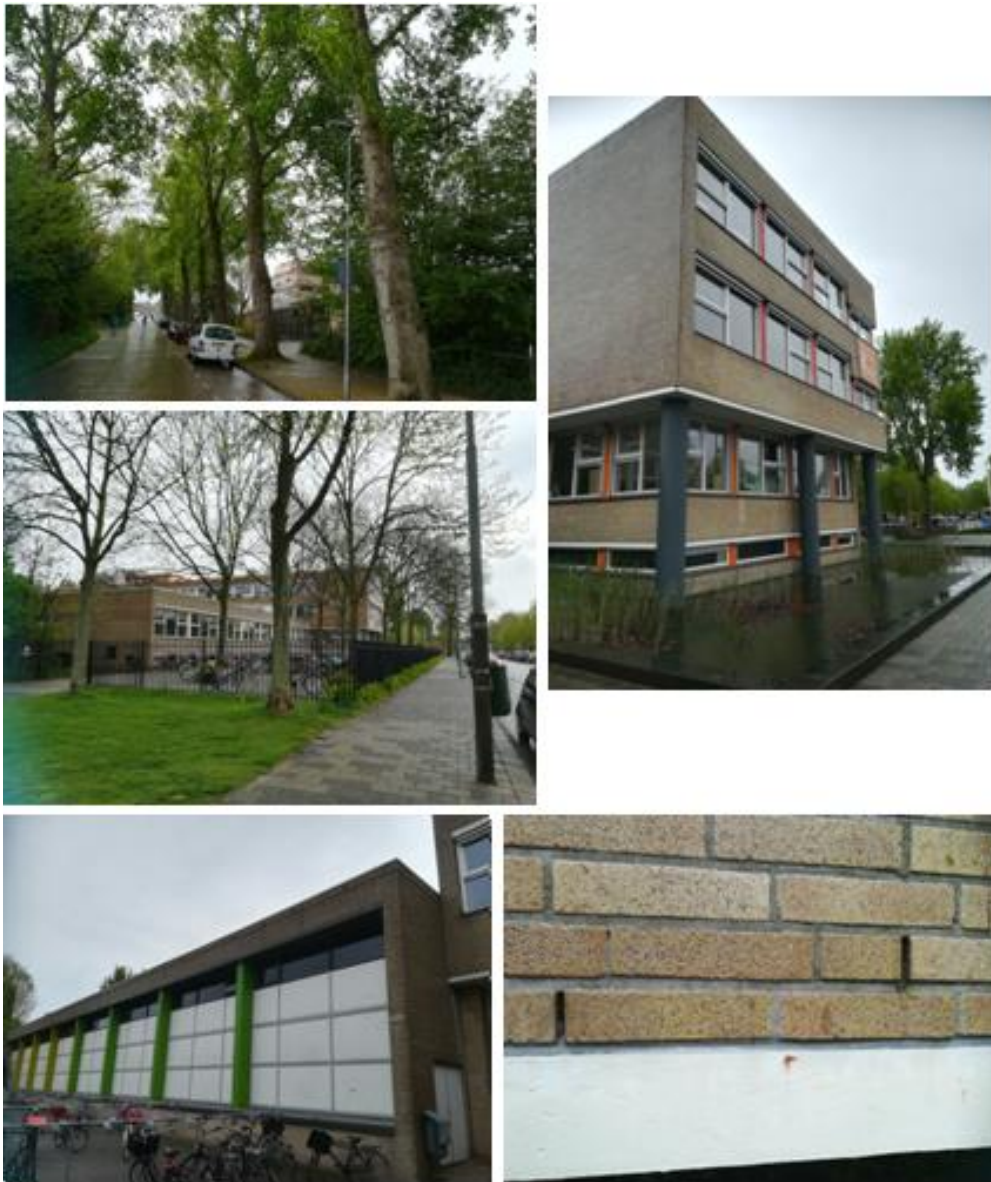
Figuur 3: linksboven: de sportweg waaraan de gymzaal grenst, rechtsboven: gedeelte van de vijver op het schoolplein, midden: Het Schoter vanaf de planetenlaan, linksonder: de gymzaal, rechtsonder: ventilatiegaten die ook bovenaan de gymzaal zijn aangetroffen.
