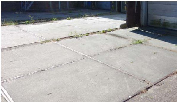
betonplaten op het terrein
