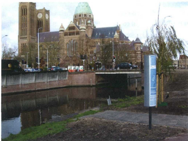
Aanleglegsteiger aan de Noorder Emmakade
