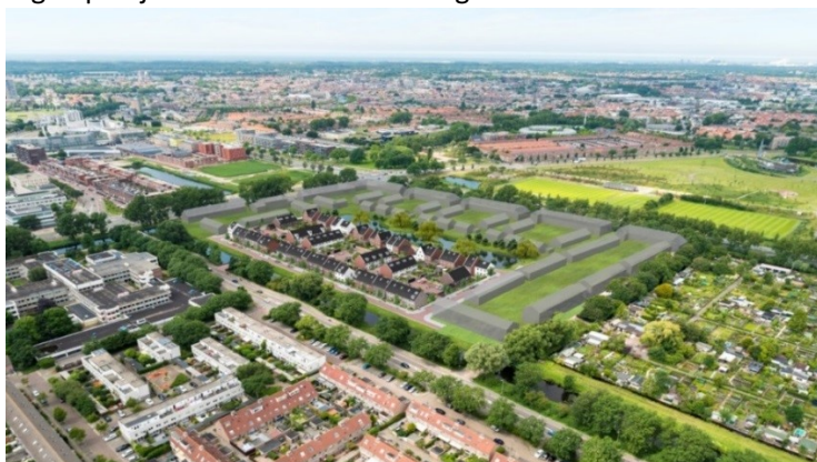
Project de Entree (Vijverpark)
