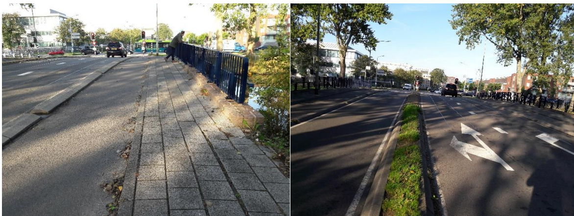
Figuur 2-2: Foto's huidige indeling brugdek
