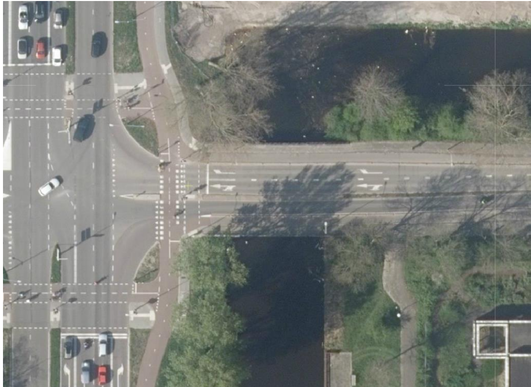
Figuur 3-1: Overzicht brug
