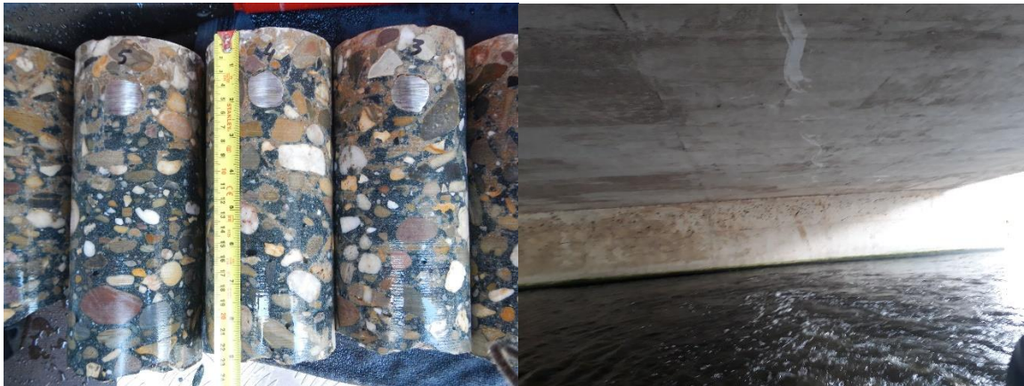
Figuur 3-7: Foto's inspectie en kernen boren (d.d. 5 juli 2019)
