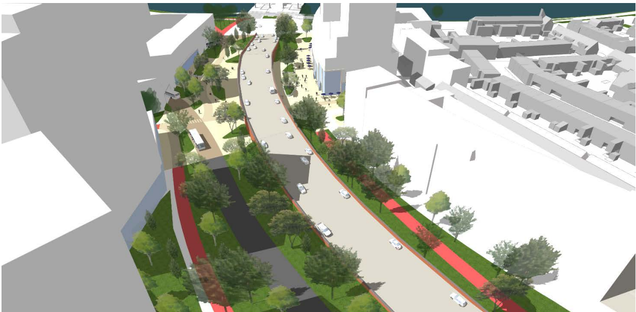
Een viaduct garandeert de doorstroming van auto's en biedt de kans om verkeersstromen te scheiden
