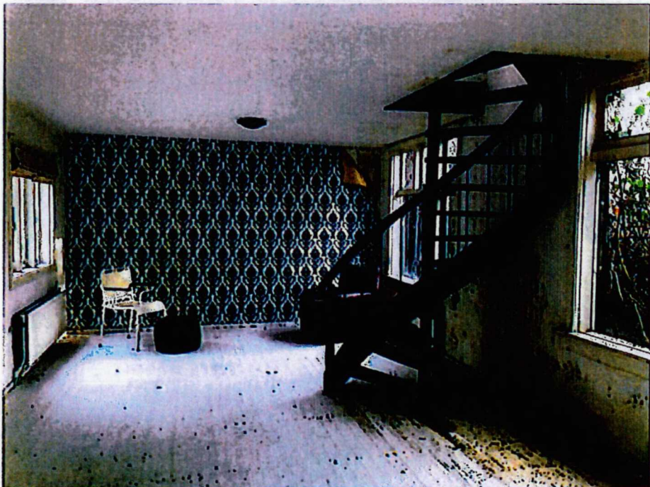
12 - woonkamer op de begane grond. De houten spiltrap is in 1976 aangebracht, waarbij tevens de huidige vorm van de woonkamer door samenvoeging van twee kamers en een gang plaatsvond.
