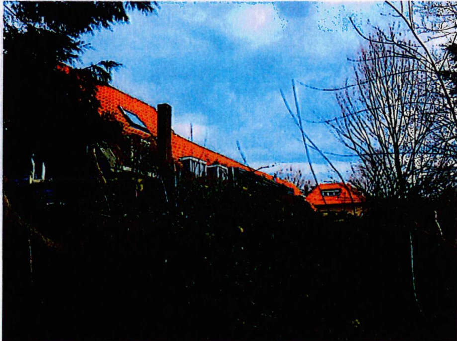
11 - het overwoekerde perceel biedt weinig zicht op de zuidelijke langsgevel. Oorspronkelijk was aan deze zijde over de volle lengte een kas geplaatst. Het dakvlak is voorzien van nieuwe dakpannen.
