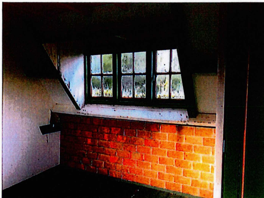
13 - overloop op de zolderverdieping. De indeling van de zolder dateert uit 1976. Er is toen ook een borstwering van porisostenen aangebracht. De dakkapel dateert van 1922, gelet op de profielen van de roedes en het raambeslag.
