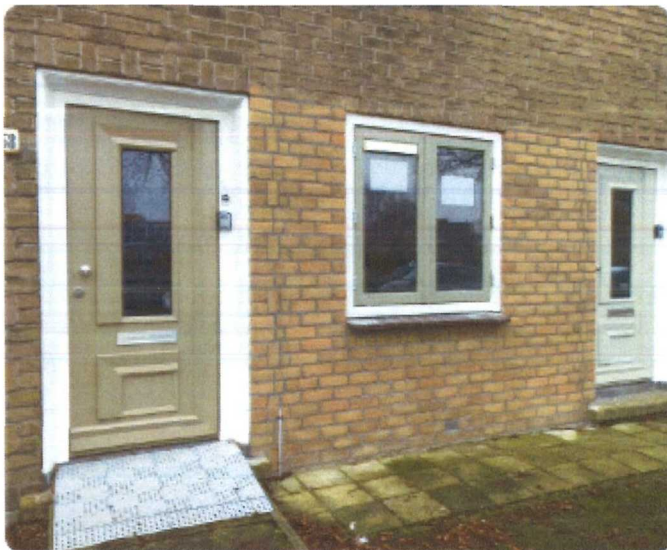
De vernieuwde gevel in de Dirk Schaferstraat
