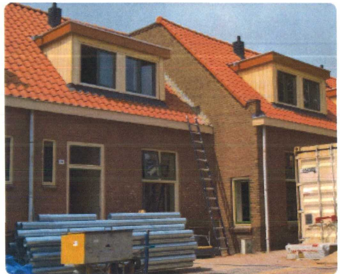
Renovatie en verduurzaming van woningen in Bavodorp
