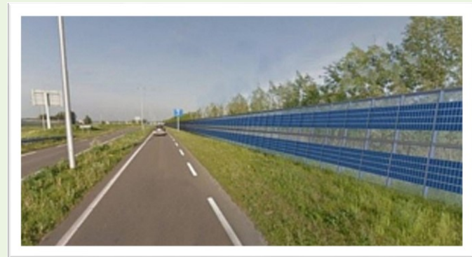
Panelen geïntegreerd in geluidsscherm
