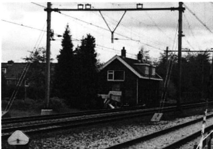
Spoorwachterswoning Koppestokstraat 2-4 te Haarlem. Dit is spoorwachterswoning 26A. Onder het bovenraam nog de plek waar de oorspronkelijke nummering van de woning heeft gezeten.
