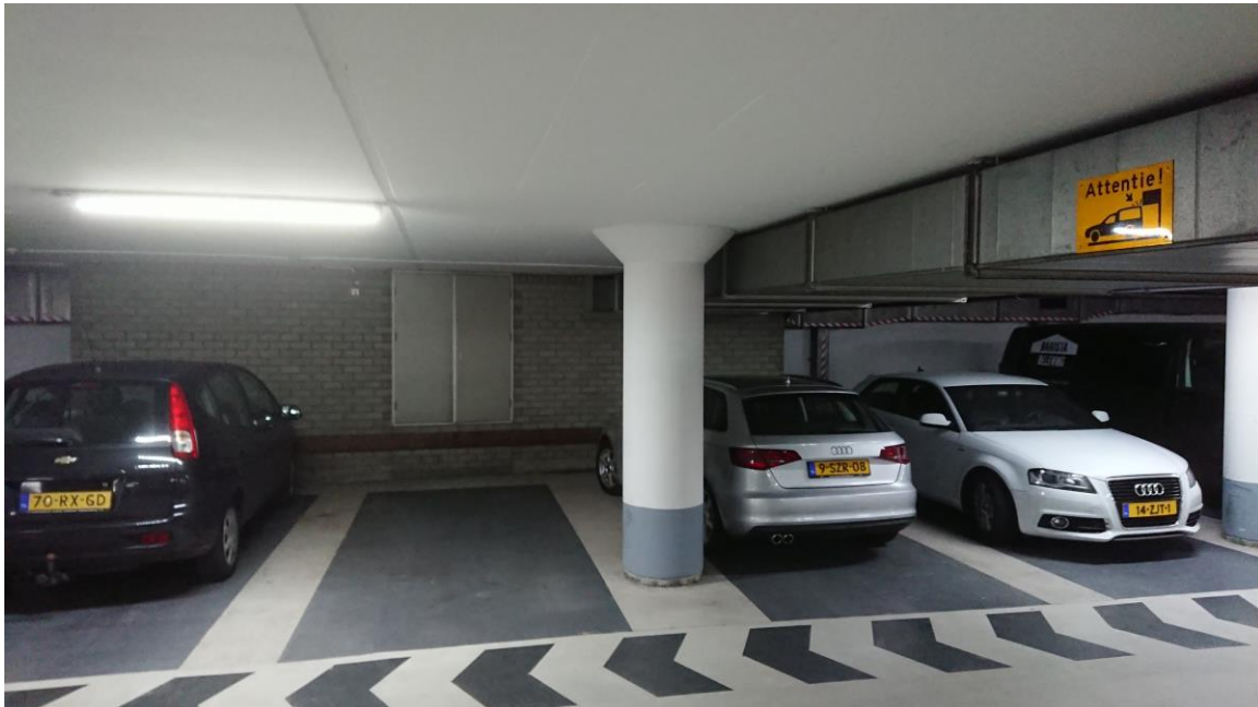
Afbeelding 5.2 Techniekruiimte in parkeergarage op laag -1
