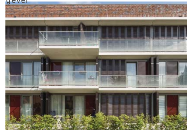
uitkragende balkons aan de tuinzijde
