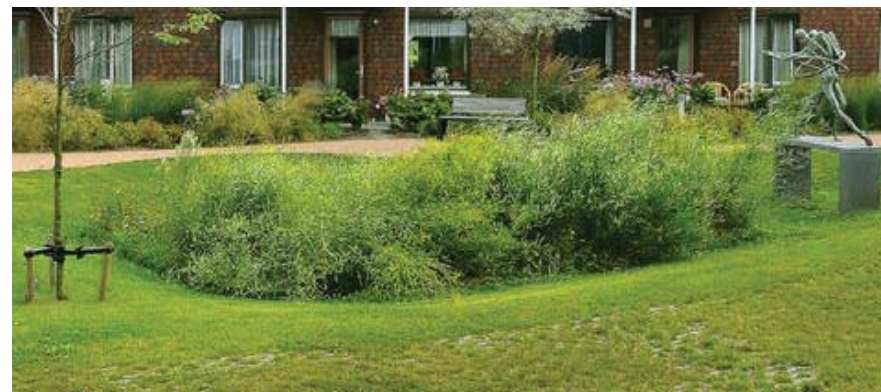
^ Infiltreren van water in het naastgelegen parkje
