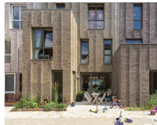
details in het metselwerk
