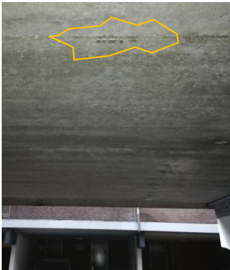
Tegenover Engelenburg 8, tussen de kanaalplaten
