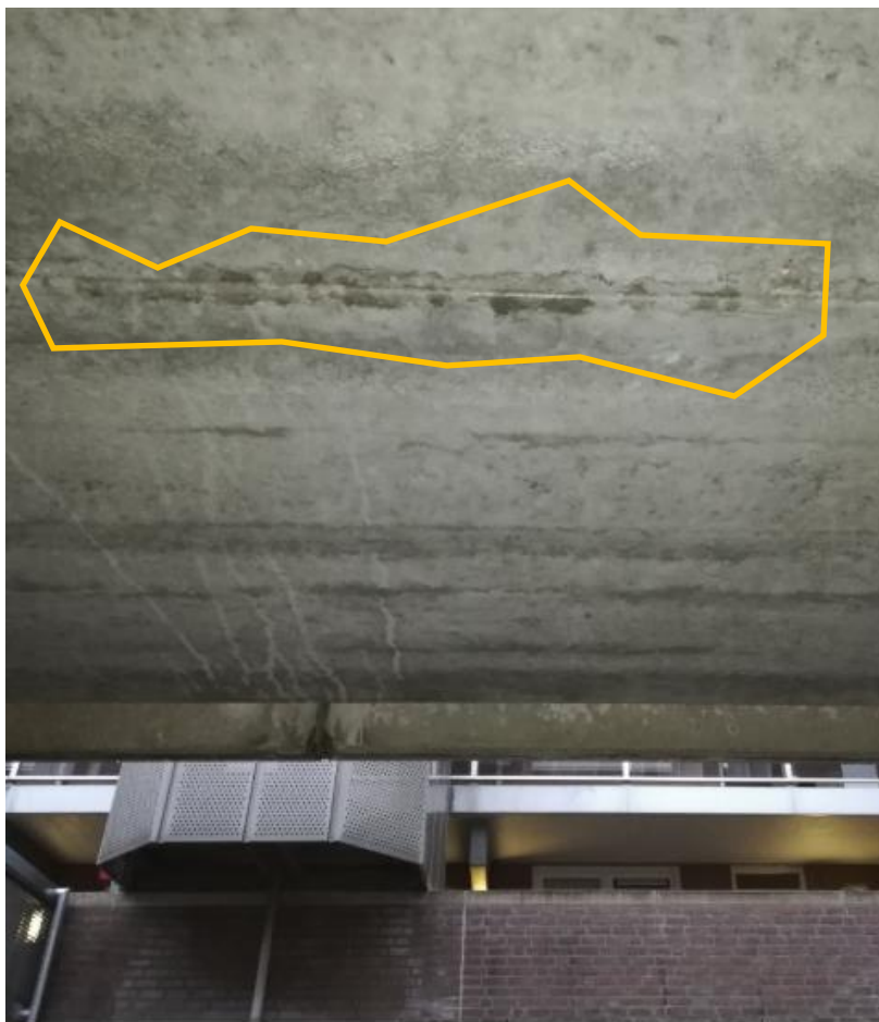
Tegenover Engelenburg 10, tussen de kanaalplaten
