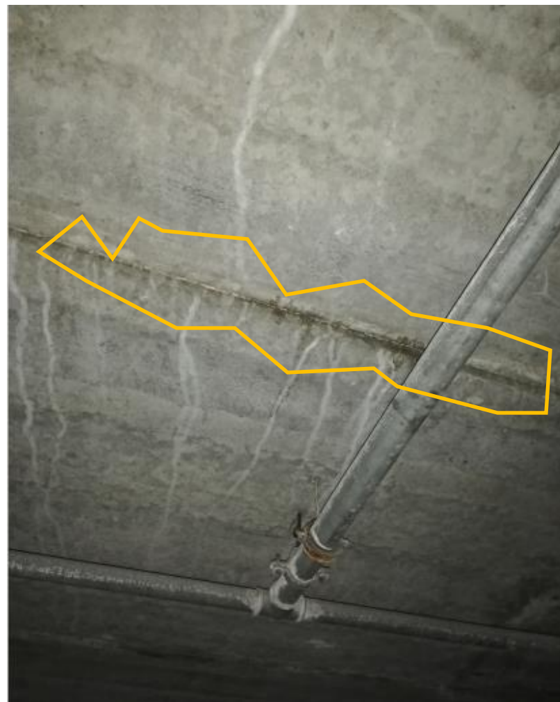
Tegenover Engelenburg 32, tussen de kanaalplaten
