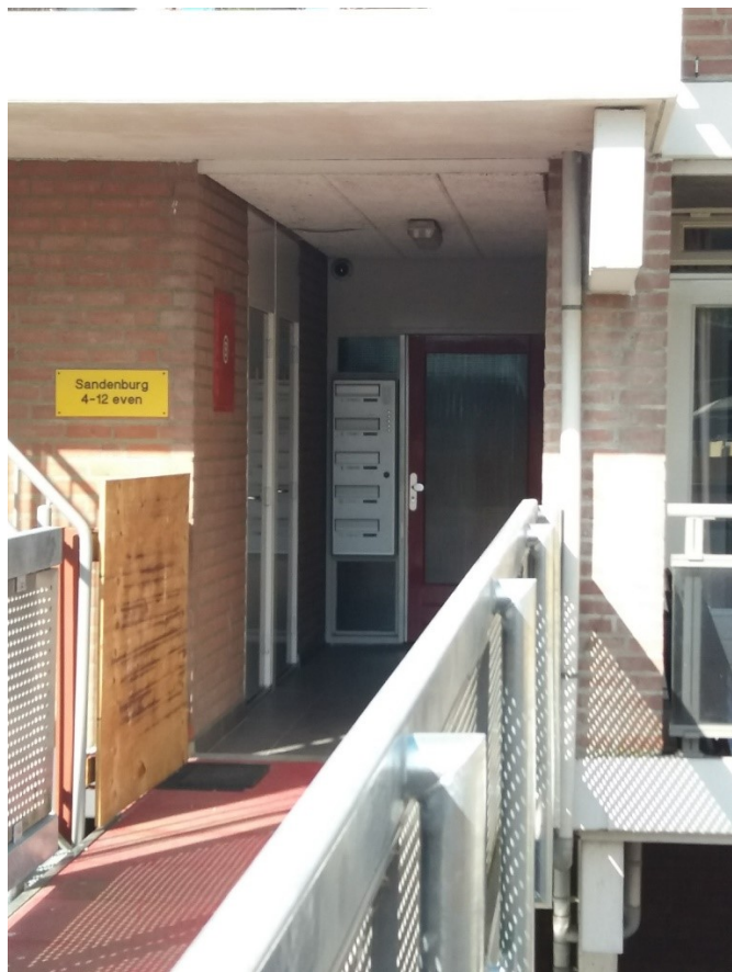
13 hwa portiek 4-12 na renovatie 20200602_093454_resized
