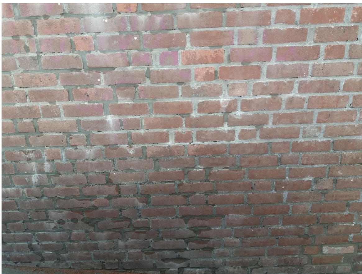
12 Sandenburg Herstel voegwerk muur hellingbaan.
