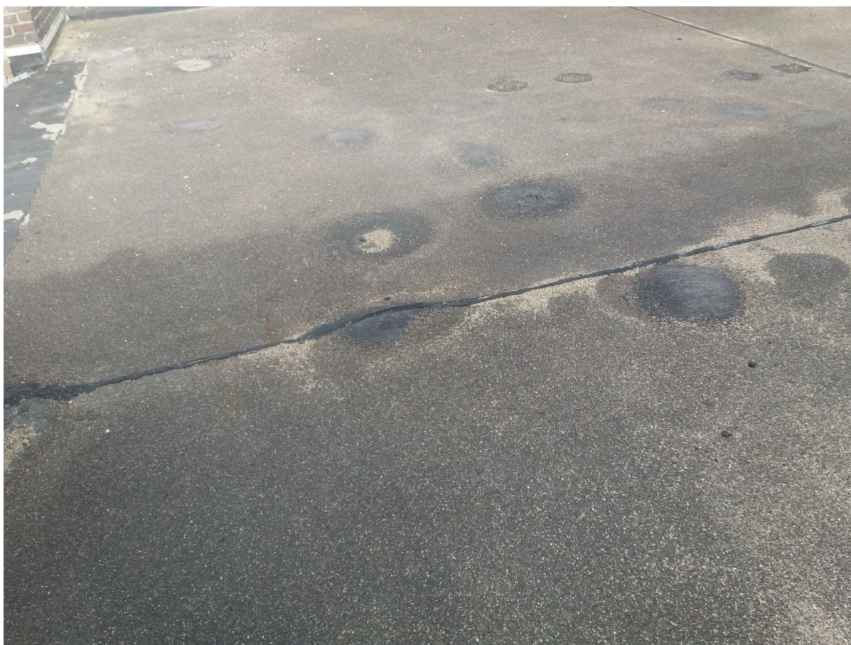
08 Gietasfalt ter plaatse van Sandenburg 2
