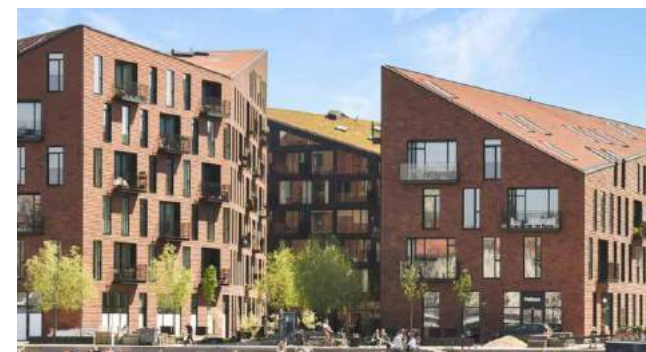
zichtbaar daklandschap en contrast in het binnenterrein
