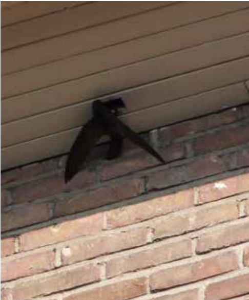
Gierzwaluwsteen weggewerkt in dakrand
