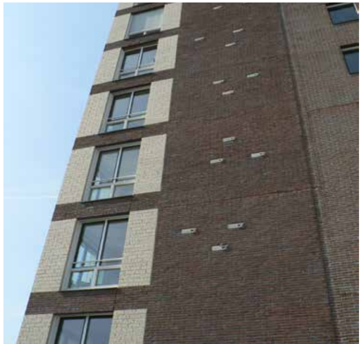
Meerdere neststenen in een gevel
