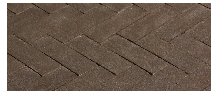
Gebakken klinker als vloer van de kade
