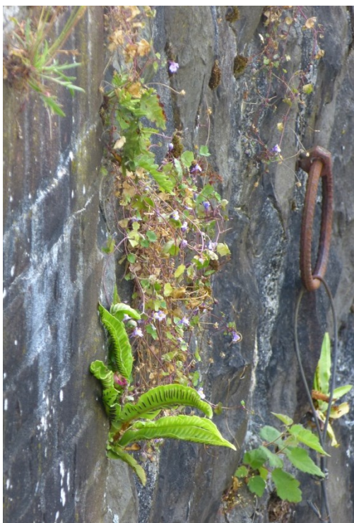
Kademuur aan de Brouwersvaart, met o.a. muurleeuwenbek en tongvaren
