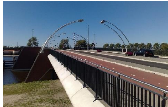
Figuur 3.1: Aanzicht Schoterbrug
