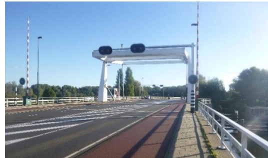
Figuur 3.8: Aanzicht Schouwbroekerbrug
