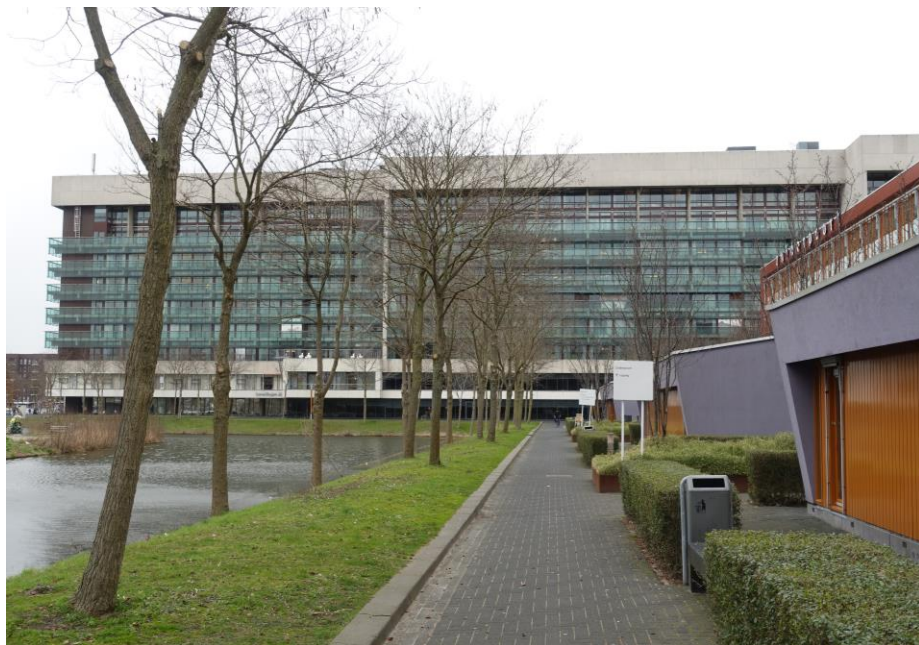
Het beddenhuis vanuit het zuiden. FH MAB 2019
