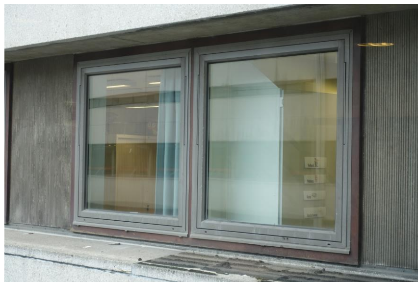
Gebouw 2 van het beddenhuis, detail verdiepte vensterstrook met tweelichtvensters en geribbelde prefabbetonpanelen (foto boven en onder). FH MAB 2019
