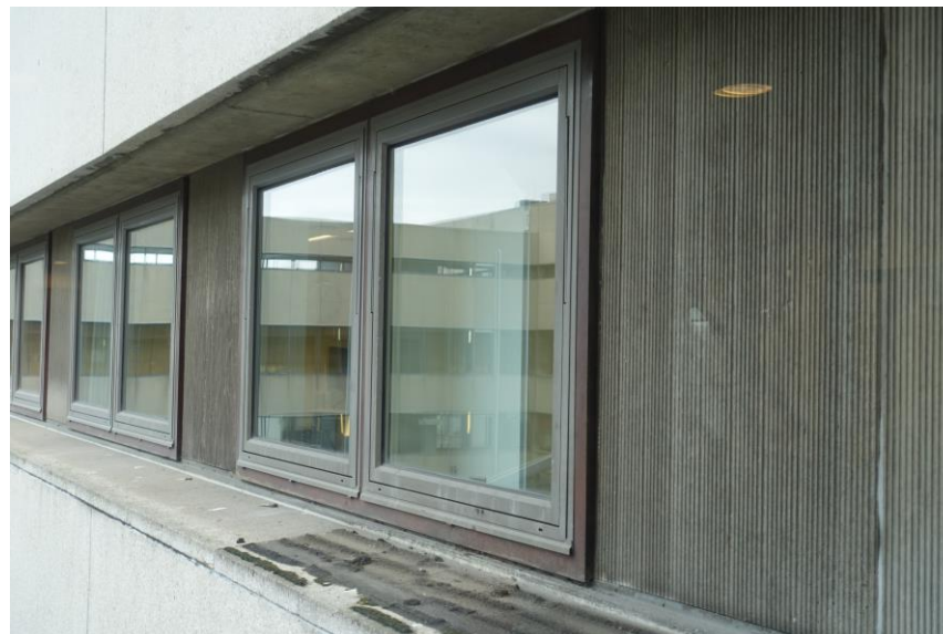
Gebouw 2 van het beddenhuis, detail verdiepte vensterstrook met tweelichtvensters en geribbelde prefabbetonpanelen (foto boven en onder). FH MAB 2019
