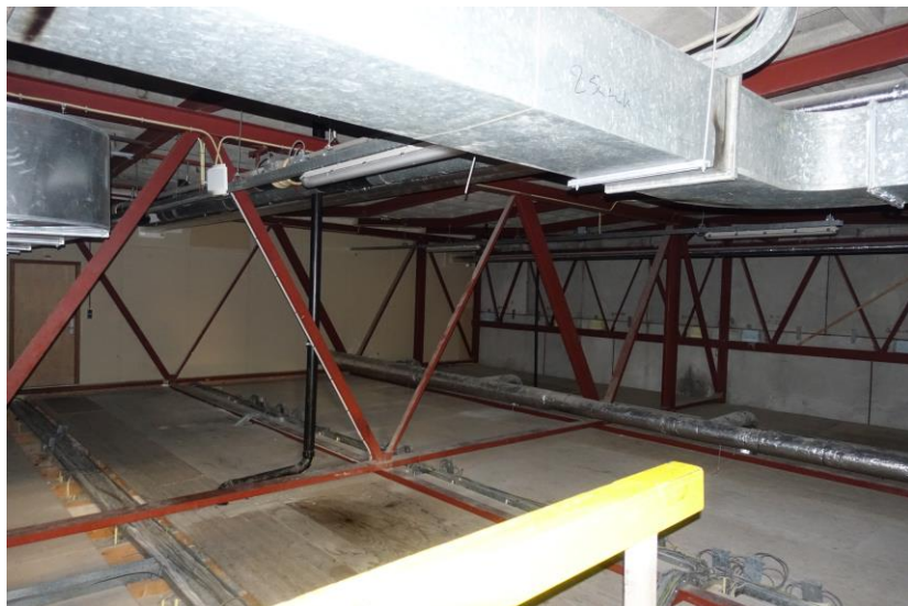
Een zolderruimte met stalen vakwerkliggers in gebouw 2 naar het zuidoosten gezien. FH MAB 2019
