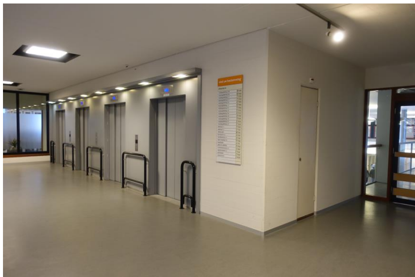
De overloop met liftensectie op de eerste verdieping in gebouw 1 naar het noordwesten gezien. FH MAB 2019
