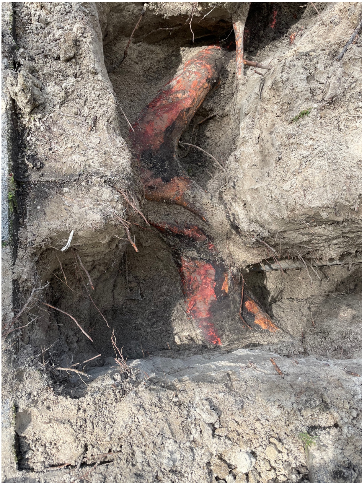
Foto 8: Als foto 7, maar in de richting van het gazon gefotografeerd. Rechts in het midden van de foto is net onder de wortel een pvc-buis aangetroffen. De wortel bevindt zich op een diepte van 60 cm.
