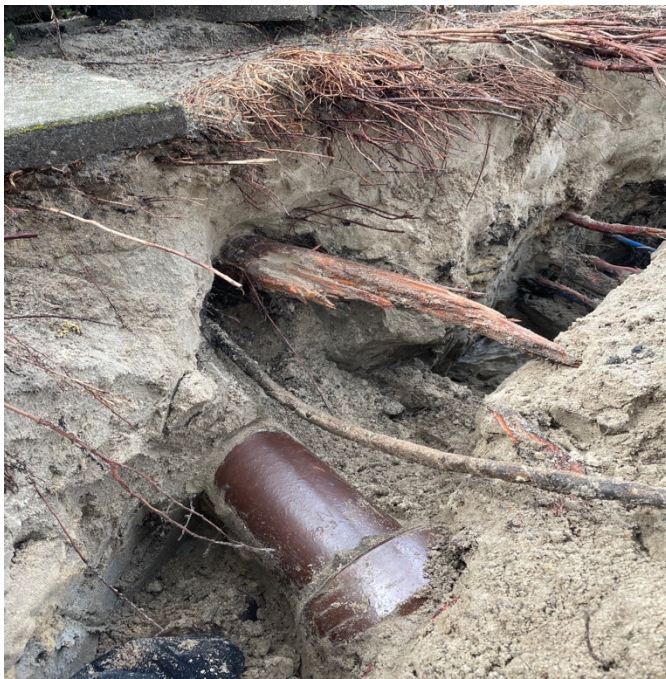
Foto 3: De proefsleuf bij boom 5. Deze staat links buiten beeld. Op de voorgrond is de door eerder graafwerk beschadigde wortel van 9 cm diameter zichtbaar samen met de gresbuis en de kabel van straatverlichting. In de bovenste 10 cm is de mat van dunne wortel zichtbaar.
