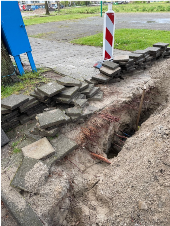
Foto 4 en 5: Links de blauwe bouwwateraansluiting aan boom 5. Op de voorgrond de proefsleuf met de wortelmat en enkele dikkere wortels. Rechts een detail van de proefsleuf met in het midden een spade en onderin de grondwaterspiegel. De bodem bestaat geheel uit grijs ophoogzand.
