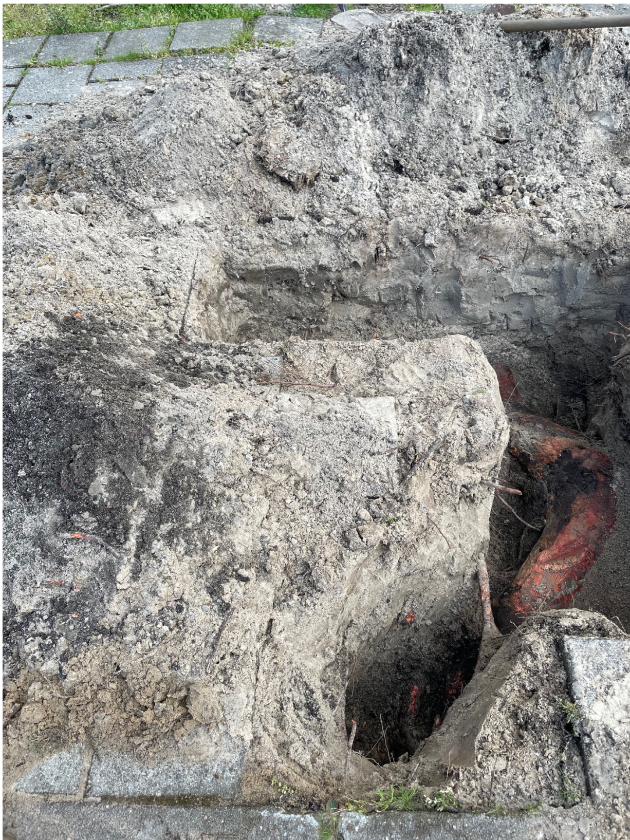
Foto 7: Bovenaanzicht van de hoofdwortel met bovenaan de grasbegroeiing van de boomspiegel. Deze hoofdwortel doorzagen is de stabiliteit van de boom aantasten.
