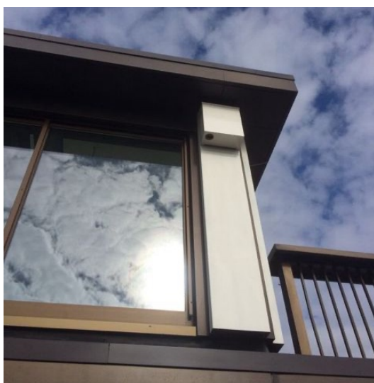
Voorbeelden van gierzwaluwkasten. Links een maatwerk kast aan de gevel zodanig ontworpen dat deze vanaf maaiveld weinig zichtbaar is en geen afbreuk doet aan het ontwerp, rechts inbouwkasten.
