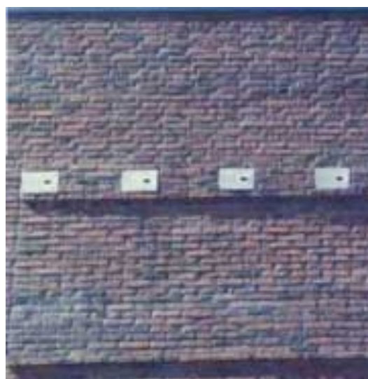
Voorbeelden van gierzwaluwkasten. Links een maatwerk kast aan de gevel zodanig ontworpen dat deze vanaf maaiveld weinig zichtbaar is en geen afbreuk doet aan het ontwerp, rechts inbouwkasten.
