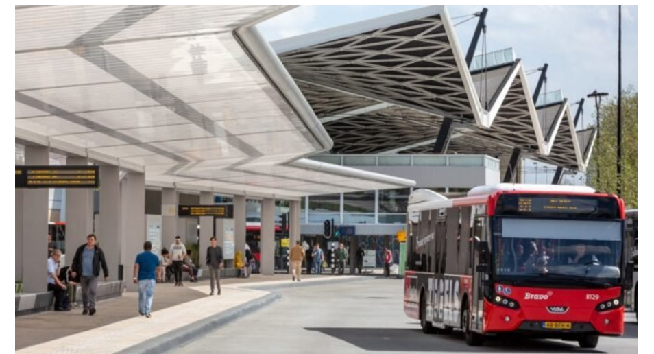
5.2: Busstation Tilburg: sprekende dakvorm
